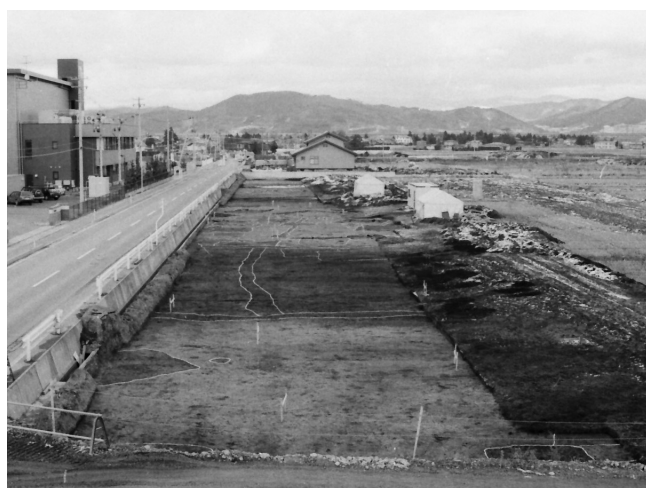
第1次調査C区全景(西から)
