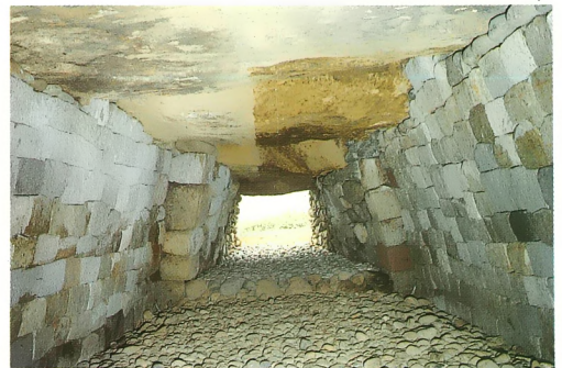
●復元された石室内部
