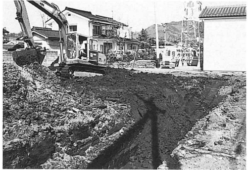
6 Bトレンチ埋め戻し状況 (南西より)
