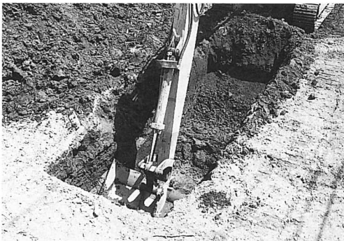
2 Bトレンチ深掘り状況 (南西より)
