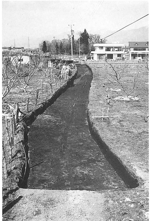
4 Bトレンチ完堀状況（北方より）
