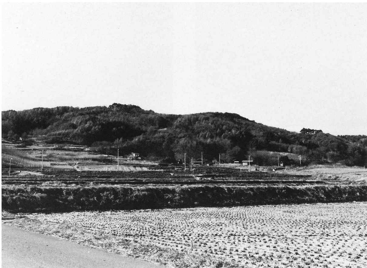
1. 瀧の峯古墳群遠景（東方より）
