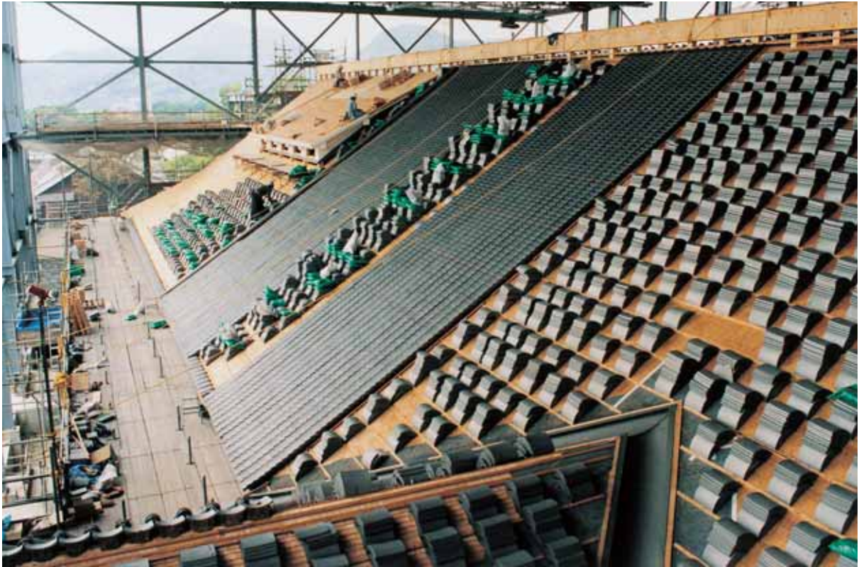
27. 広間棟 瓦葺 南東より見る
