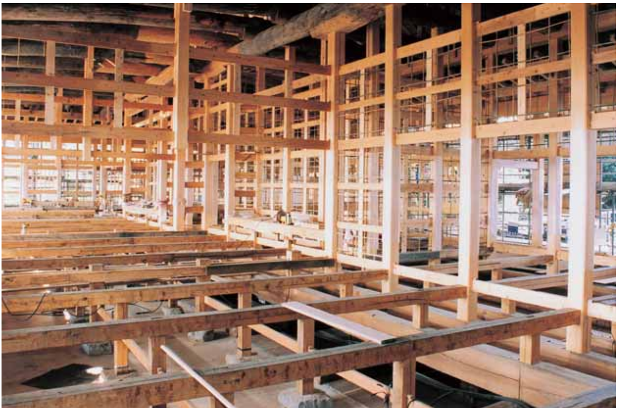
24. 広間棟 軸組内部 南東隅より見る
