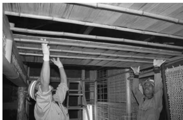
写真：木-6 野根板天井取付け
