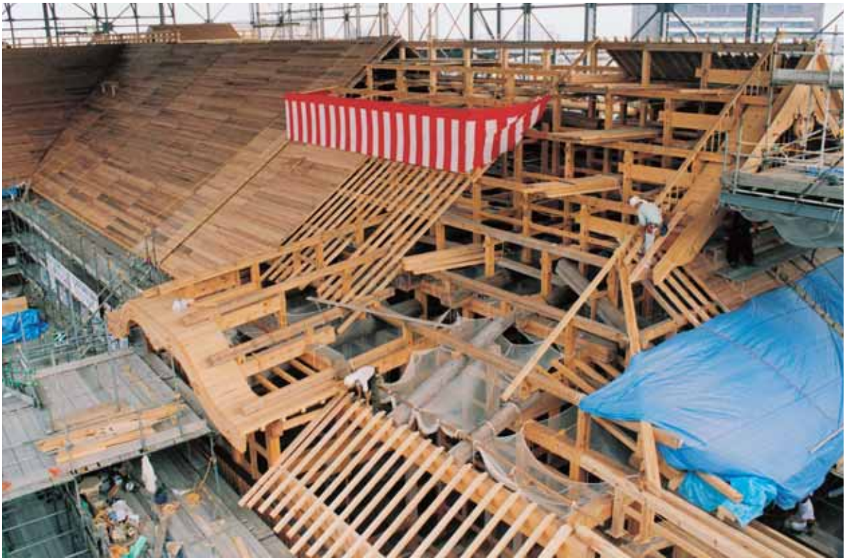
25. 広間棟 野地組立 上棟祭直前、北西より見る
