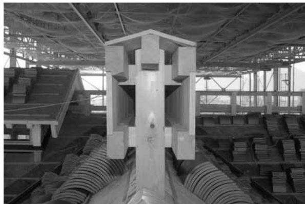
写真：屋-8 広間棟箱棟断面
