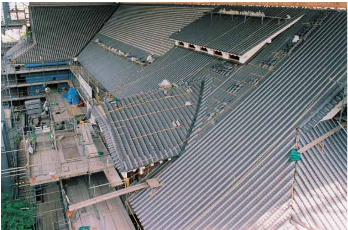
28. 広間棟・台所棟 瓦葺・目地漆喰塗 北西より見る
