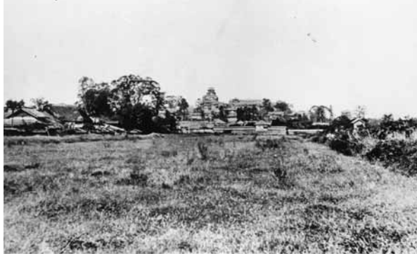
↓大広間棟屋根 ↓大台所棟南妻
