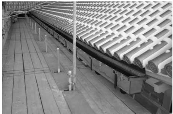
写真：屋-16 軒樋設置
