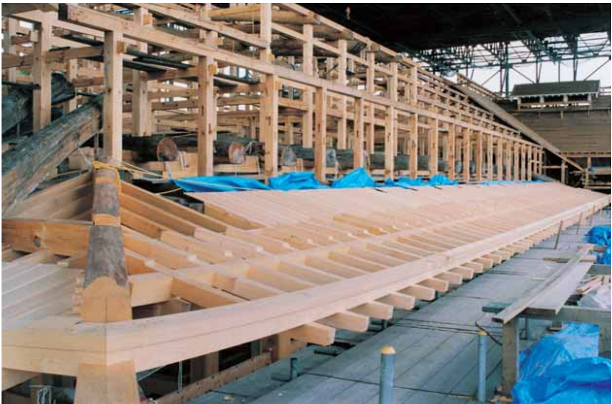
22. 広間棟 軒廻り組立 南西より見る
