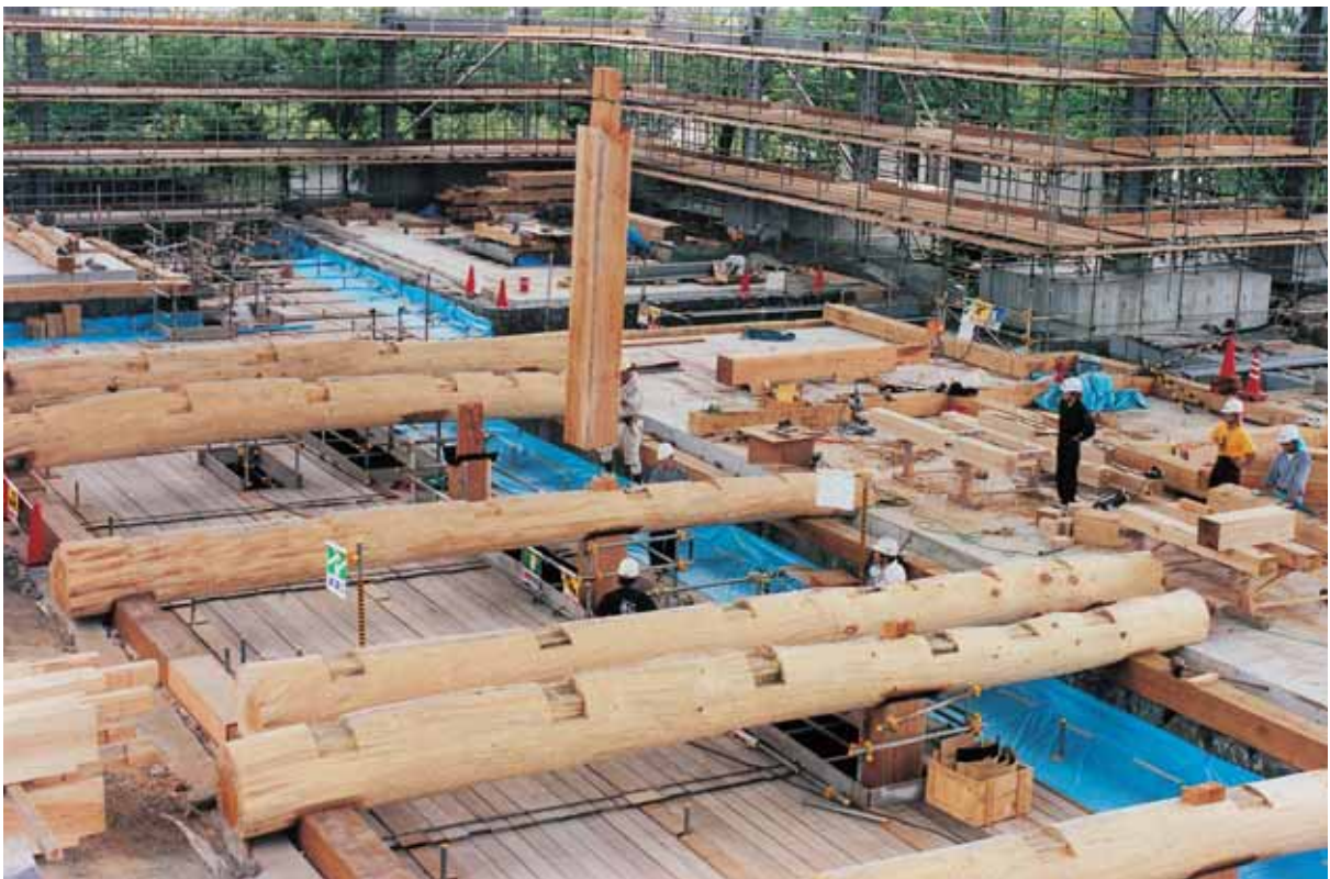
8. 地梁据え付け、地階柱搬入・据え付け 西から東を見る
