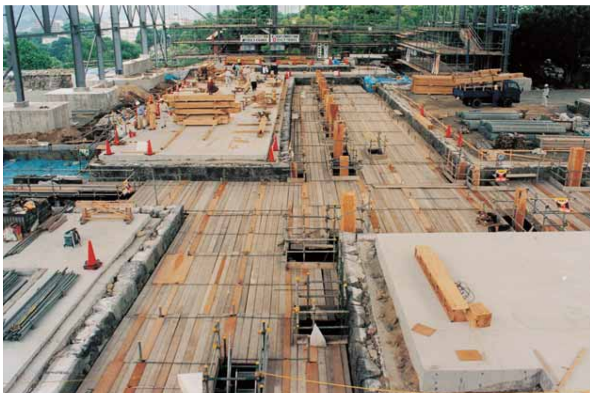
6. 一階床下コンクリートスラブ 東から西を見る
