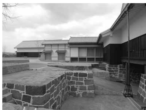
6. 閣通路スロープ（四辻出口）
