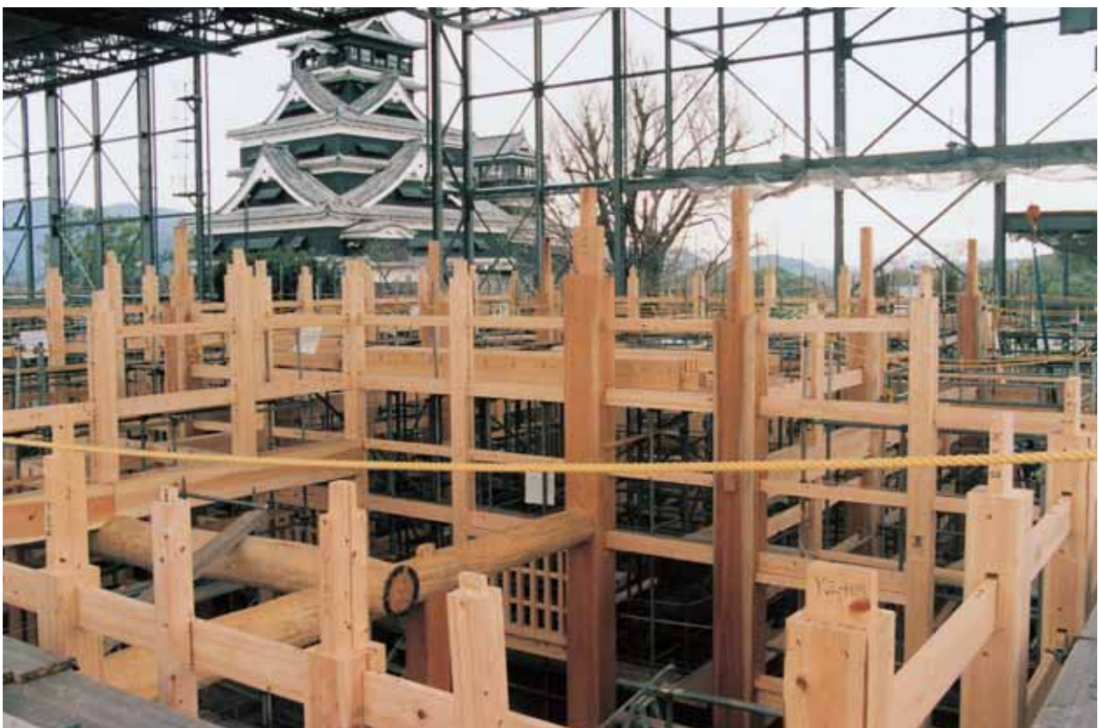
10. 台所棟 軸組の組立 南東より北西を見る
