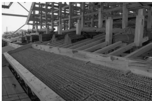
写真：左-7 軒揚げ裏の小舞搔（小舞縄巻き竹打ち）
