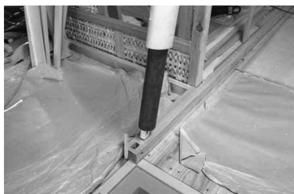
写真：木-5 中柱足下仕口（ホゾ差し込み栓止め）
