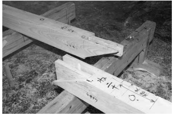
写真：木-15 茅負継手(芒継)
