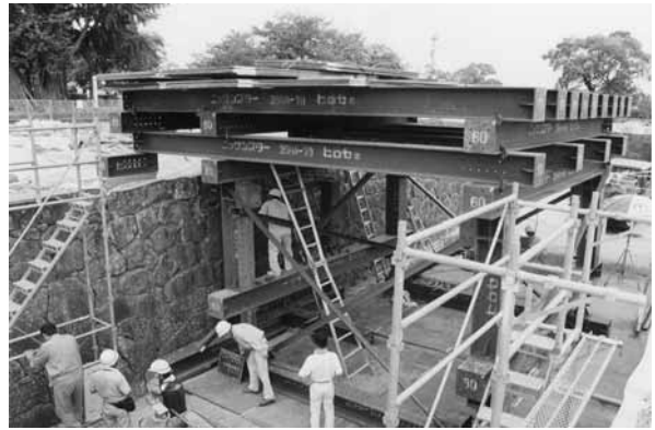
組立が完了した載荷台 載荷用鋼板47.4t、載荷台まで含め全体で約80t。
