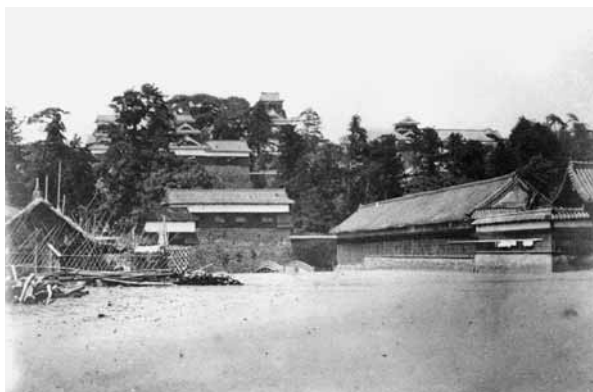
煙り抜き屋根↓ ↓大台所棟南妻
