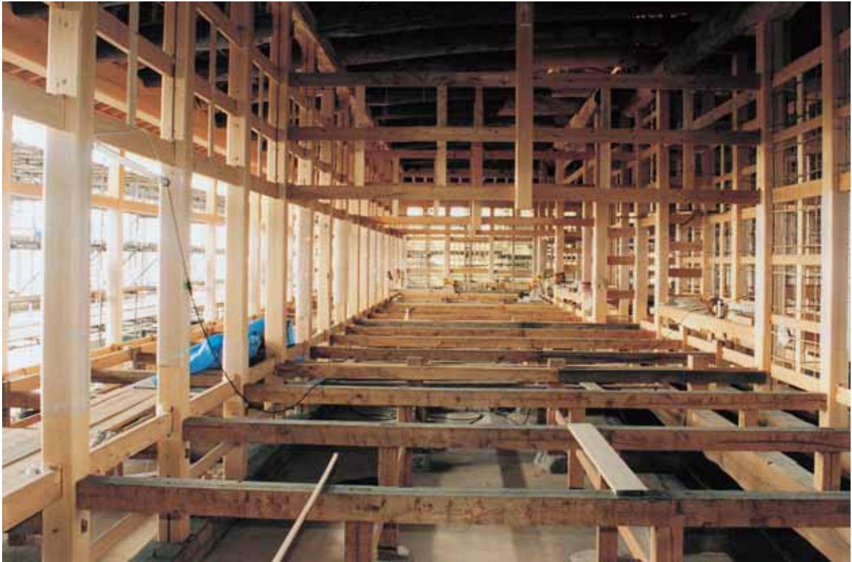
23. 広間棟 軸組内部 東より見る
