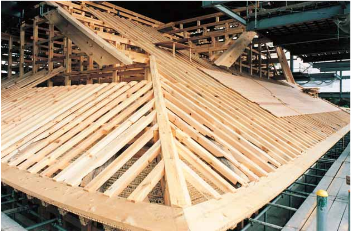
17. 台所棟 野地・破風板の組立 南東より見る
