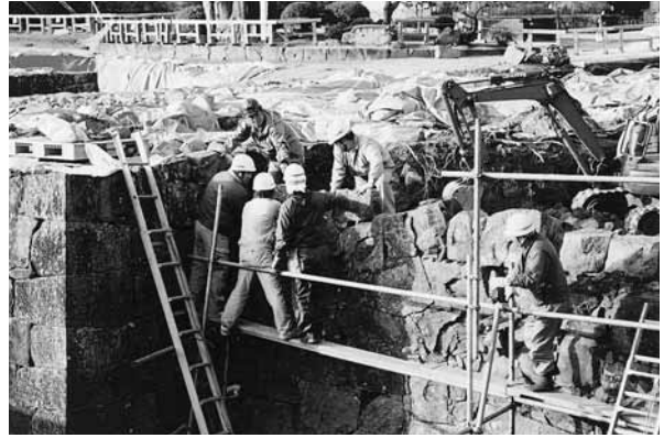
解体状況（北側・南面）
