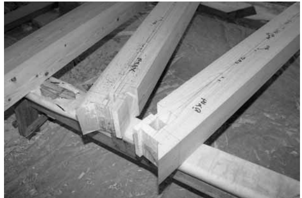
写真：木-16 階段土台仕口(台輪留)
