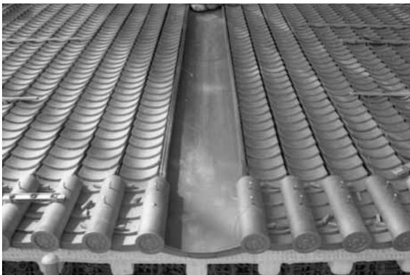
写真：屋-14 台所棟東面谷筋施工状況
