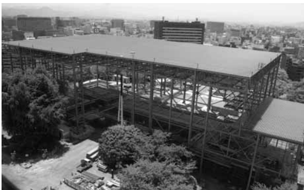
写真：仮-4 素屋根建設完了
