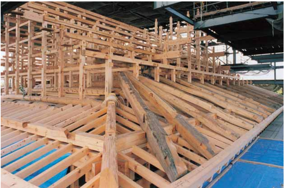
14. 台所棟 小屋組材の組立 南東隅より見る
