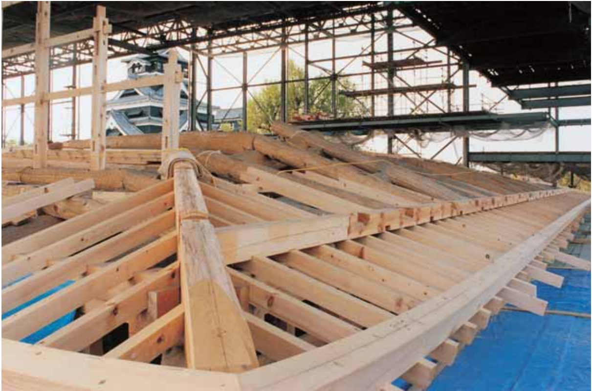
13. 台所棟 軒廻り材の組立 南東隅より見る
