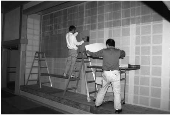
写真：表-3 床壁の胴張り（下地は骨縛り）
