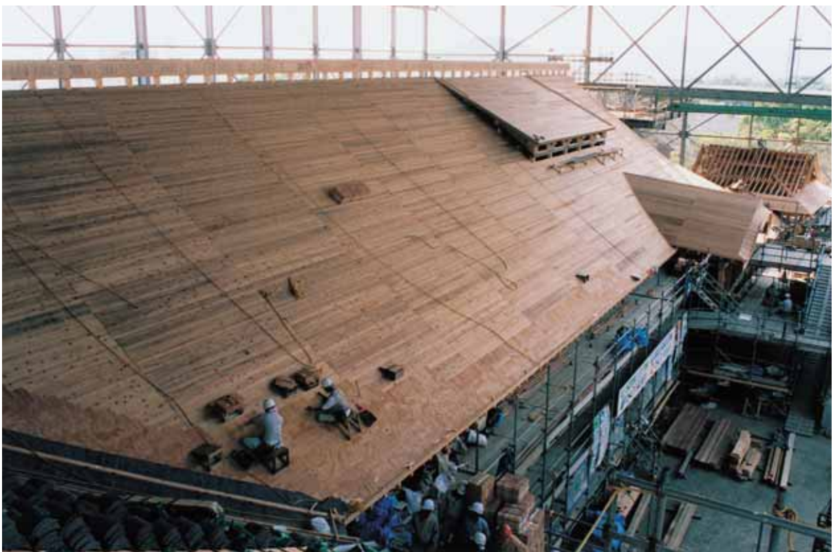
26. 広間棟 野地・土居葺き 北東より見る
