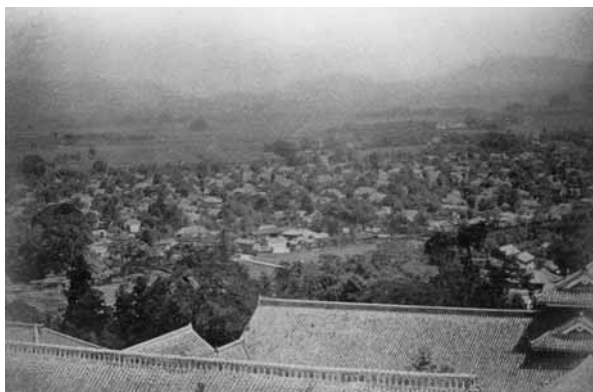
↓ 麒麟・長之間棟屋根 ↓ 小広間棟屋根
