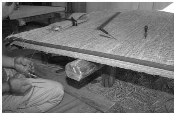
写真：雑-3 頭板（プラスチック製）取付け
