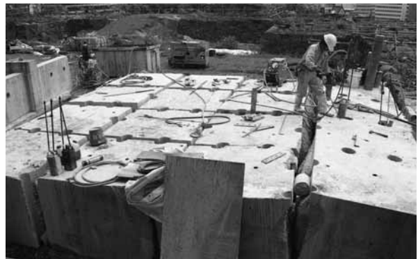
写真：仮-7 パースター工法による基礎の分割
