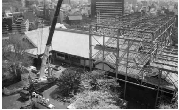
写真：仮-5 素屋根解体中
