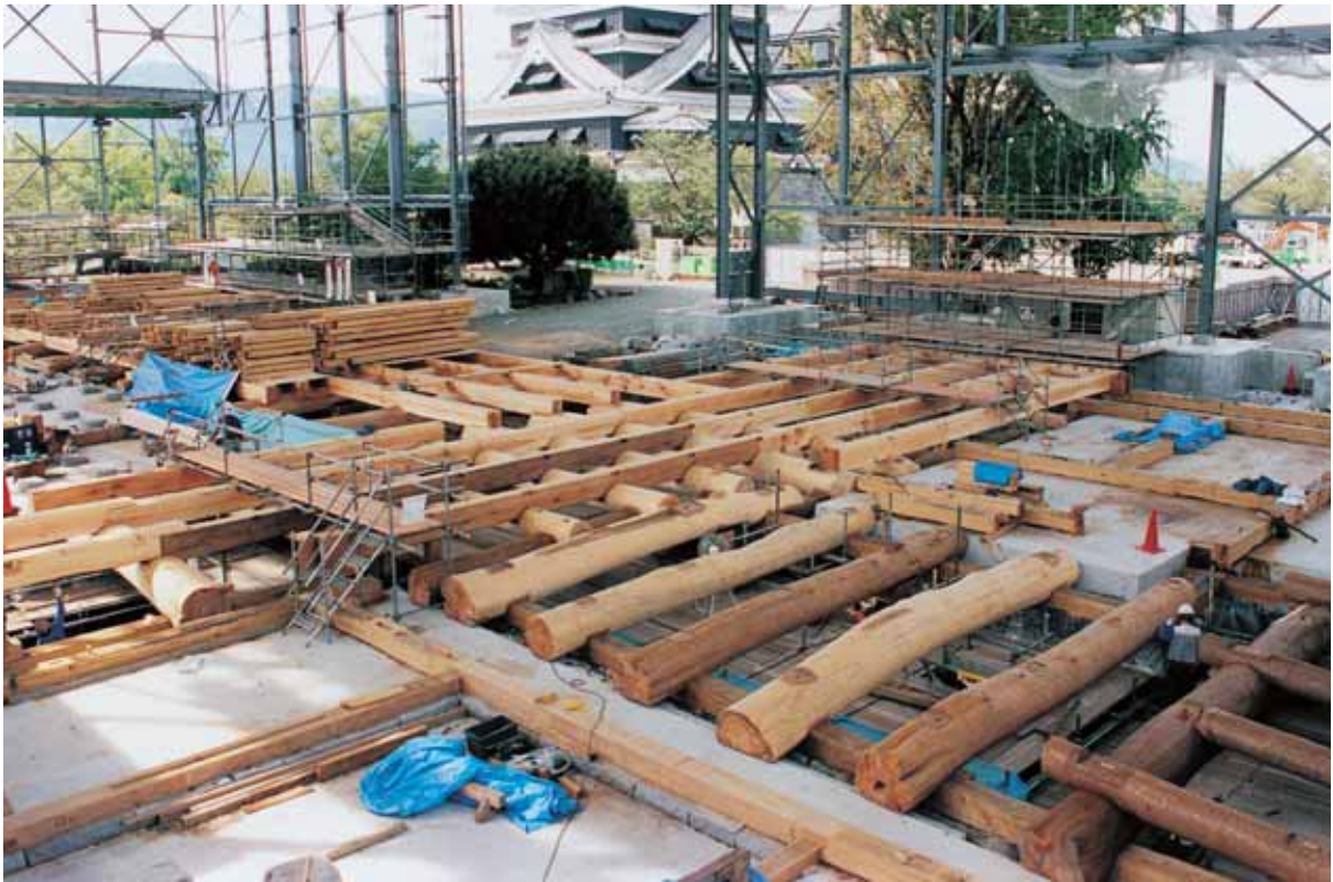
9. 土台・地梁・柱踏み組立 南東より北西を見る
