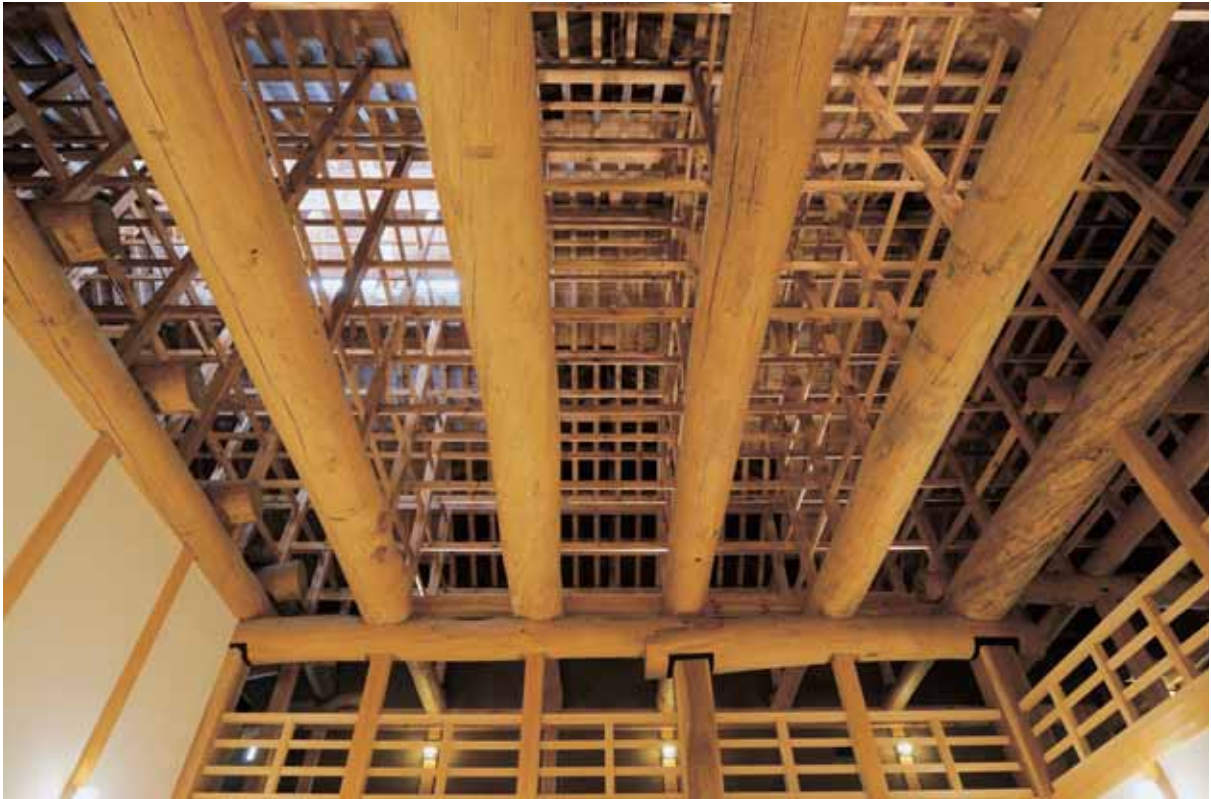
25. 大御台所（小屋組見上げ）
