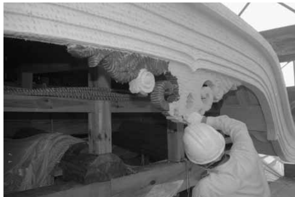
写真：左-4 兎の毛通し漆喰塗荒付け
