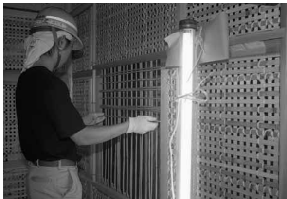
写真：左-8 下地窓の施工
