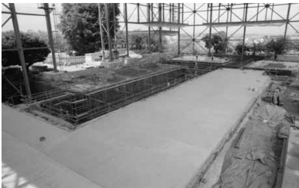
写真：基-6 広間棟基礎盤設置
