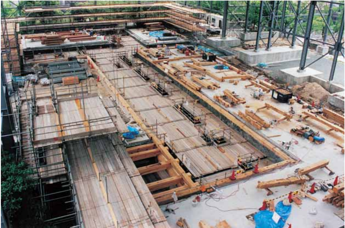
7. 石垣上土台据え付け 西から東を見る
