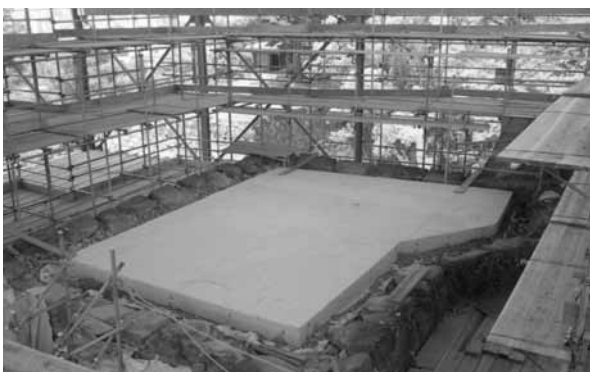
写真：基-7 数寄屋棟基礎盤設置状況
