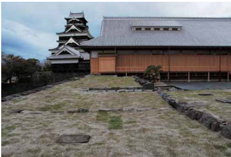
西の廊下付近
