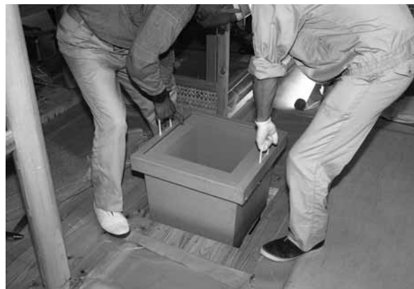
写真：左-13 炉壇の据付
