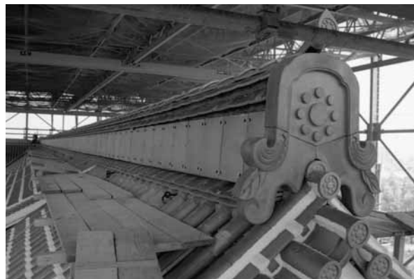
写真：屋-9 広間棟大棟瓦葺
