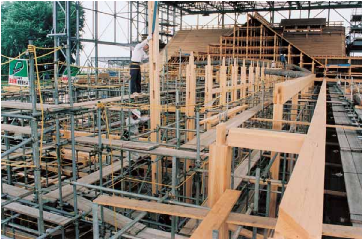
19. 広間棟 軸部の組立 南西より見る
