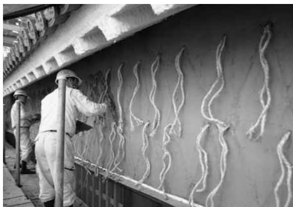
写真：左-2 下縄の塗り込み
