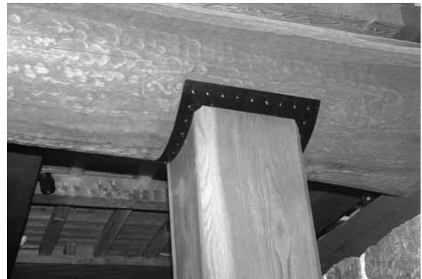
写真：木-31 敷金物設置
