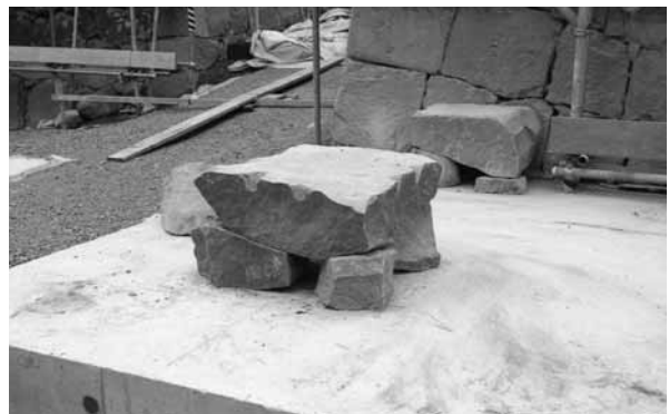
写真：基-9 閣通路柱礎石設置
