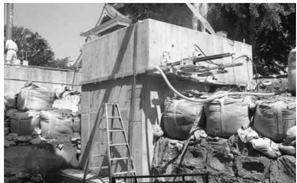
写真：仮-8 ワイヤソー工法による基礎の分割
