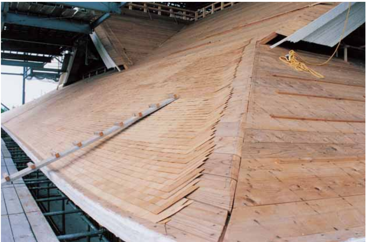
18. 台所棟 野地板張り・土居葺き 北東隅より見る
