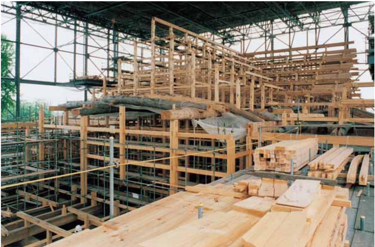
16. 台所棟・広間棟の接続部小屋組 南西より見る
