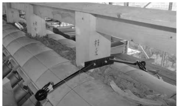
写真：屋-19 台所環金物設置
