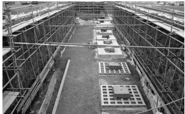
写真：基-8 閣通路基礎設置
