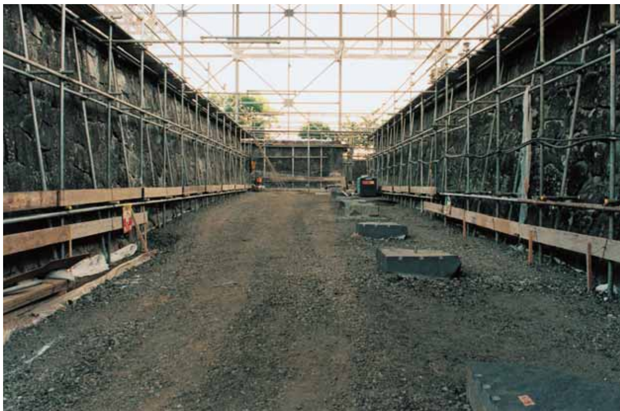
5. 間り通路基礎石据え付け 西から四辻を見る
