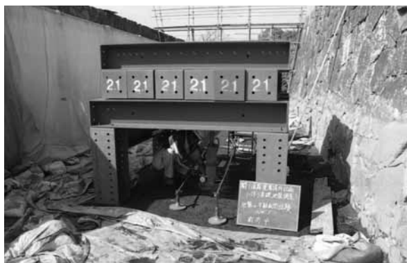
載荷試験実施状況
