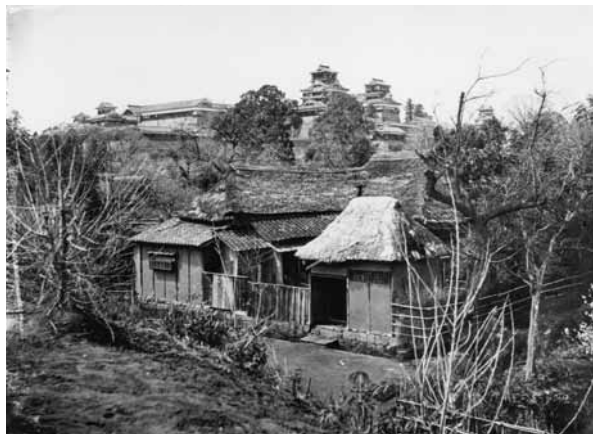
↓大台所棟東妻面 大台所棟南北屋根↓
