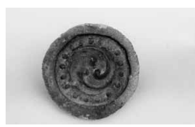
25.軒丸瓦(菊丸瓦) 数寄屋棟の棟積みに使用
