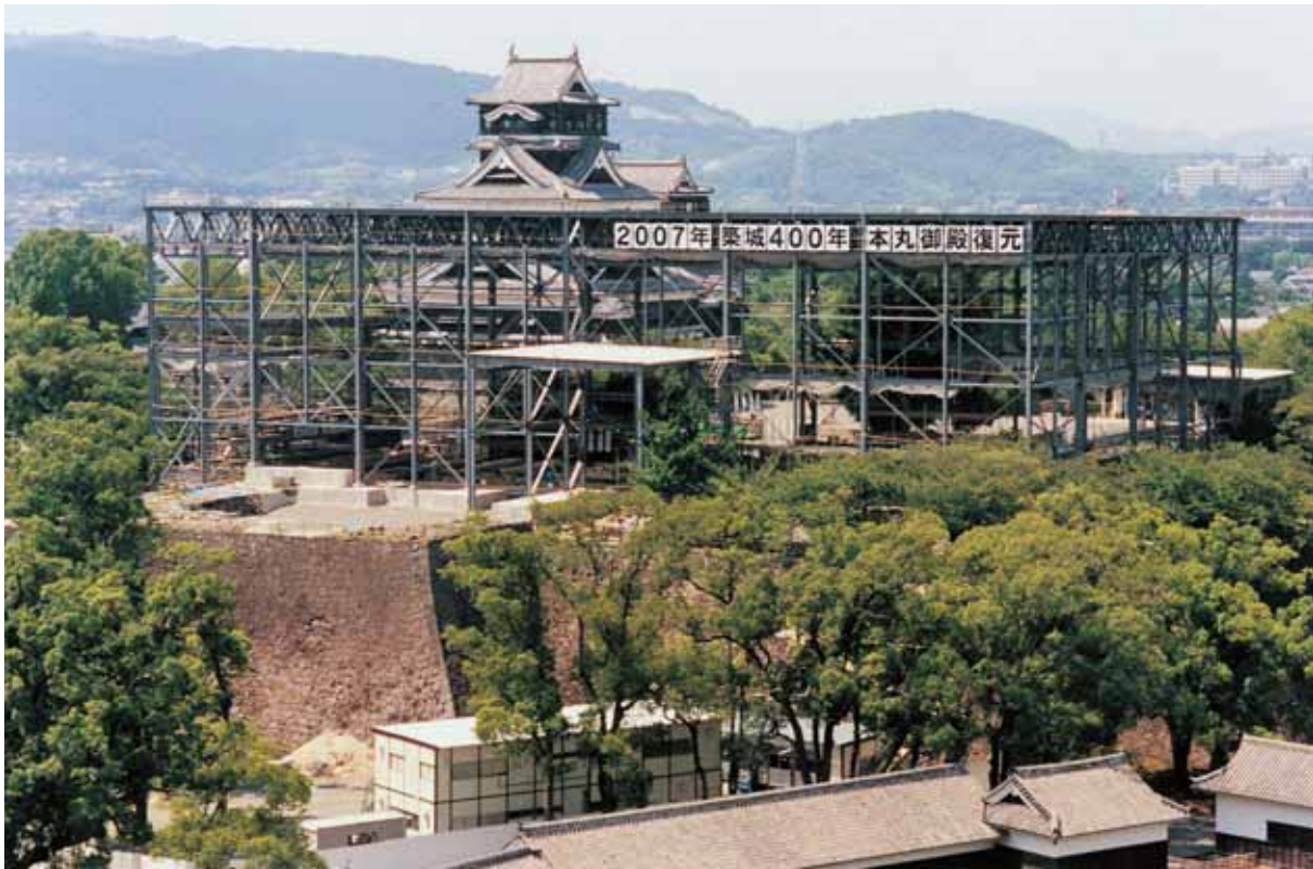
3. 工事中素屋根 市役所屋上より見る
