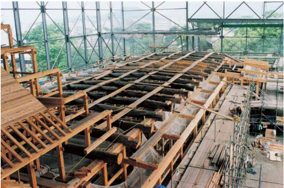
20. 広間棟 小屋梁 北東より見る
