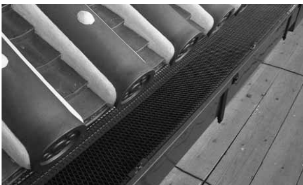
写真：屋-18 軒樋防葉網設置
