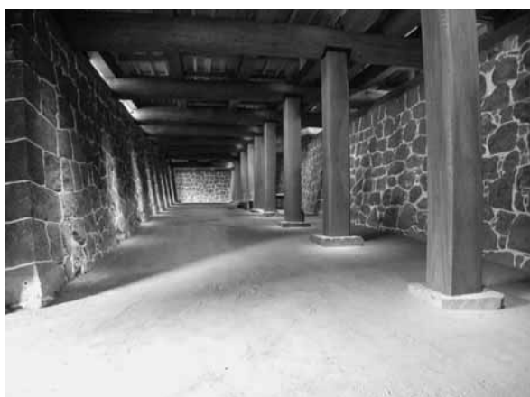
闇通路のスロープ
