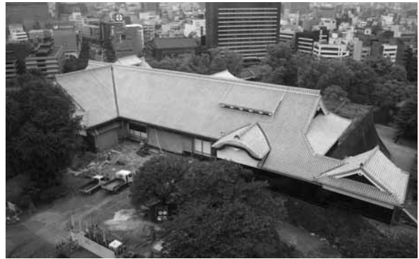
写真：仮-6 素屋根解体完了
