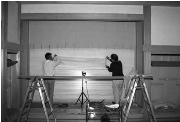
写真：表-4 床壁の葺掛け
