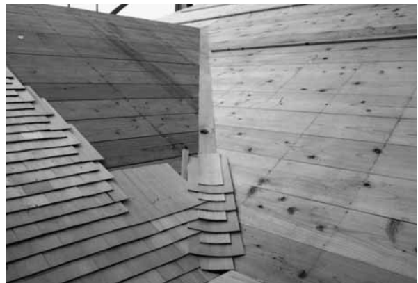
写真：屋-4 土居葺 谷部の納まり
