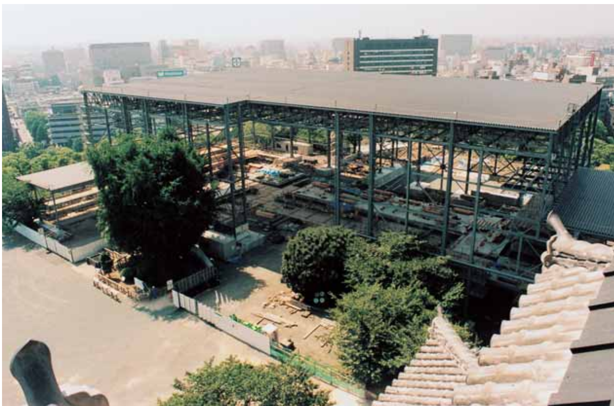
4. 工事中素屋根 大天守より見る
