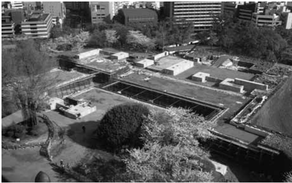
写真：仮-2 素屋根基礎設置
