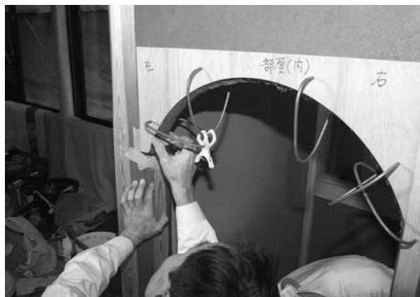
写真：左-11 給仕口曲線部の施工
