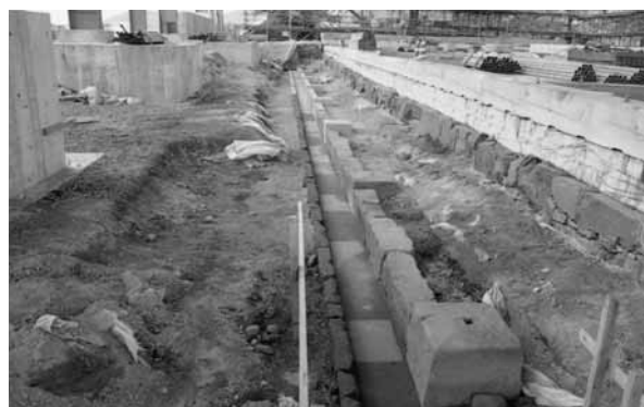
写真：基-3 広間南雨落側溝補修完了
