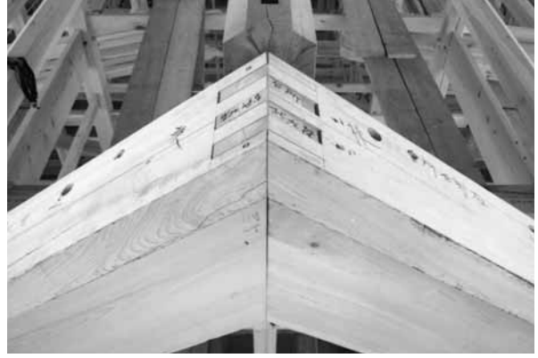
写真：木-13 破風拜部仕口(組手継)
