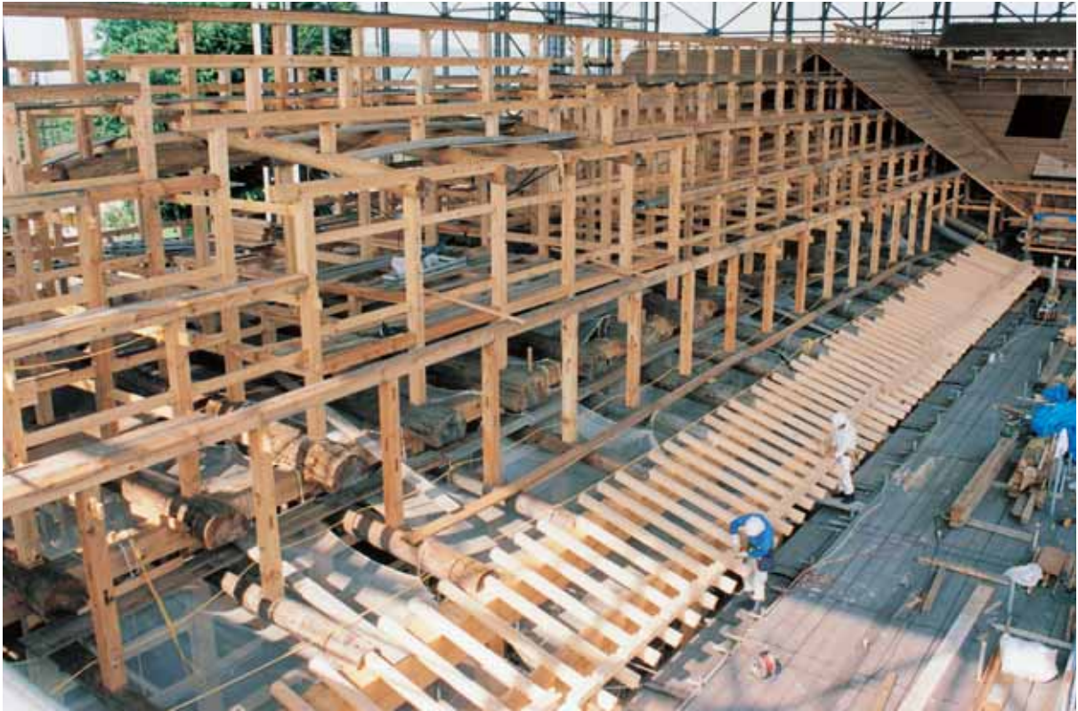
21. 広間棟 小屋組 地垂木組立 南西より見る
