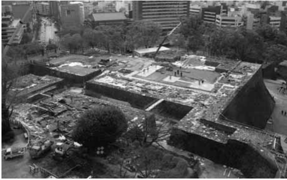
写真：仮-1 素屋根建設前
