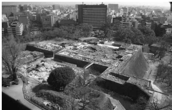
本丸御殿建設地
