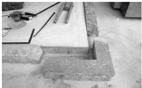
写真：基-10 台所土間内部見えがかり礎石
