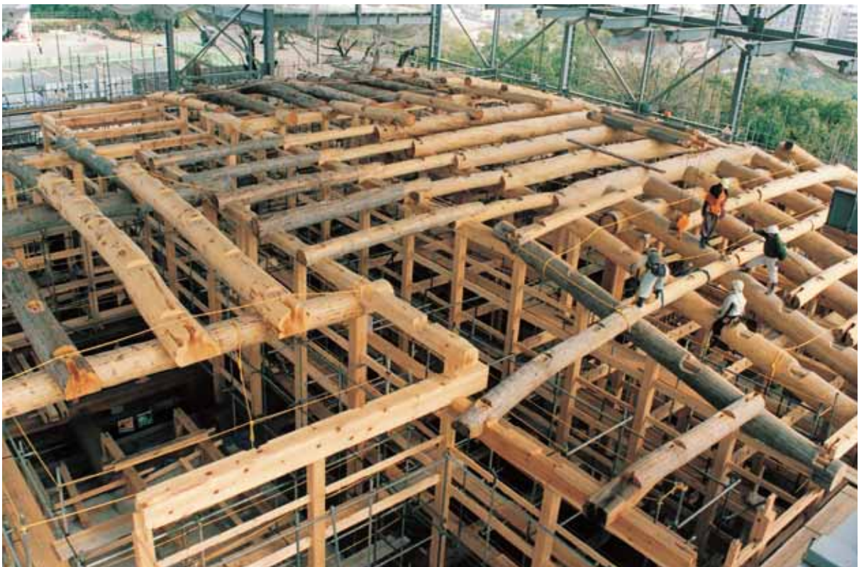
12. 台所棟 小屋梁組立 南西より見る
