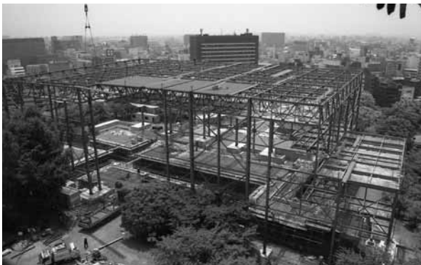
写真：仮-3 素屋根建設中
