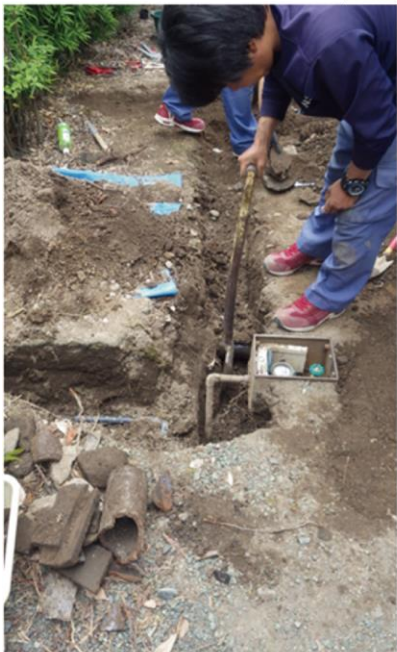
水道管掘削状況
