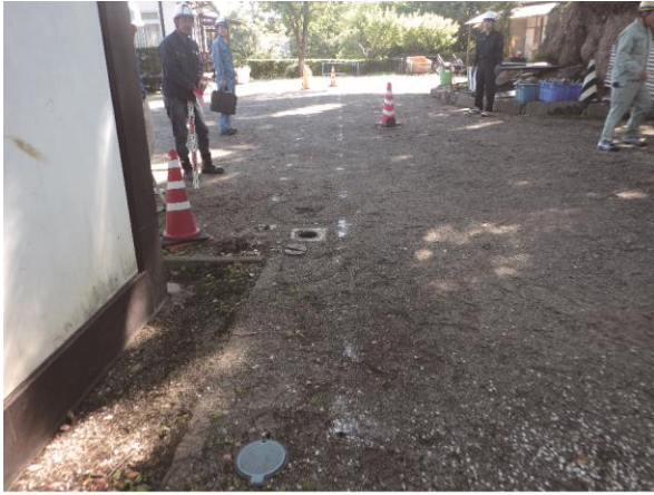
1 地点 掘削前状況 西から
