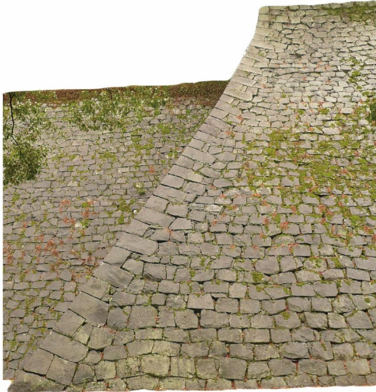
17-① 1796年（寛政8）方形石材で横目地通りやすい、部分的に谷積みあり 慶長前半期頃の石垣（非方形石材で横目地通りにくい）に対して修復
