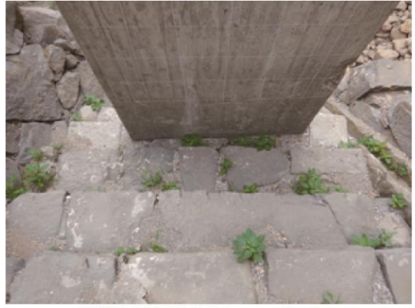
橋脚中段掘削前状況 西から
