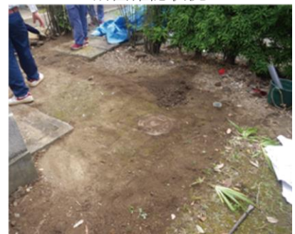
埋め戻し完了状況
