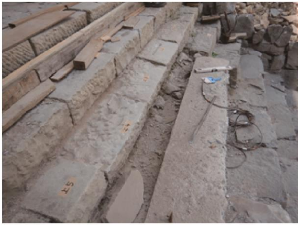
橋脚上段掘削前状況 南から
