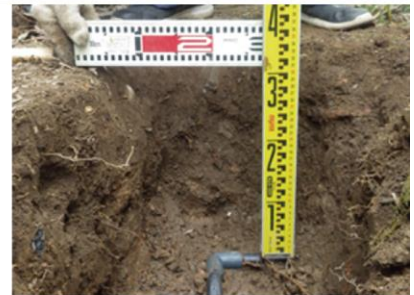
断面確認状況
