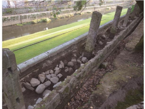
トレンチ15完掘状況 北東から
