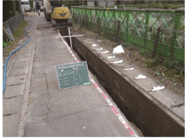
掘削状況 西から
