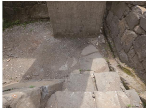
橋脚下段西側掘削前状況 西から
