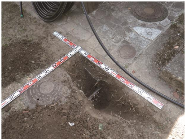
C地点状況 北西から
