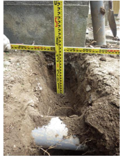
断面確認状況
