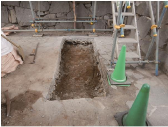
支持力試験箇所掘削前状況 北から
