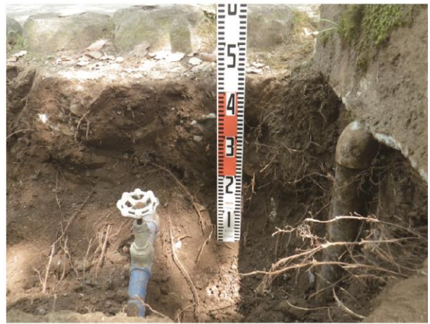
B地点土層断面状況 西から
