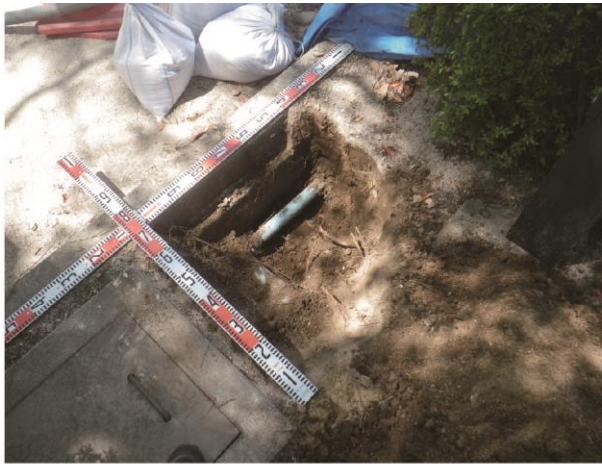
A地点状況 南東から
