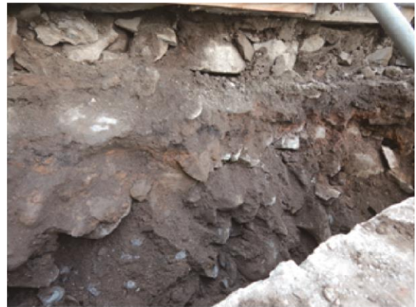
橋脚上段西壁断面近景 南東から
