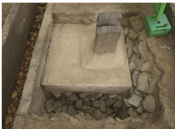
6トレンチ(控柱No.17) 全景 西から
