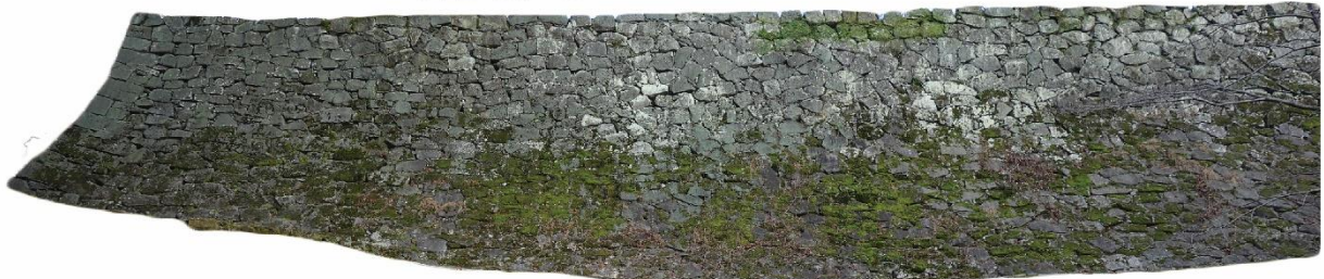
17-① 1796年（寛政8）方形石材で横目地通りやすい、部分的に谷積みあり 慶長前半期頃の石垣（非方形石材で横目地通りにくい）に対して修復
