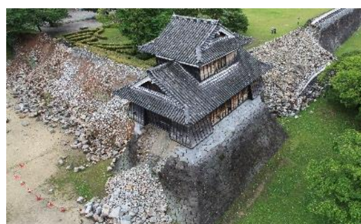
写真-2 崩壊の様子 1)
