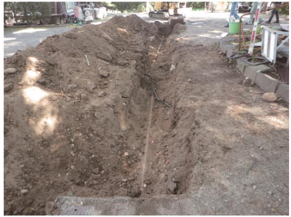
1 地点 掘削後状況 西から
