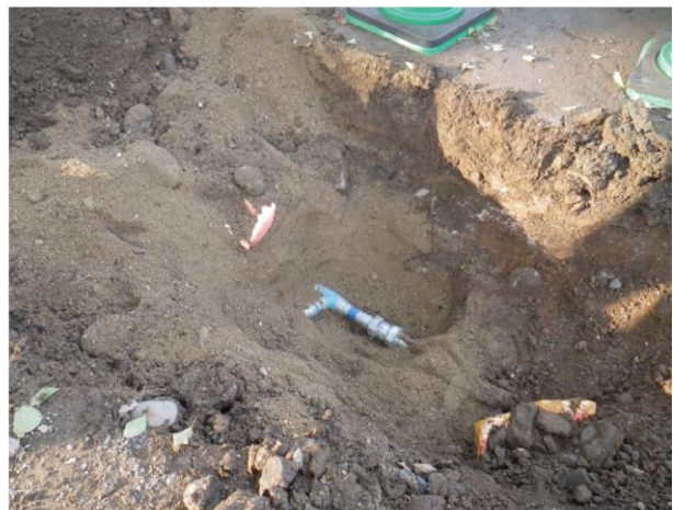
G地点土層断面 南から
