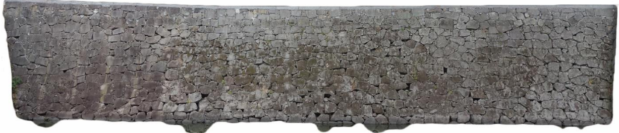
16-② 1790年（寛政2）方形石材で横目地通りやすい 慶長後半期頃の石垣（方形石材で横目地通りやすい）に対して修復 ※修復境を見出しにくい
