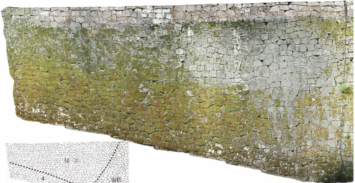
4 1649年（慶安2）長方形石材で地形に即した横目地あり 10-2 1719年（享保4）正方形石材で水平横目地あり 慶長前半期頃の石垣（非方形石材で横目地通りにくい）に対して修復
