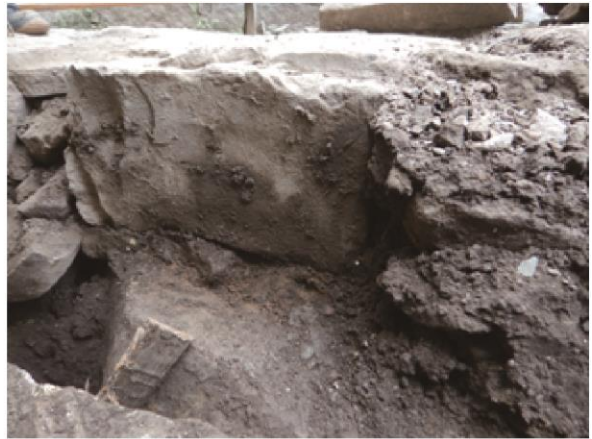
橋脚下段石敷き下部状況 東から
