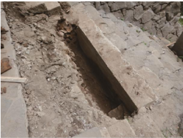
橋脚上段掘削後状況 南西から
