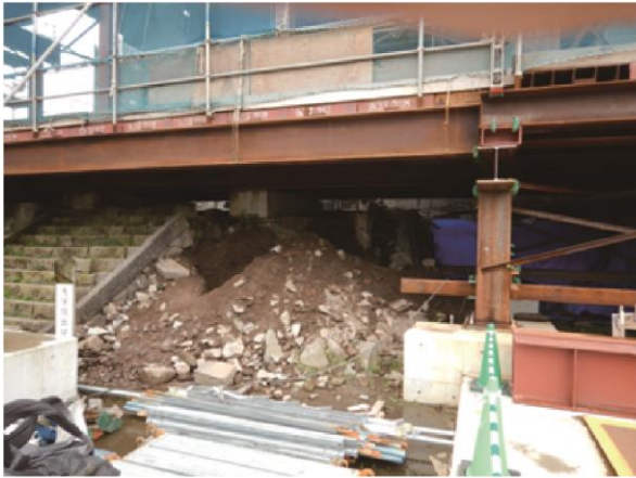
調査前現況 東から
