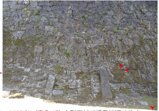
2 1640年（寛永17）方形石材で横目地通りやすい慶長後半期頃の石垣（方形石材で横目地通りやすい）に補強石垣として増築【赤矢印】
