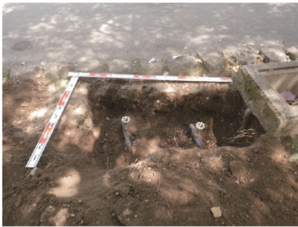
B地点状況 西から
