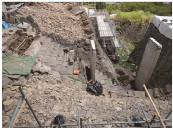
橋脚掘削後全景状況 南から
