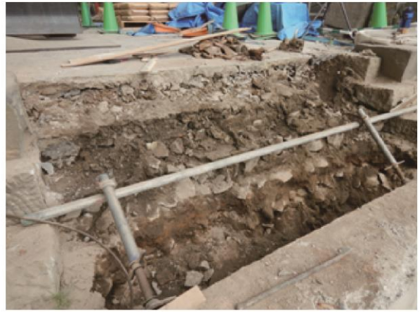
橋脚上段石段解体状況 南東から
