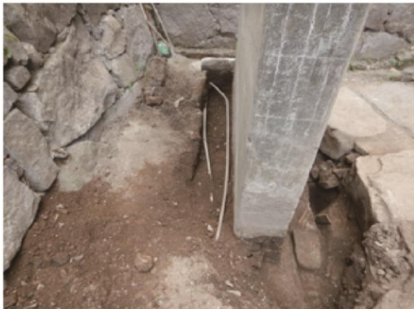
橋脚下段東側掘削後状況 北から
