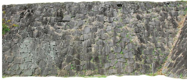
16-① 1790年（寛政2）方形石材で横目地通りやすい 慶長前半期頃の石垣（非方形石材で横目地通りにくい）に対して修復
