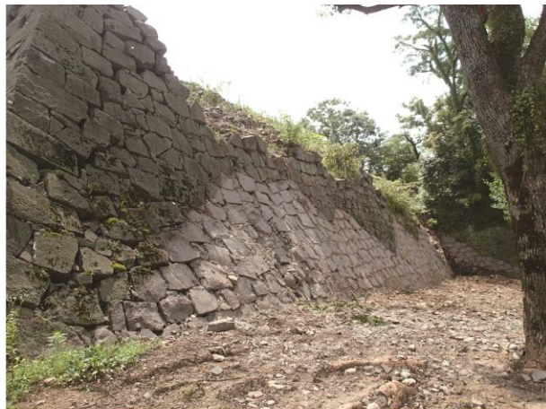
N34崩落石材回収後状況 北西から
