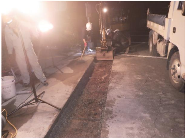
2 地点 掘削後状況 東から
