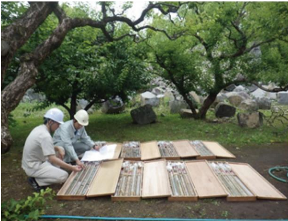
ボーリングコア現地確認
