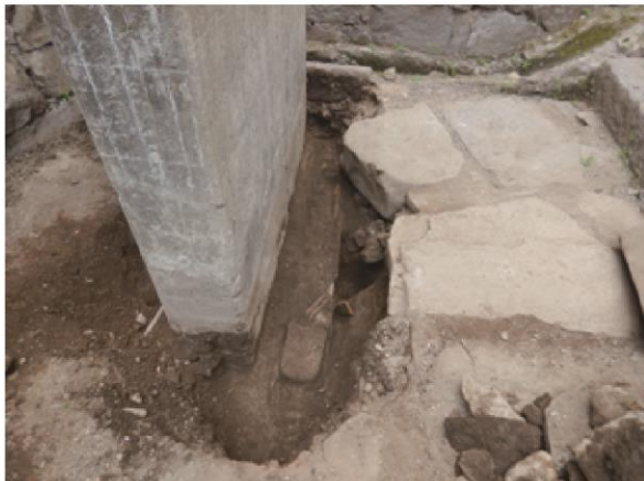
橋脚下段西側掘削後状況 北から
