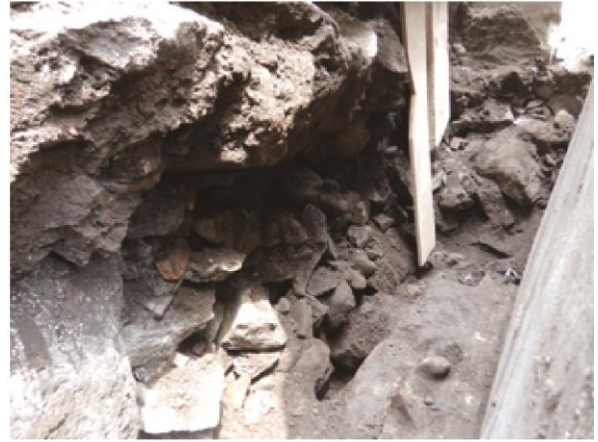
橋脚中段西壁断面状況 南東から
