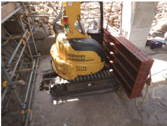
支持力試験状況 東から
