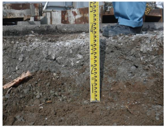
D地点土層断面 東から
