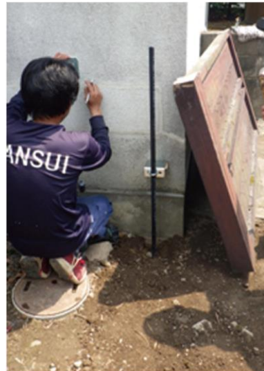
水道管を地上に立ち上げ新設
