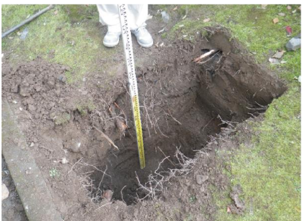
C地点掘削状況 南から
