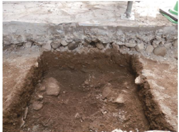
支持力試験箇所西壁断面状況 東から
