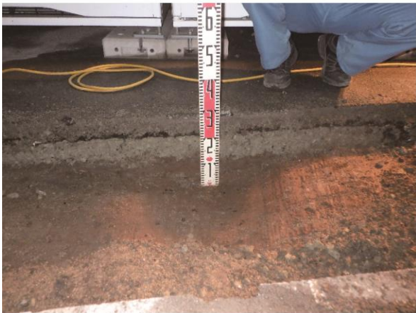
2 地点 掘削土層把握状況 北から
