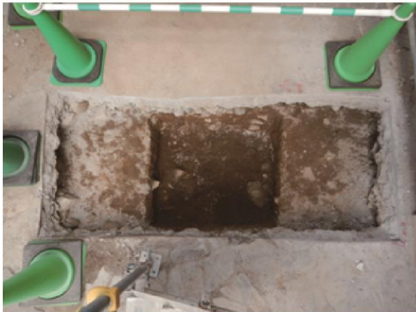
支持力試験箇所掘削前状況 西から
