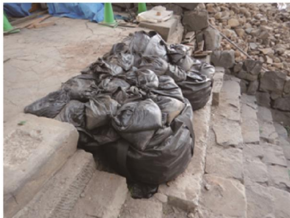
橋脚上段仮埋め戻し状況 南東から
