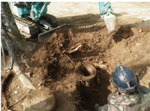
B地点掘削状況 東から
