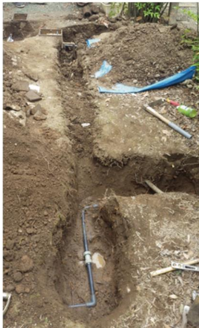
水道管掘削状況 北から
