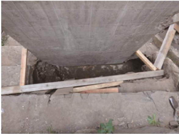
橋脚中段掘削後状況 西から
