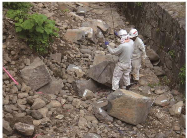
不開門虎口崩落築石回収状況 南東から
