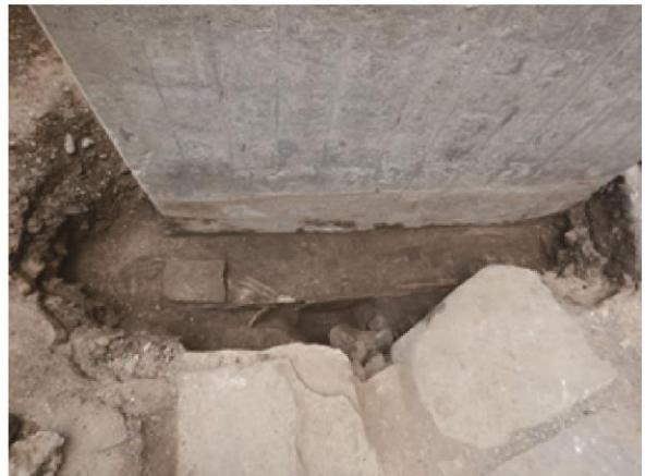
橋脚下段西側掘削後状況 西から
