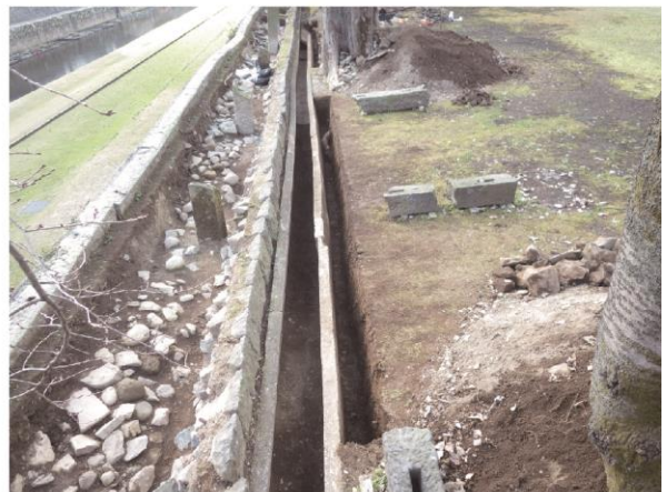
トレンチ9-3・9-2完掘状況 東から
