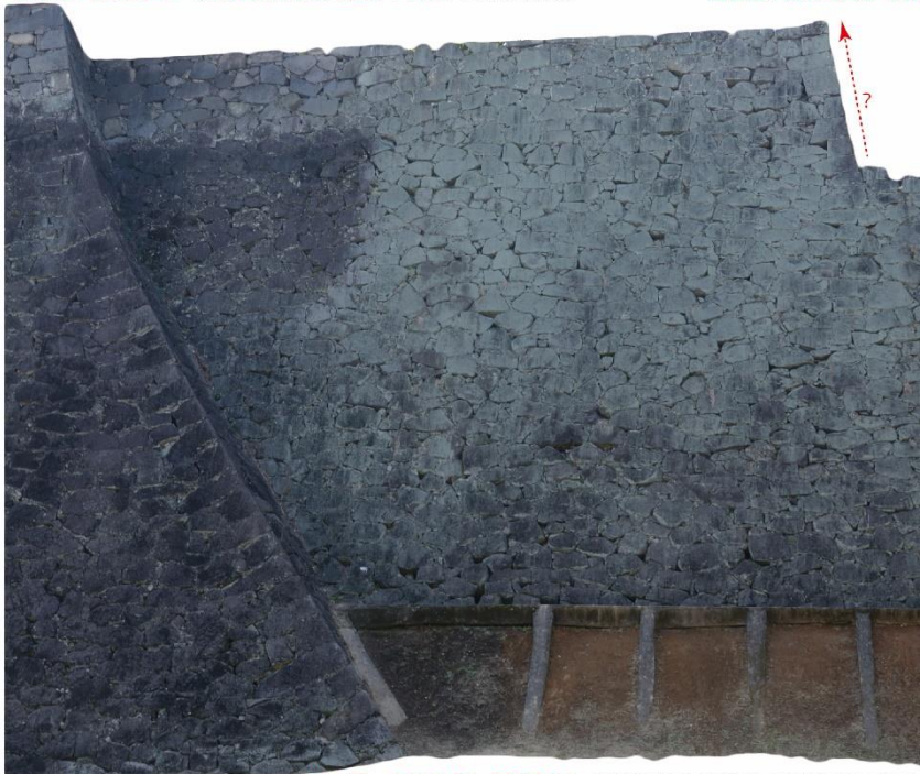
15-① 1782年(天明2) 非方形石材で横目地通りにくい 慶長前半期頃の石垣(非方形石材で横目地通りにくい)に対して修復 ※修復境を見出しにくい
