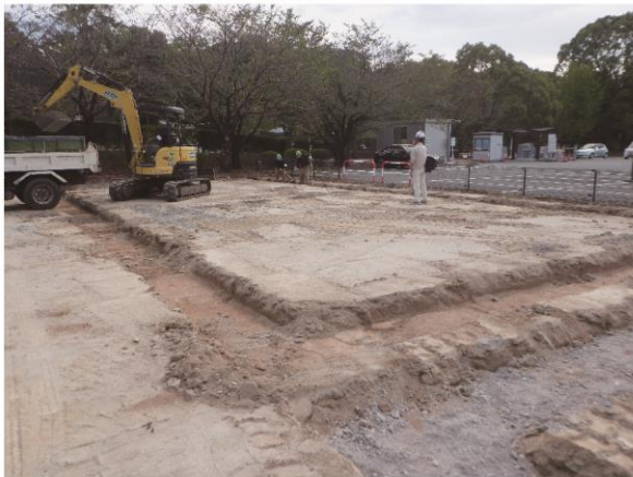
仮設物基礎掘削箇所全景 北東から
