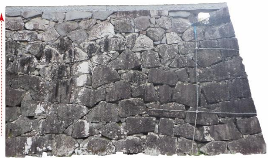
15-② 1782年(天明2) 非方形石材で横目地通りにくい 慶長後半期頃の石垣(方形石材で横目地通りやすい)に対して修復
