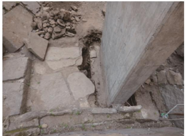
橋脚下段西側掘削後状況 南から
