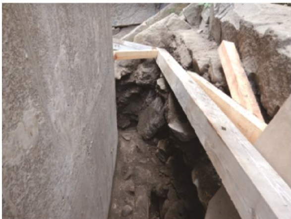
橋脚中段南壁断面状況 北から
