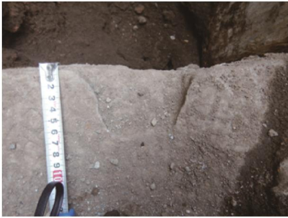
橋脚上段西壁検出石材の矢穴
