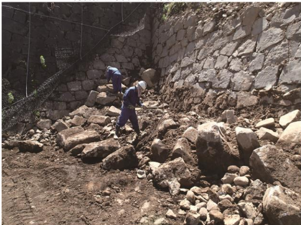
崩落土除去作業実施状況
