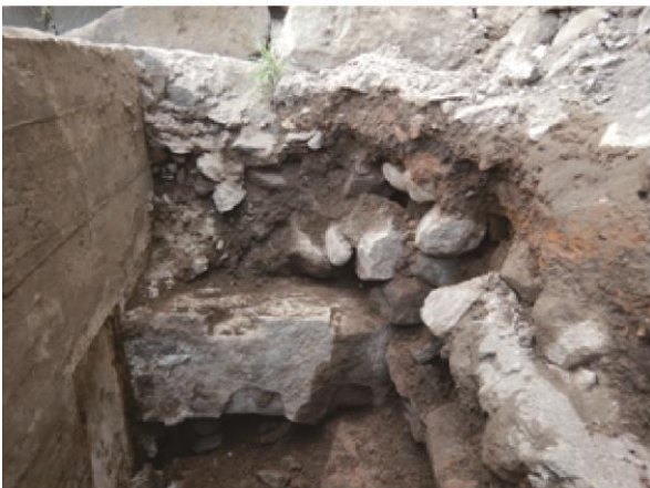
橋脚上段南壁断面状況 北から
