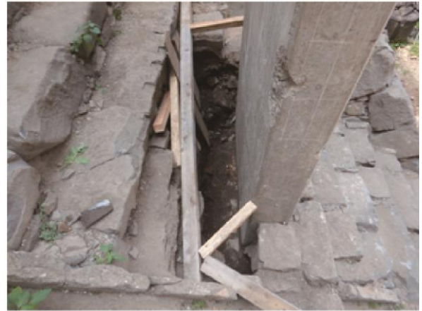
橋脚中段掘削後状況 南から
