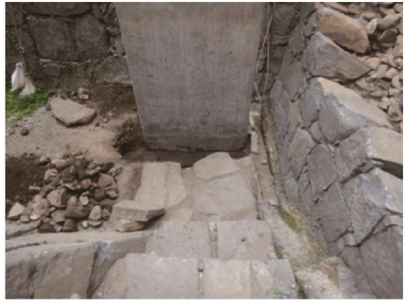
橋脚下段西側掘削後状況 西から
