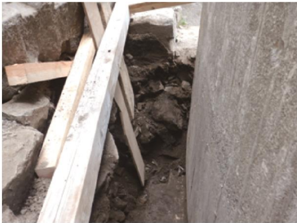
橋脚中段北壁断面状況 南から
