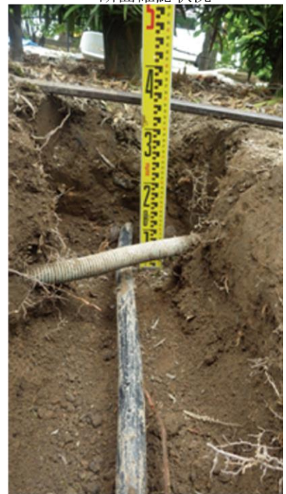
断面確認状況
