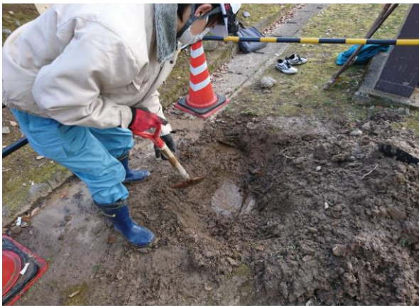
A地点掘削状況 北から
