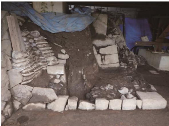
崩落石材回収状況 東から
