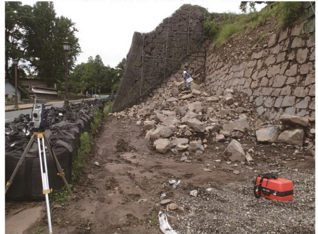
測量作業実施状況
