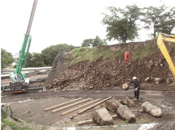
崩落石材回収作業実施状況
