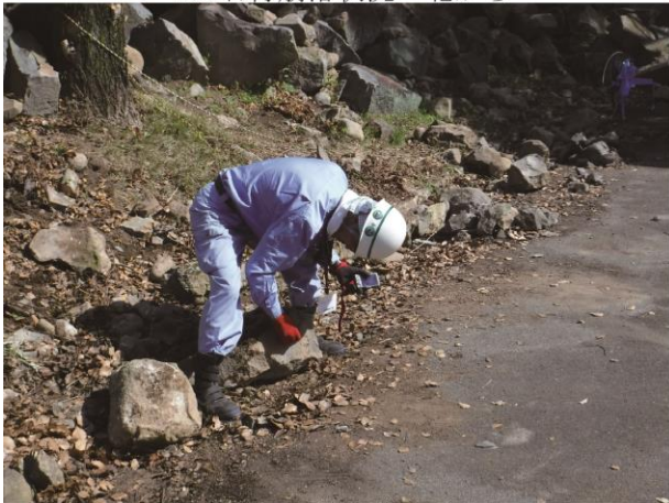
崩落石材番付作業実施状況
