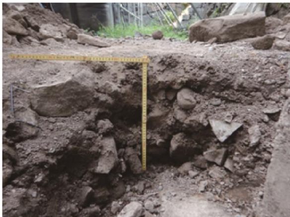
橋脚下段西側北壁断面状況 南から
