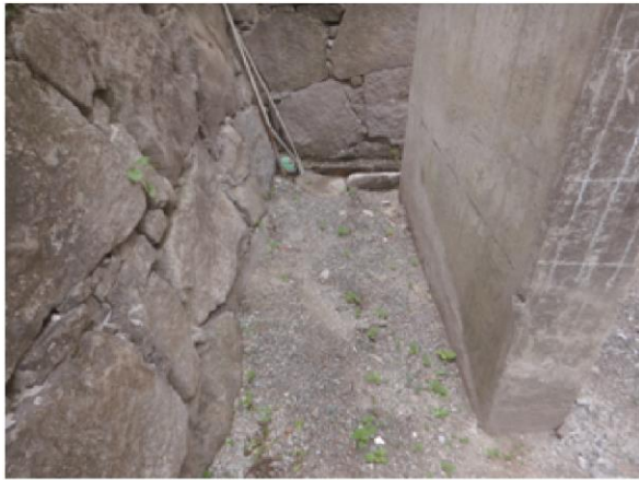
橋脚下段 東側掘削前状況 北から
