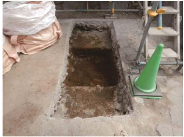
支持力試験箇所掘削後状況 北から
