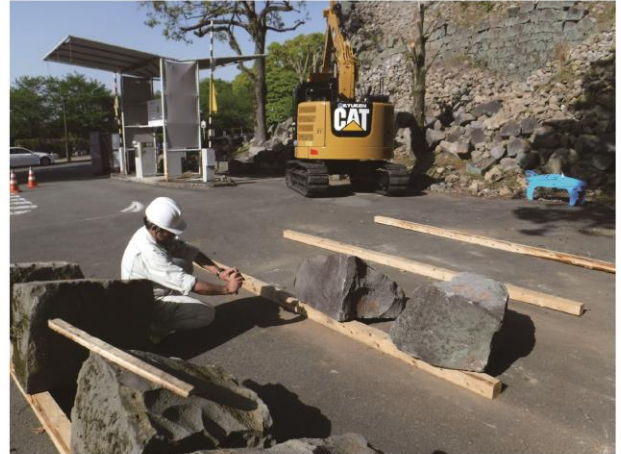
回収石材記録作業実施状況
