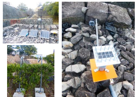
写真-2 各機器類の設置状況
