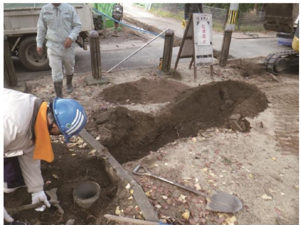
公園内部掘削状況
