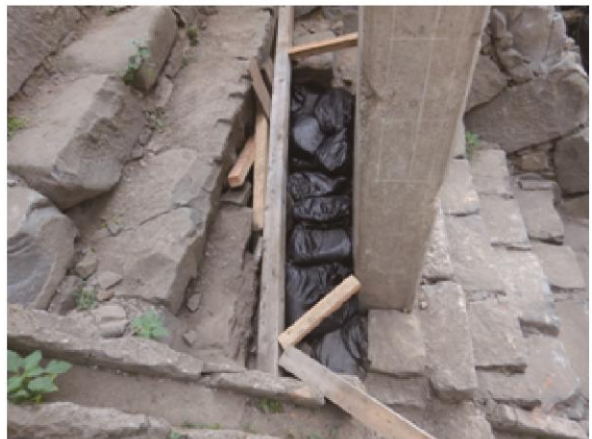
橋脚中段仮埋め戻し状況 南から
