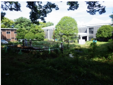
(16) 掘削箇所遠景
