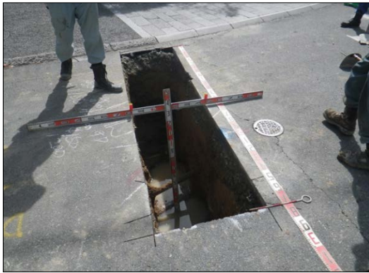
(14) No.1 トレンチ
