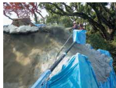
⑧モルタル吹付け
