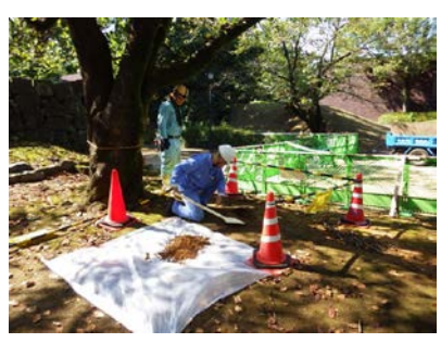
(11) ポイント1 掘削風景
