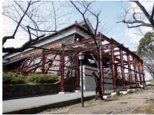
南大手門櫓門の倒壊防止工事
