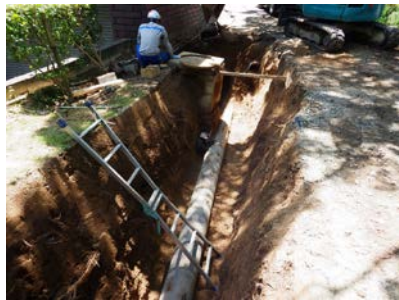
(6) 掘削風景 東から
