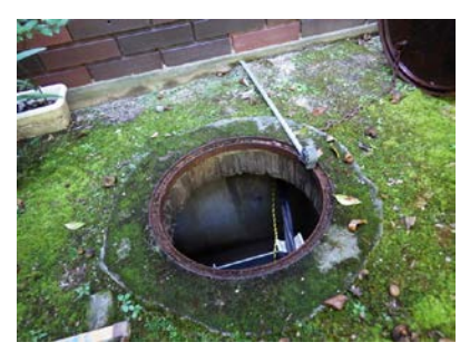
(11) ポイント2 掘削前ケーブル位置確認
