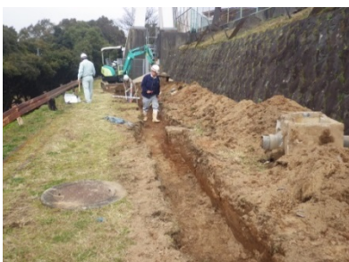
(33) 3月22日掘削風景
