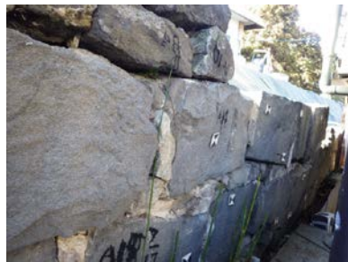
(32) 法面南側削平に伴う 東面石垣の撤去石材
