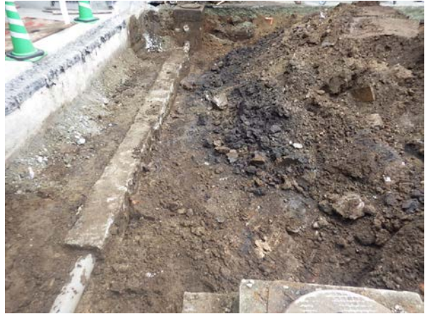
(34) 掘削基底の状況
