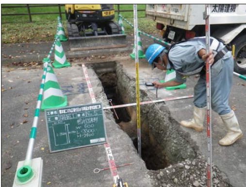
(14) No.5 トレンチ
