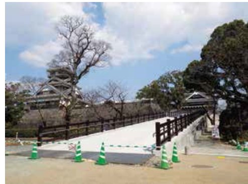
天守閣復旧へのスロープ設置
