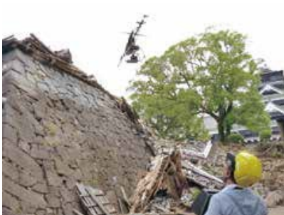
①崩落状況の記録（写真測量）
