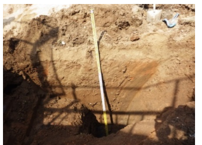
(33) 3月28日掘削断面 (中継ポンプ槽)
