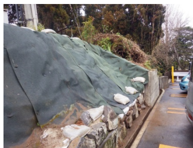
(32) 法面北側 工事完了状況
