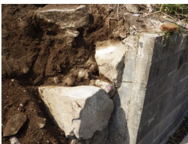
(32) 法面北側 ブロック塀に保護され 現状保存される東面石垣石材
