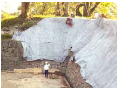
⑦保護シート（不織布）の設置
