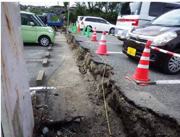
(12) 工事風景（東から）
