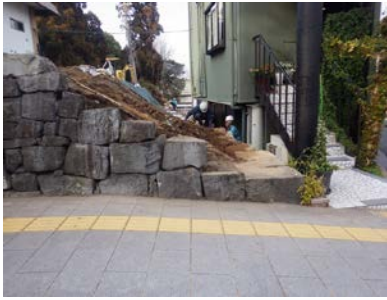
(32) 法面南側 南側石垣の石材撤去状況
