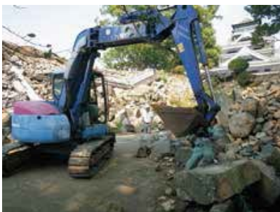
④崩落石材の回収（1石ごと玉掛けして吊り上げ）
