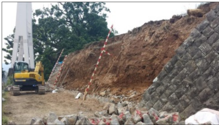
(7) 8月22日工事立会
