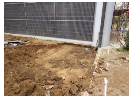
(28) ポイント 1 付近掘削
