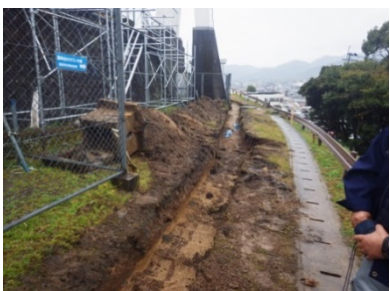
(33) 3月23日掘削風景
