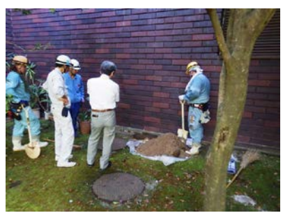
(11) ポイント2 掘削風景
