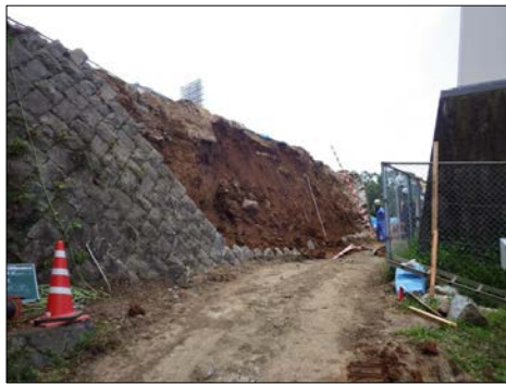
(7) 8月5日工事立会
