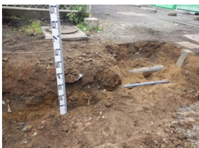
(33) 3月24日掘削断面 (東側)
