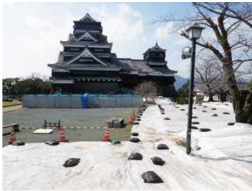
本丸広場の雨水対策シート養生
