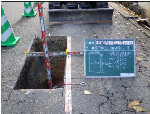
(14) No.3 トレンチ
