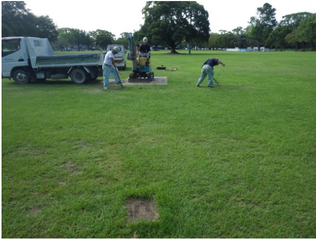
(13) 掘削作業状況
