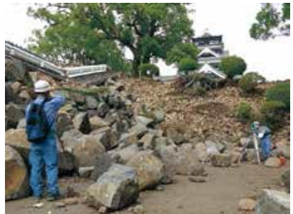
③崩落石材の測量（光波などのデジタル測量）
