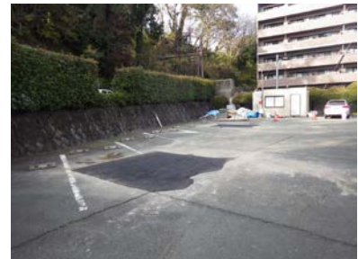
(25) アスファルト復旧
