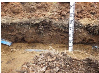
(33) 3月24日掘削断面 (西側)
