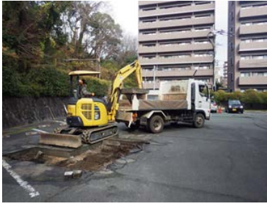
(25) アスファルト・ コンクリート除去風景
