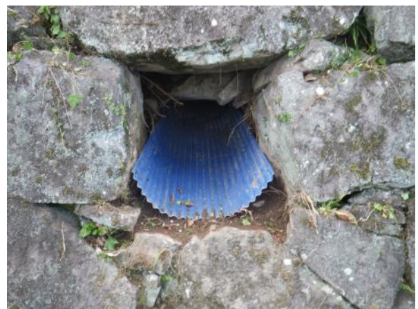
(5) 養生完了 東から
