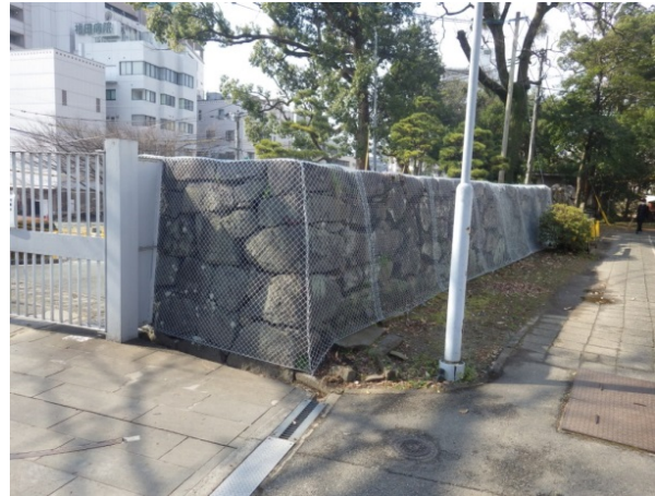
(24) 作業完了状況
