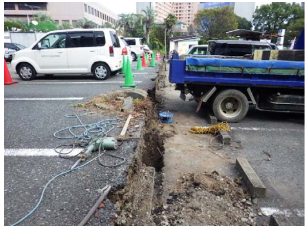
(12) 工事風景（西から）
