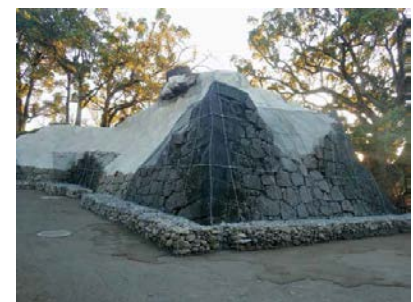
⑨防護ネットによる安全対策
