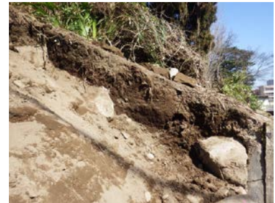
(32) 法面北側 工事完了状況
