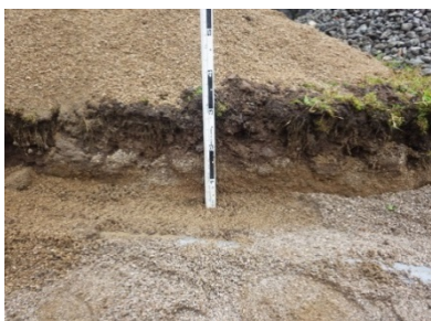
(33) 3月23日掘削断面 (西側)
