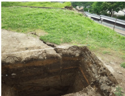
(2) 1トレンチ北 崩落箇所を望む
