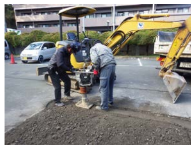
(25) 復旧, 砕石填圧
