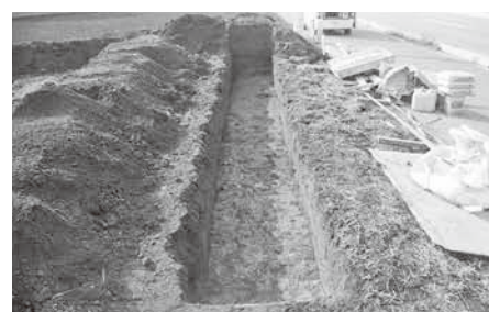
鳴神山遺跡(第4地点) 1トレンチ(東から)
