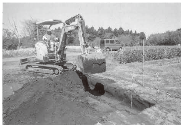
8.和田谷第4遺跡トレンチ掘削状況
