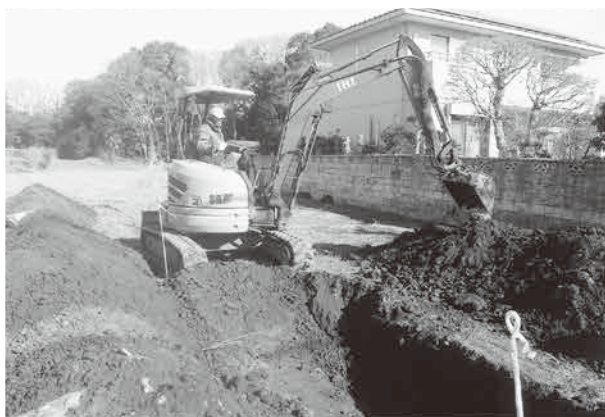
7.大畑遺跡(第4地点) トレンチ掘削状況
