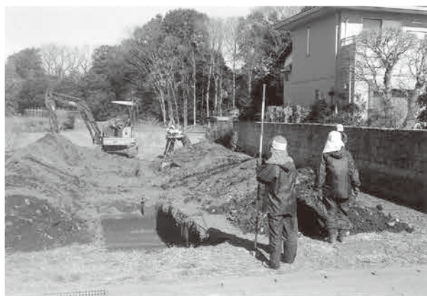
8.大畑遺跡(第4地点) 作業風景
