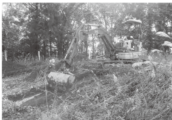
6.木橋第1遺跡トレンチ掘削状況
