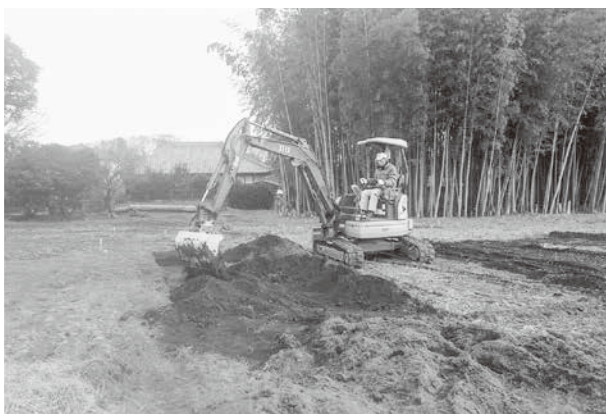
8.古井戸後遺跡（第3地点）埋戻し状況
