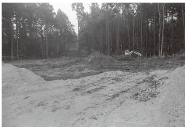
1.手倉野馬堀トレンチ掘削状況
