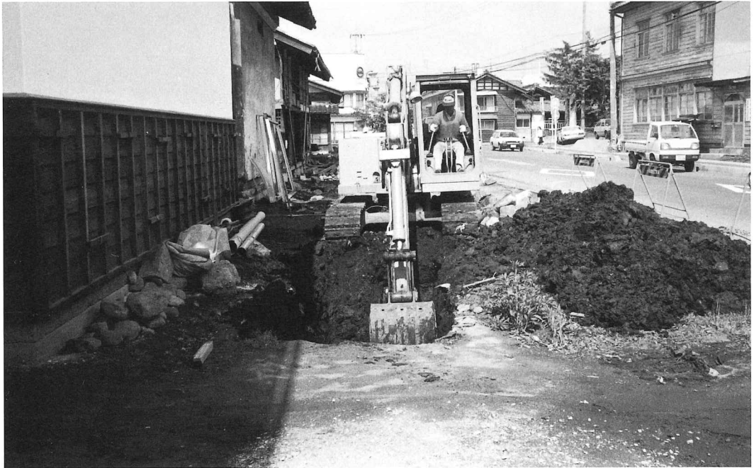
1. 表土除去作業開始 (第Ⅰ地区)
