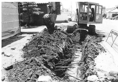
7. 第4区トレンチ (北方より)
