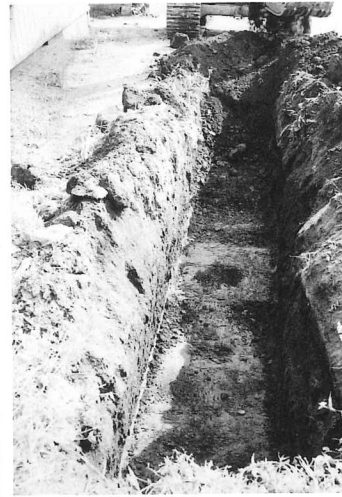
7. 第13区トレンチ (北方より)
