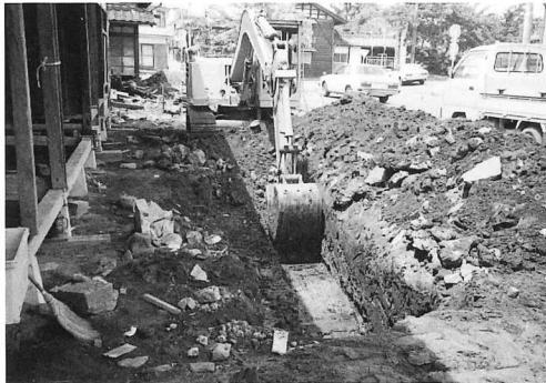
2. 表土除去作業 (第Ⅲ地区)
