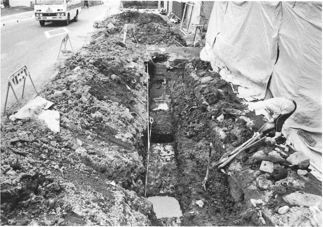
1. 菅田遺跡第Ⅲ地区 (西方より)
