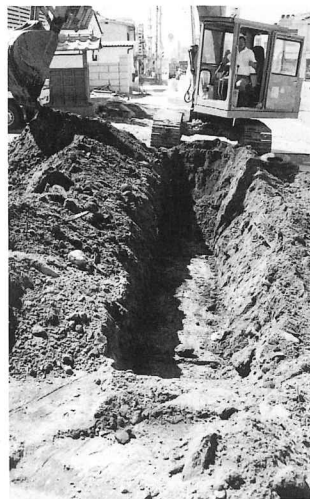
4. 第2区トレンチ (北方より)
