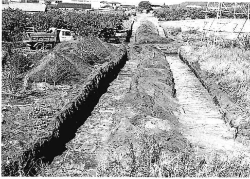
1 A地区全景（南方より）
