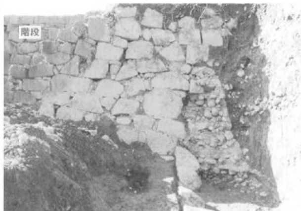
4-3-1-225 図 石垣根石の残存状況・同拡大 入隅部分(図2-3-34・図2-3-35)
