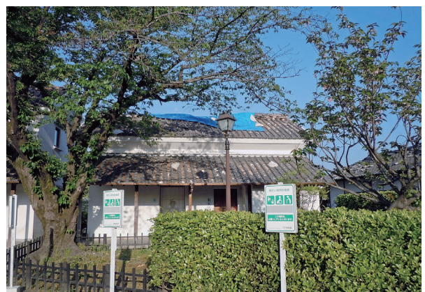
⑮二の丸駐車場東棟トイレ
