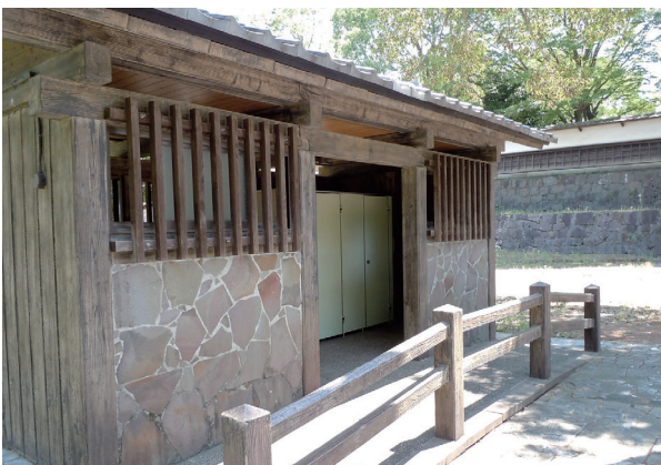
㉓三の丸広場北側トイレ
