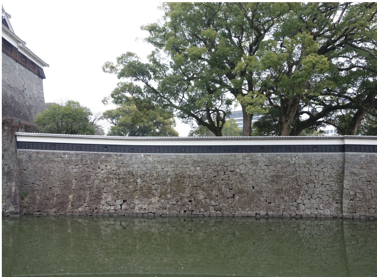
竹の丸西側石垣 被災前 西から
