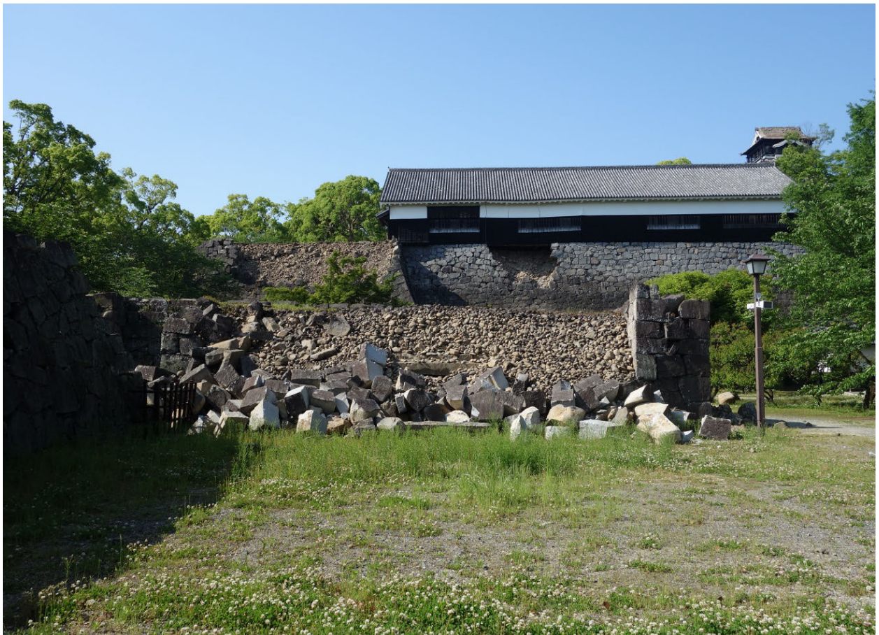
被災後 南から
