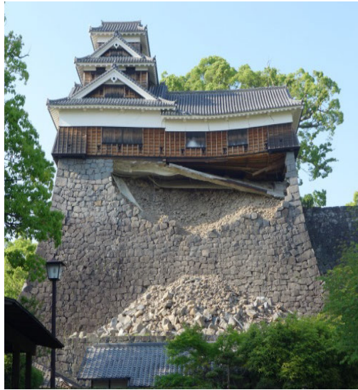
飯田丸南面石垣崩落状況
