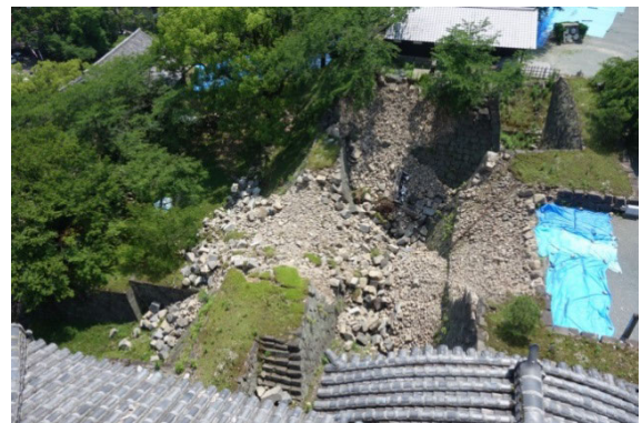
トキ櫓と石門上部石垣の崩壊
