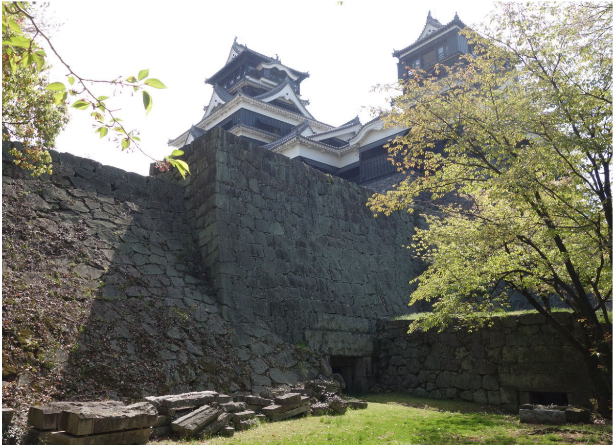
石門石垣 被災前 北東から
