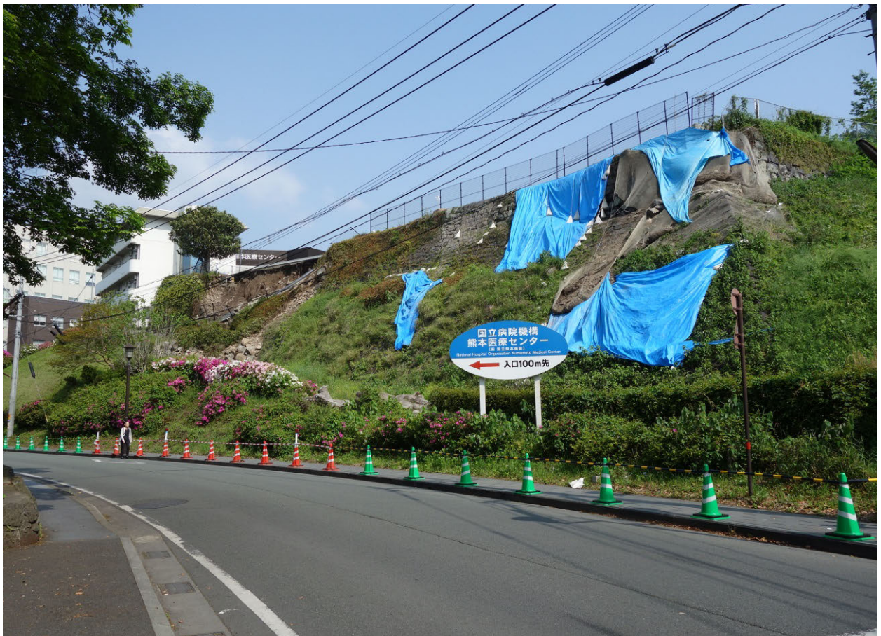
被災後 南東から
