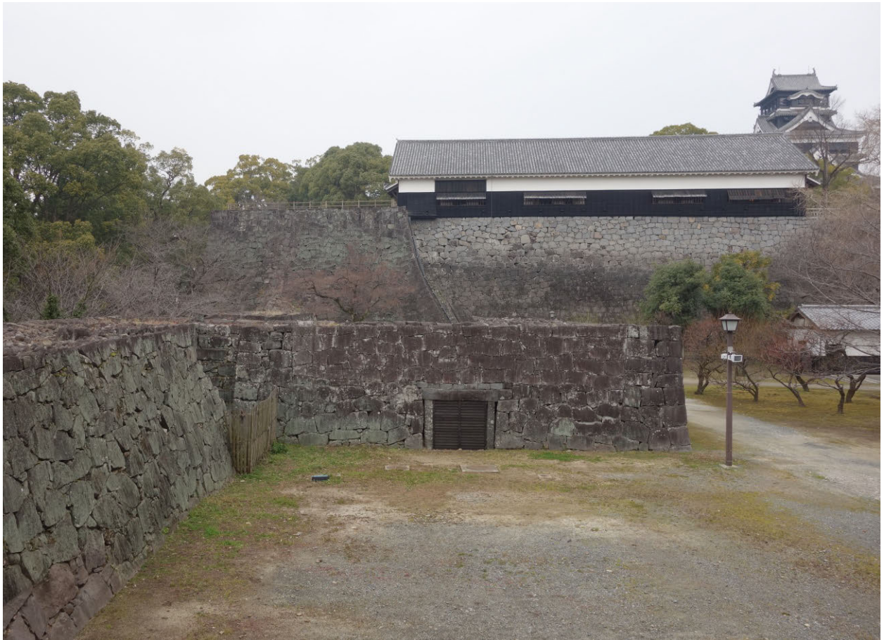
向埋御門石垣 被災前 南から
