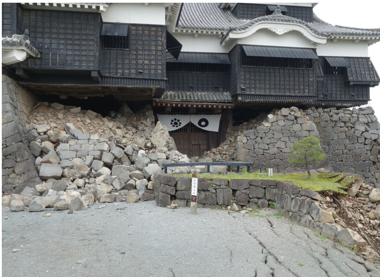
被災後 東から
