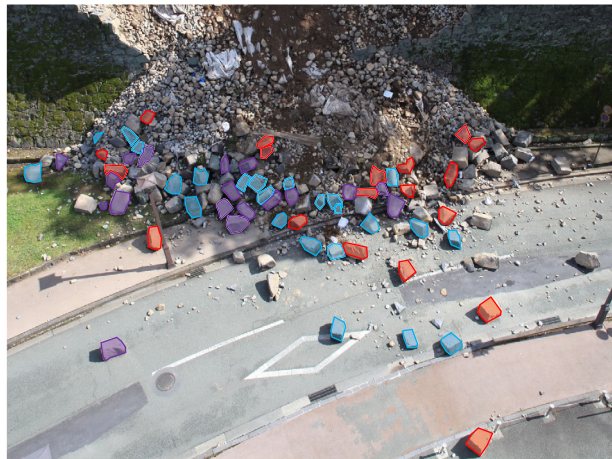
百間石垣東側崩落状況石材色分け
