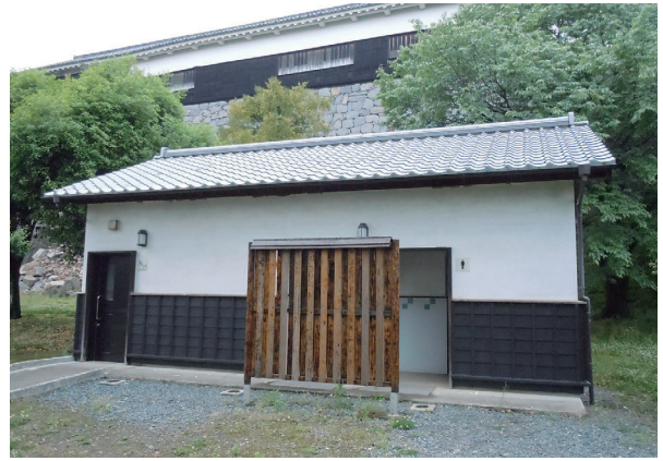
⑥飯田丸トイレ・ポンプ室
