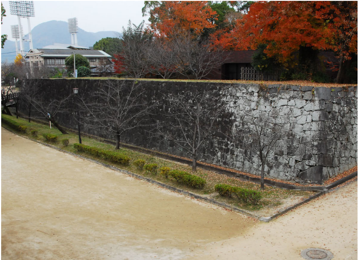
二の丸西口石垣 被災前 南東から
