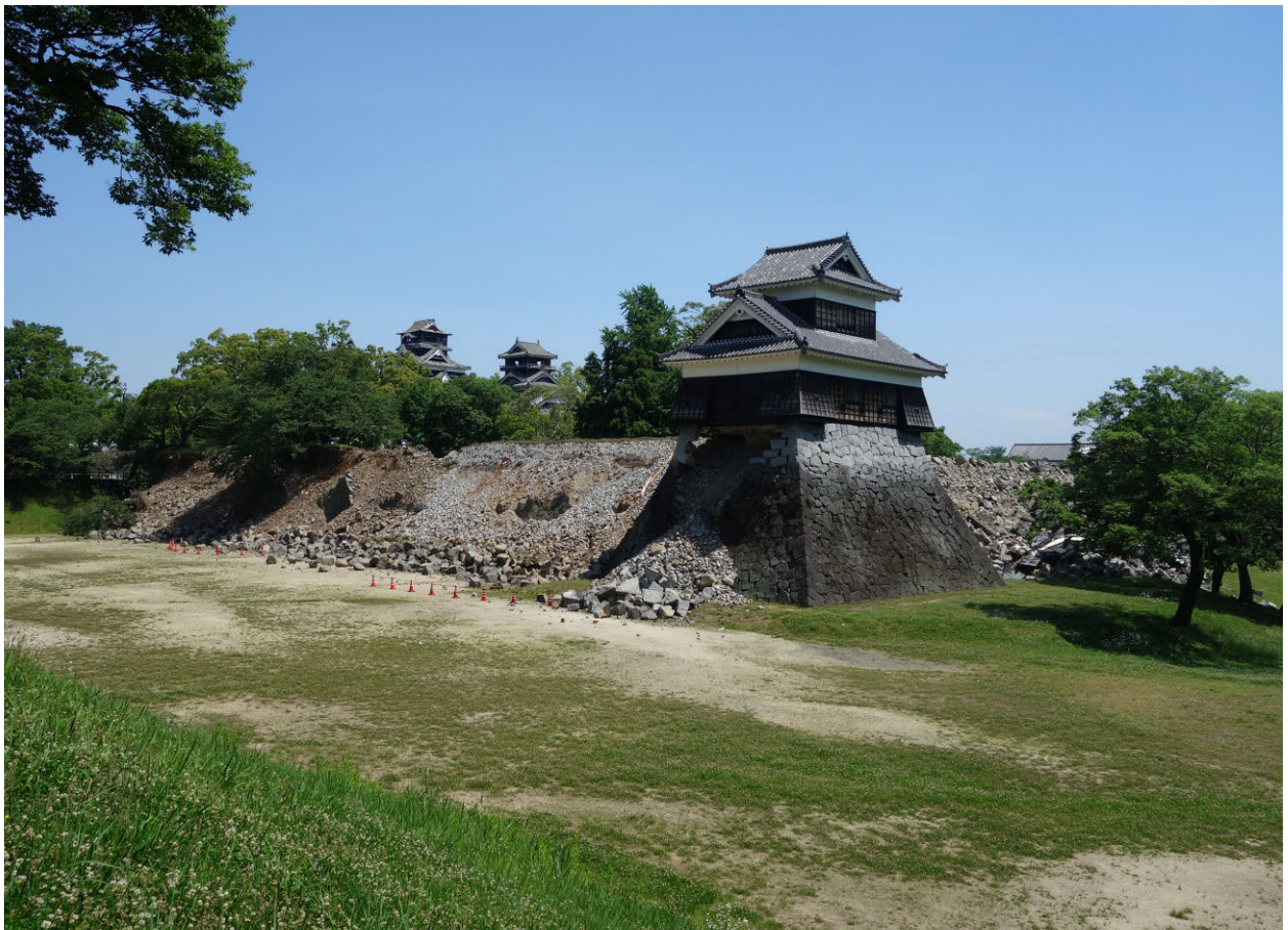
被災後 北西から
