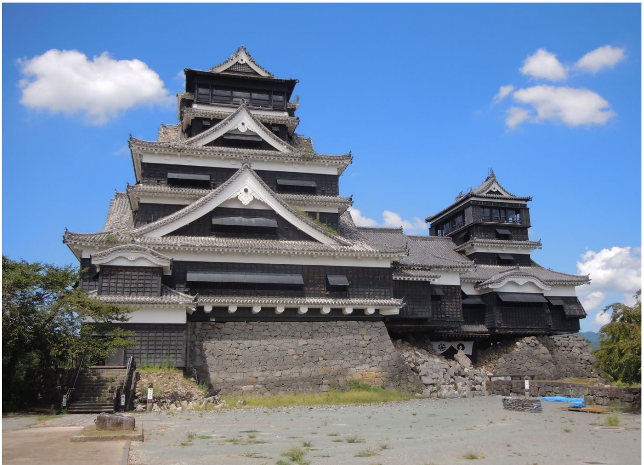
被災後 東から
