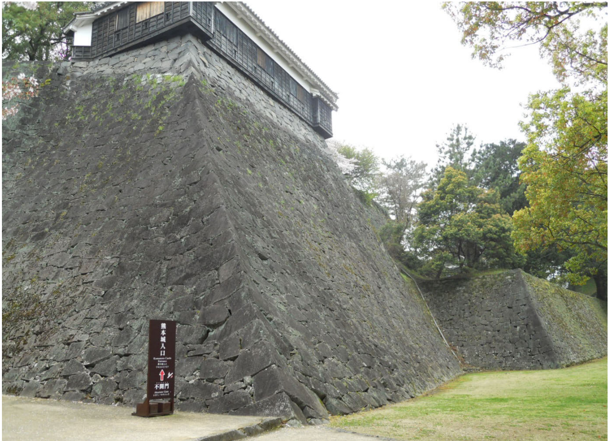
平櫓石垣 被災前 北東から
