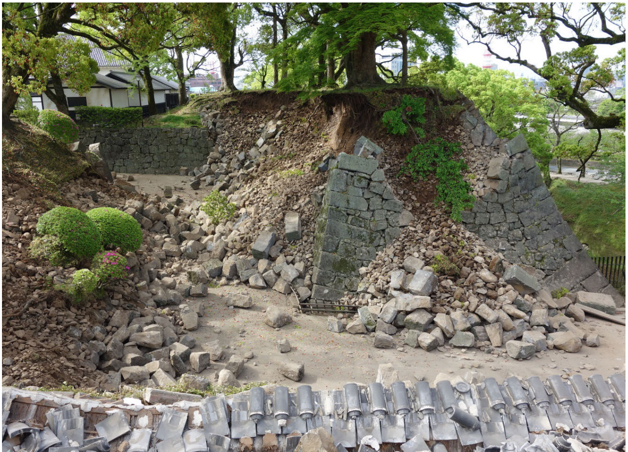
被災後 北から
