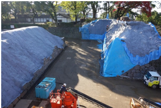
頼当御門口石垣養生作業
