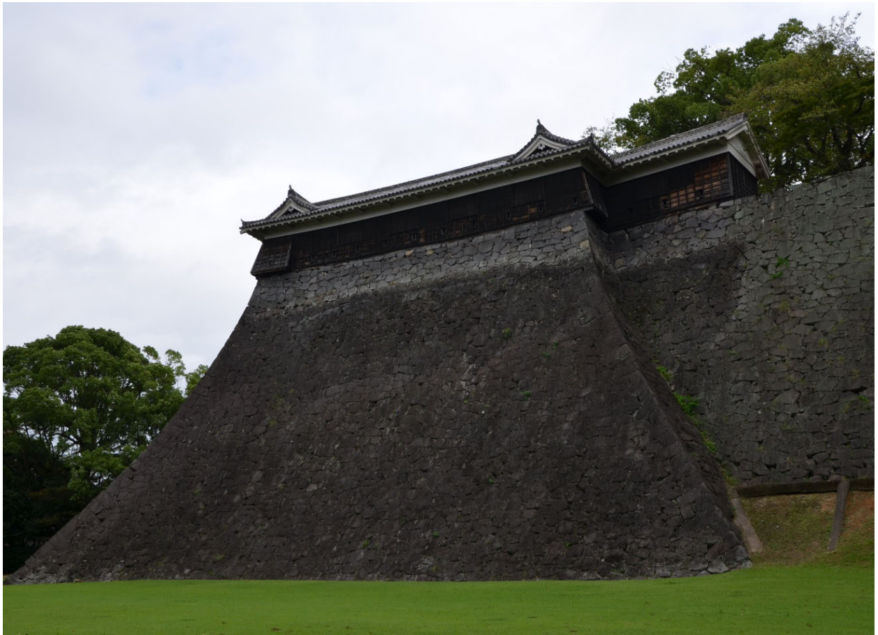
北十八間櫓北側石垣 被災前 北から
