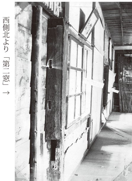
図6-11 要旨三(イ) 1 続櫓西側、北より第二の窓南の間の柱(もと窓の痕跡)。文化庁所蔵。
