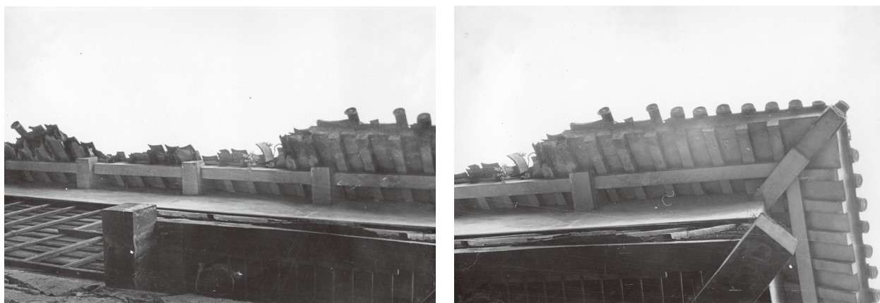
図6-31 続櫓軒先の破損の様子
