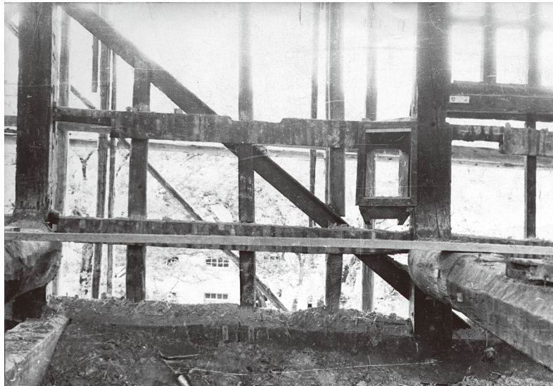
図 6-28 要旨二（口） 続櫓腰貫に残る旧銃眼欠 1 西側南より「第八、第九間」。文化庁 所蔵。
