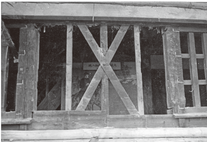
図6-2 要旨一（イ）1 北側、東より第七の間のもと窓の 痕跡。文化庁所蔵。
