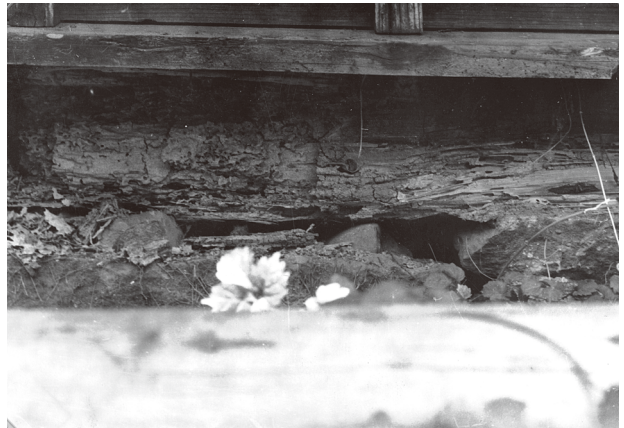
図 6-33 続櫓南東隅土台腐蝕（位置図 3 カ ）
