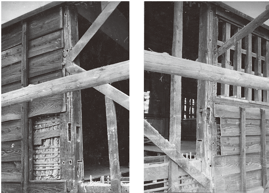
図 6-17 要旨四-1 旧石落の土台が切断されている。文化庁所蔵。
