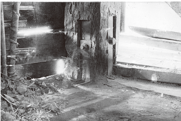
図 6-79 宇土櫓西北隅柱☆
