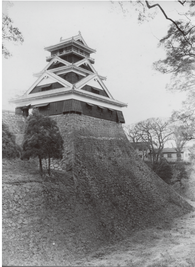
図 6-82 昭和44年度竣工写真
