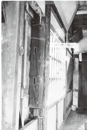
図6-5 要旨一(イ) 4 北側、東より第三の間の柱抱合せ面（もと窓の痕跡）。文化庁所蔵。
