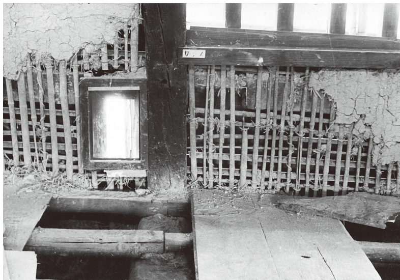
図 6-29 要旨二（口） 続櫓腰貫に残る旧銃眼欠 2 右：腰貫に残る旧銃眼欠。 左：上の図の現存のもの。 文化庁所蔵。
