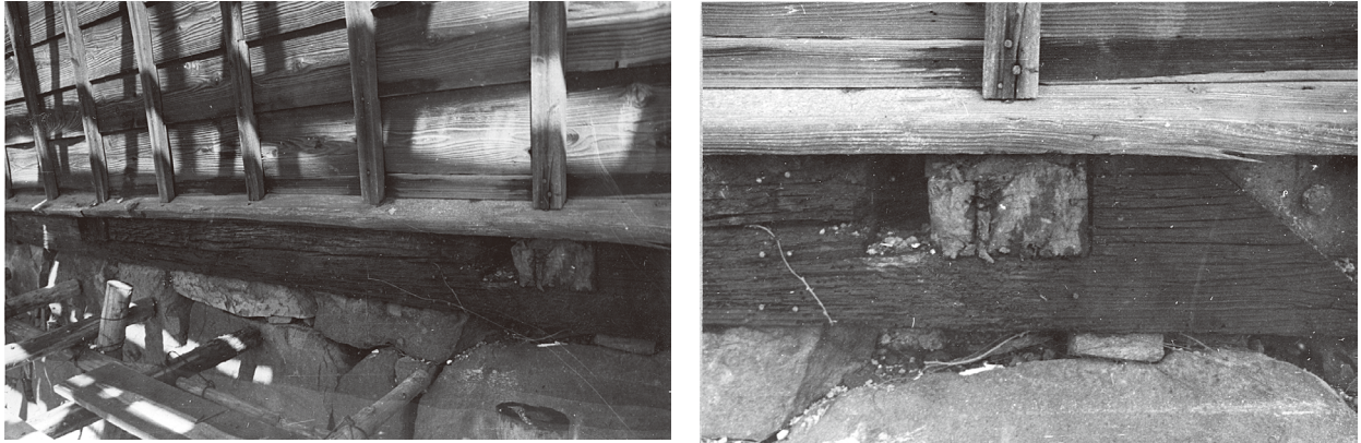
図 6-17 要旨四-1 旧石落の土台が切断されている。文化庁所蔵。
