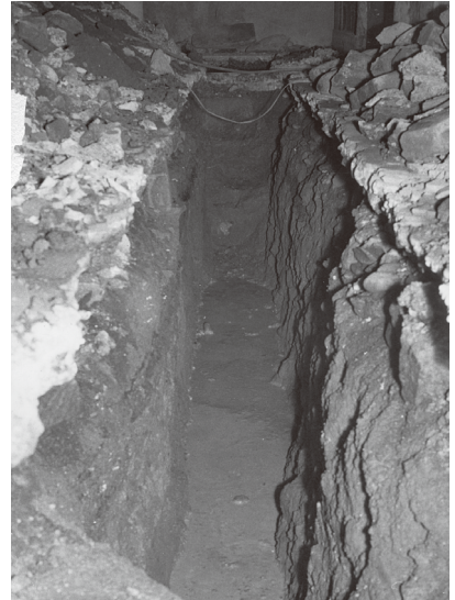
図 6-84 地階布掘の様子
