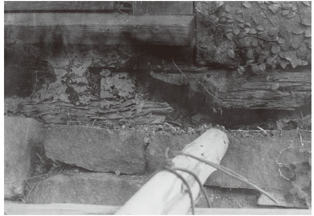
図 6-33 続櫓南東隅土台腐蝕（位置図 3 カ ）
