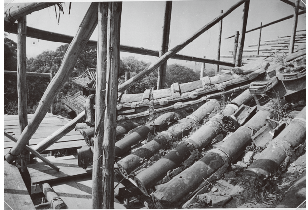
図 6-57 二層東南下り棟側面
