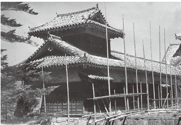
図 6-73 二階櫓東南隅（修理前）☆
