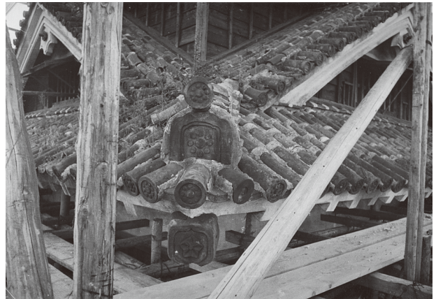
図 6-47 二層北西下り棟正面
