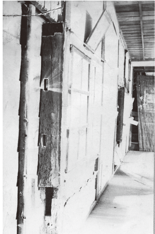
図6-22 要旨一 修理前 壁の間の柱2 壁撤去の状態。窓台、鴨居仕口がある。 文化庁所蔵。
