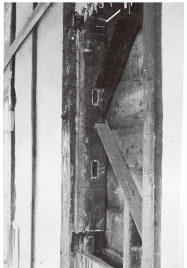
図6-9 要旨一(ハ) 2 東側、北より第四の間北寄りの柱（もと窓の痕跡）。文化庁所蔵。
