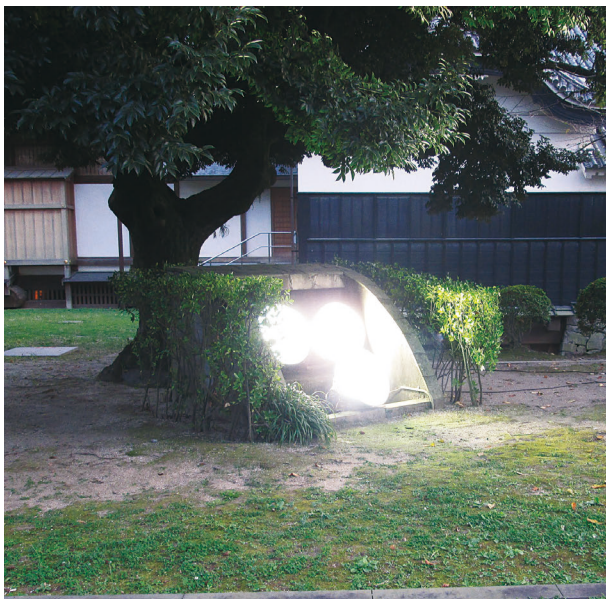
図 5-18 ライトアップ施設（本丸御殿）
