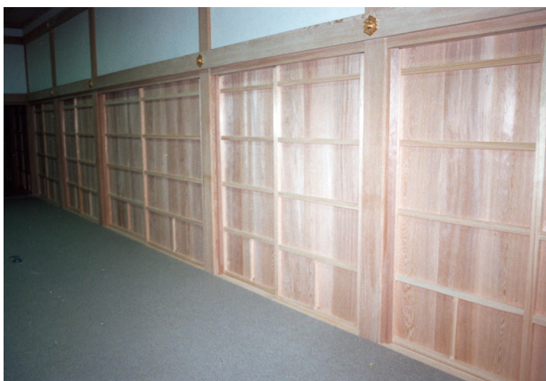
図 4-80 建具工事 二の間、三の間 板戸
