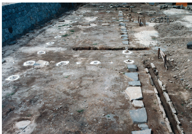
図 4-24 基礎工事 1階礎石位置出
