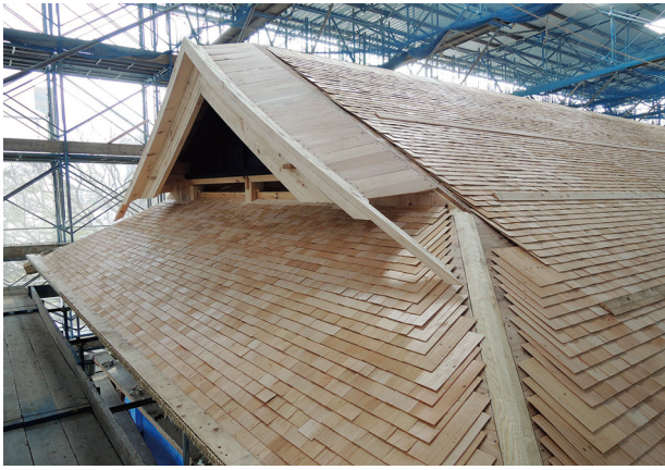
図 4-150 馬具櫓 屋根工事 土居葺
