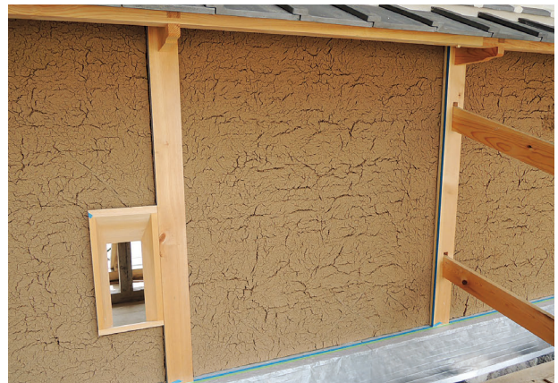
図 4-171 続塀 左官工事 荒壁付け
