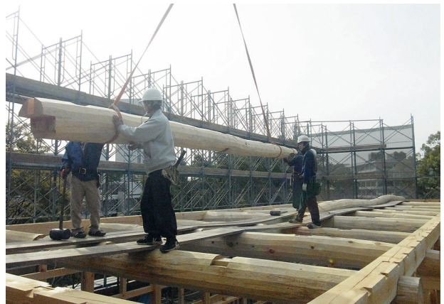
図 4-147 馬具櫓 木工事 敷梁組立
