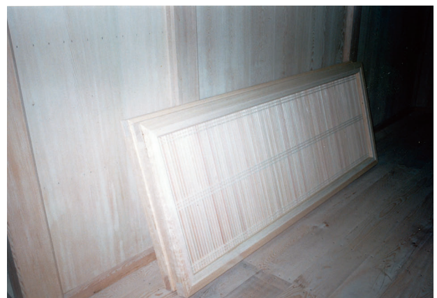
図 4-81 建具工事 箆欄間搬入
