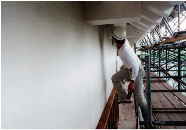
図 4-74 左官工事 南面外壁漆喰仕上
