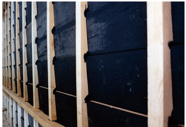
図 4-49 木工事 妻壁下見板取付
