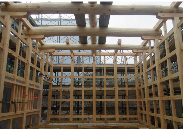
図 4-146 馬具櫓 木工事 柱組立状況
