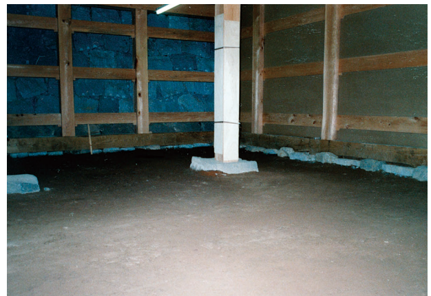
図 4-29 基礎工事 1階土間 三和土下地均
