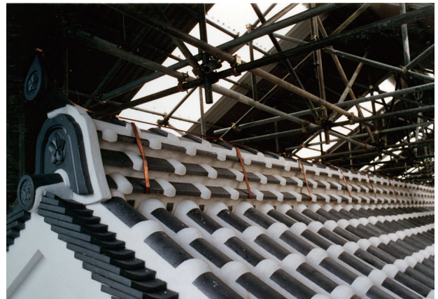
図 4-61 屋根工事 目地漆喰仕上、避雷針棟上導帯取付完了
