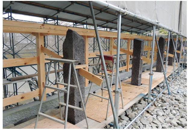
図 4-167 続塀 木工事 控貫組立
