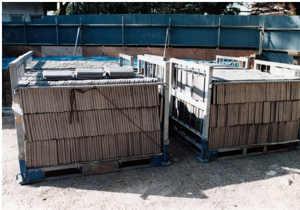
図 4-54 屋根工事 瓦搬入
