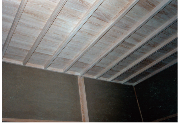
図 4-51 木工事 階段の間 天井板張り
