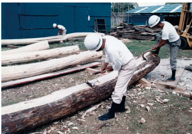
図 4-32 木工事 梁チョウナ掛
