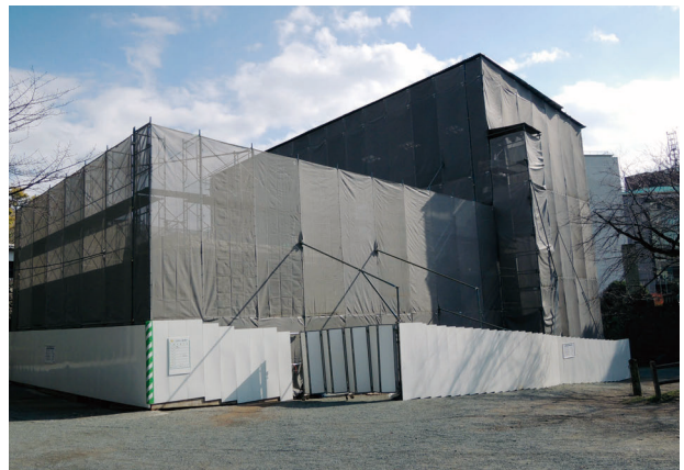
図 4-163 馬具櫓・続塀 仮設工事 素屋根完了
