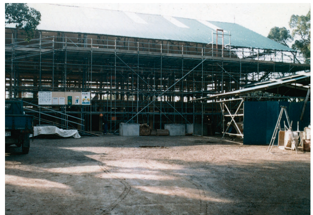
図 4-23 仮設工事 素屋根完了
