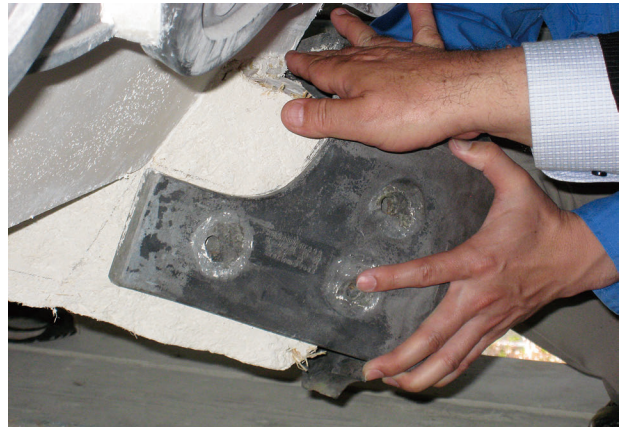
図 4-153 馬具櫓 屋根工事 隅木蓋再利用
