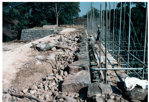
図 4-25 基礎工事 南面石垣補修
