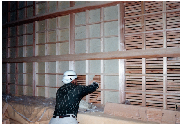
図 4-73 左官工事 床の間壁漆喰下塗
