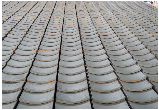
図 4-151 馬具櫓 屋根工事 平瓦葺き上げ
