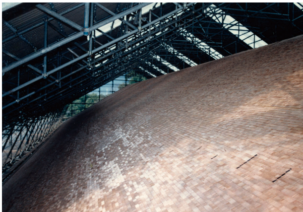
図 4-56 屋根工事 南面屋根土居葺完了
