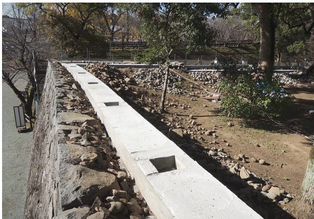
図 4-164 続塀 基礎工事 構造補強用基礎完了
