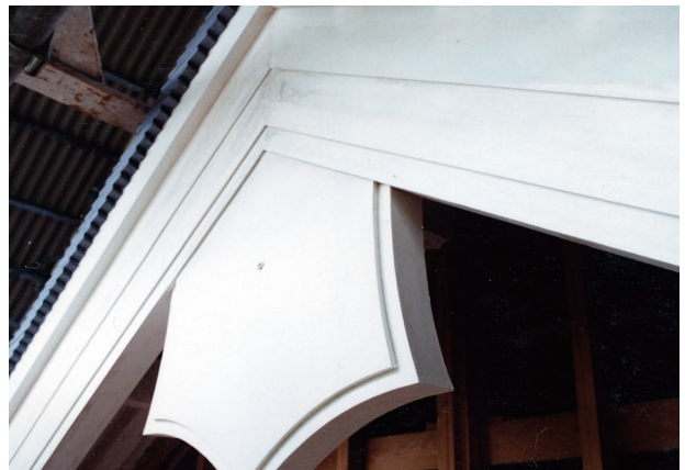
図 4-71 左官工事 東面破風漆喰仕上
