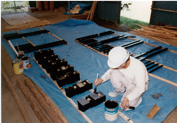
図 4-76 塗装工事 竹の節欄間カシュー下塗
