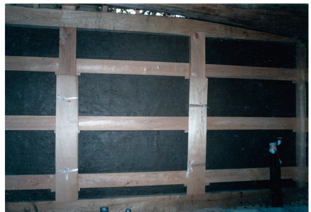
図 4-65 左官工事 1階荒壁塗裏返し
