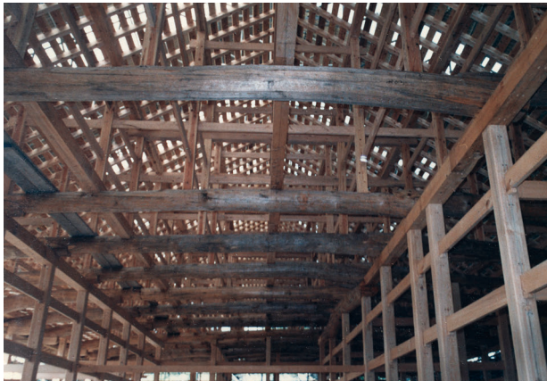
図 4-44 木工事 2階内部（三の間上部）
