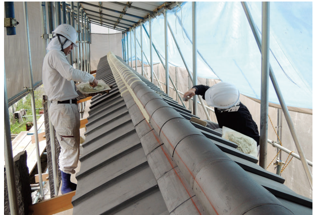
図 4-169 続塀 屋根工事 目地漆喰塗
