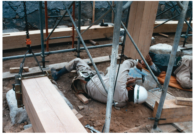
図 4-35 木工事 1階柱ひかり付け作業
