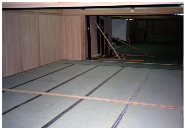
図 4-85 雑工事 上座の間及び一の間畳敷込
