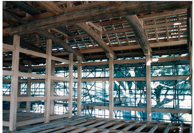
図 4-45 木工事 2階内部（板の間）
