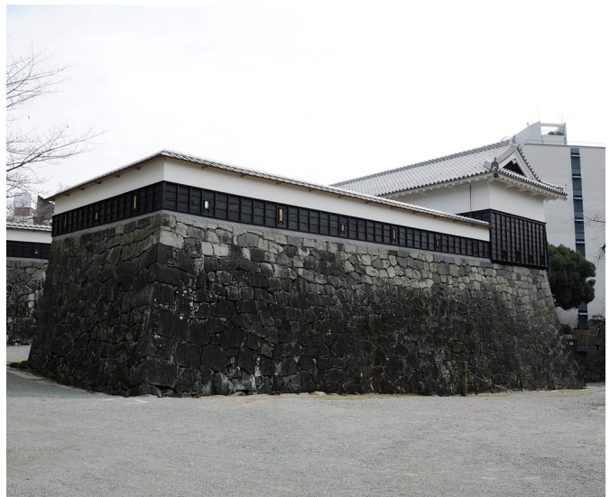
図 4-179 馬具櫓 竣工 西北より
