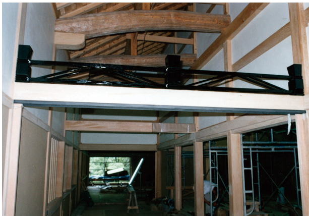
図 4-78 建具工事 廊下竹の節欄間組立
