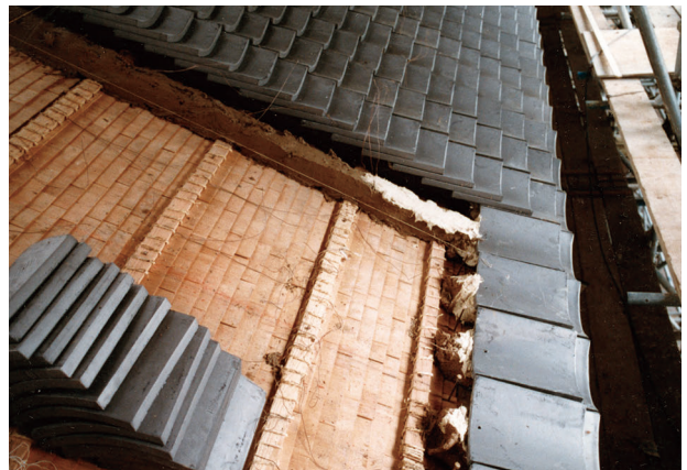
図 4-57 屋根工事 軒平瓦・平瓦葺
