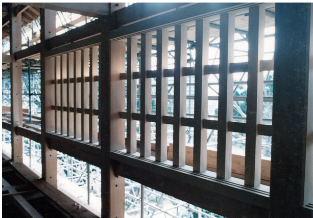
図 4-46 木工事 2階窓格子組立
