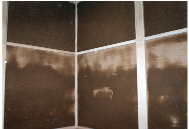
図 4-69 左官工事 次の間土壁乾燥
