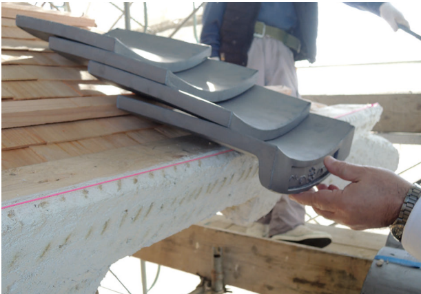
図 4-152 馬具櫓 屋根工事 軒先納まり確認
