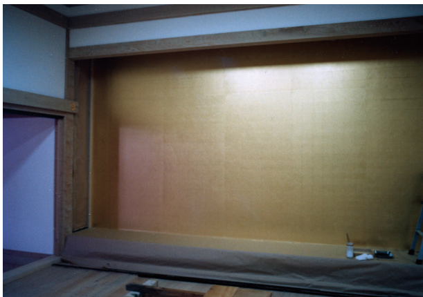
図 4-84 雑工事 床の間金箔押し完了
