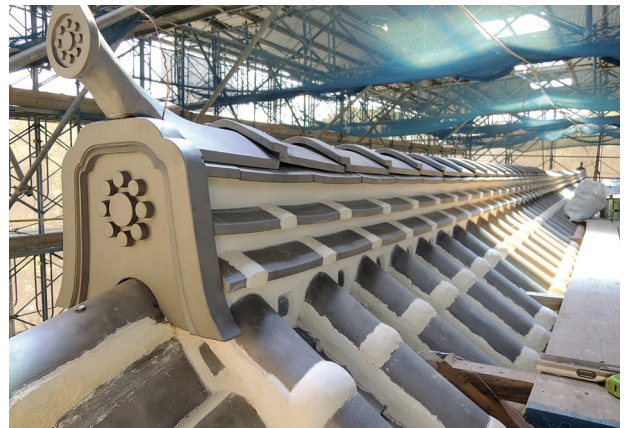
図 4-155 馬具櫓 屋根工事 大棟施工完了
