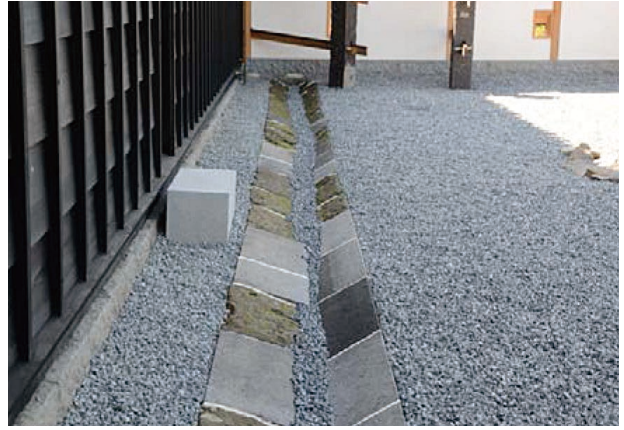
図 4-143 馬具櫓 石工事 雨落側溝完了
