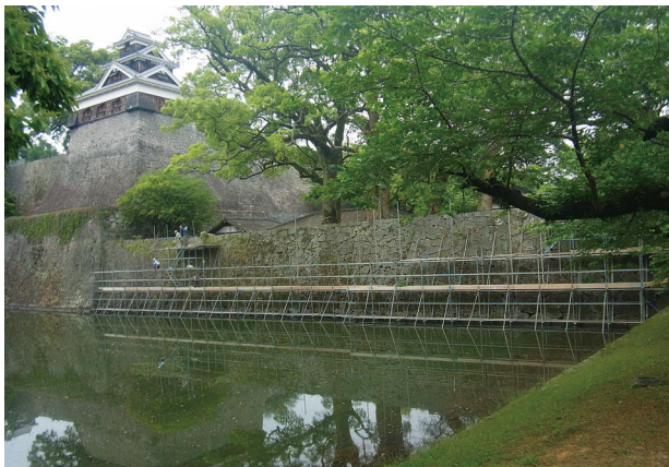
図 4-162 続塀 仮設工事 備前堀側足場組立
