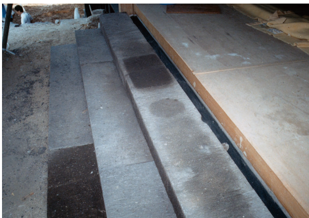
図 4-86 雑工事 廊下出入口石階段取付
