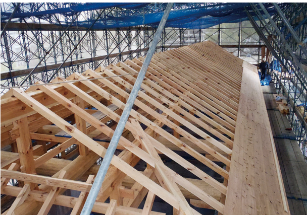
図 4-148 馬具櫓 木工事 垂木・野地板組立
