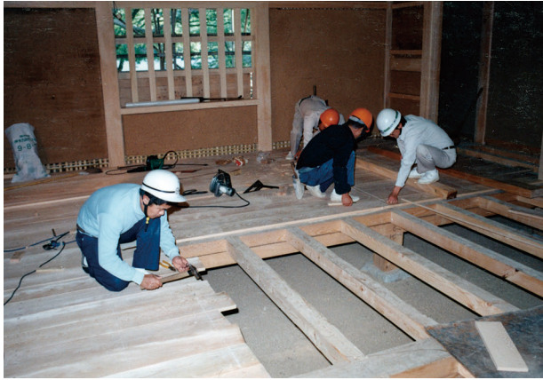
図 4-50 木工事 板の間 床板張り
