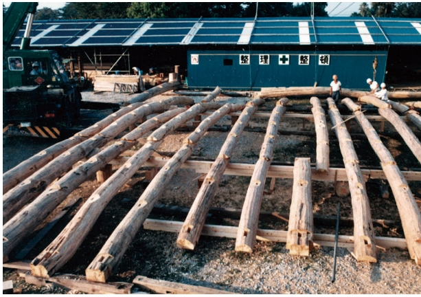
図 4-34 木工事 大梁仮組作業
