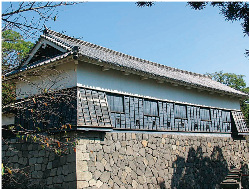
図4-6 コンクリートブロック造による馬具櫓（平成20年）
