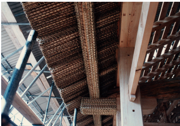
図 4-62 左官工事 外部軒裏巻竹取付
