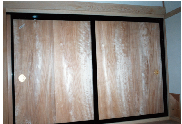
図 4-79 建具工事 杉板戸建付
