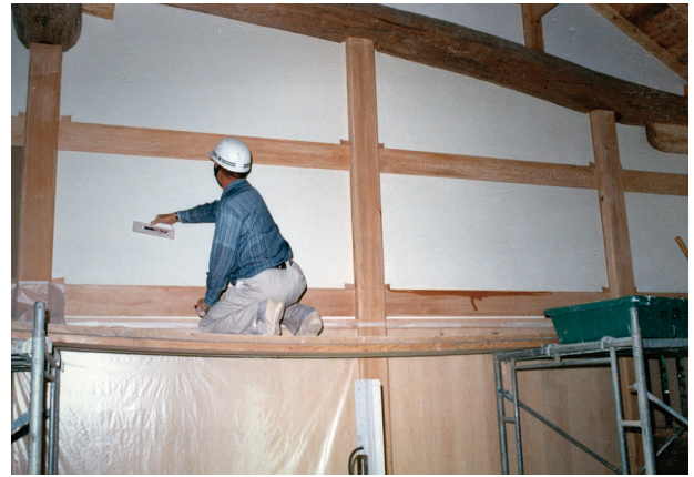
図 4-75 左官工事 板の間壁漆喰仕上
