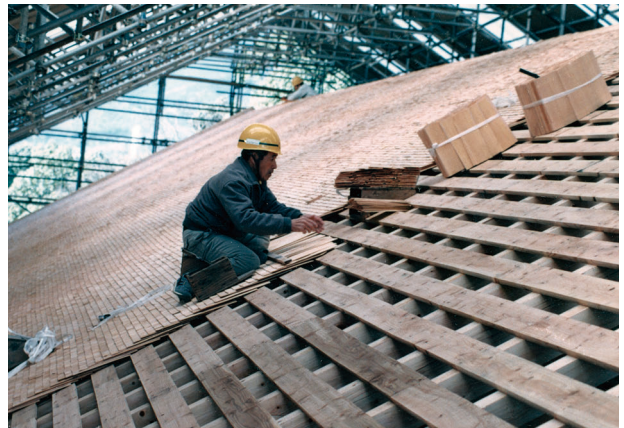
図 4-55 屋根工事 土居葺施工中
