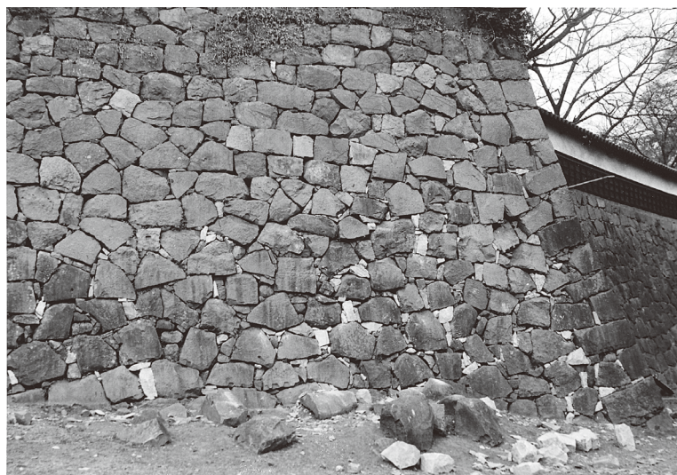
図 3-19 馬具櫓南側竣工
