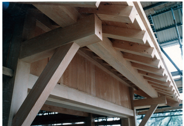
図 4-47 木工事 庇組立完了
