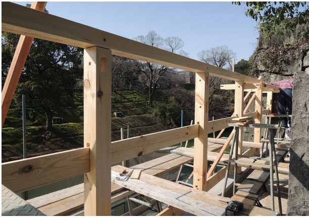
図 4-166 続塀 木工事 柱組立
