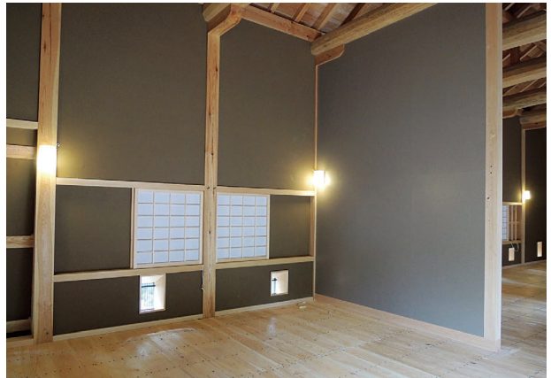
図 4-161 馬具櫓 構造補強工事 補強壁完了
