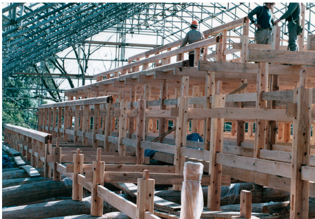
図 4-40 木工事 母屋、棟木組立
