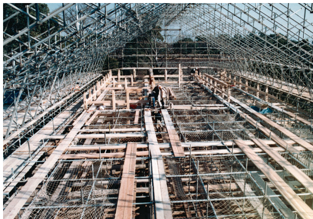
図 4-22 仮設工事 2階内部足場組立
