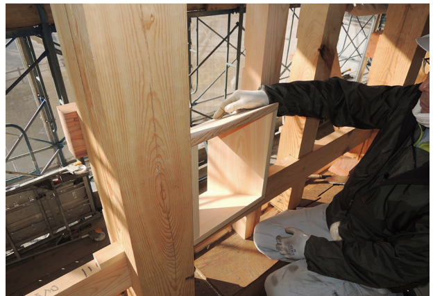
図 4-149 馬具櫓 木工事 狭間取り付け
