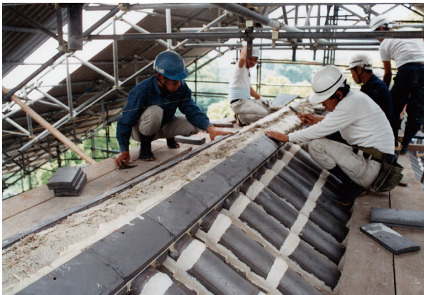
図 4-60 屋根工事 棟熨斗瓦取付（1段目）
