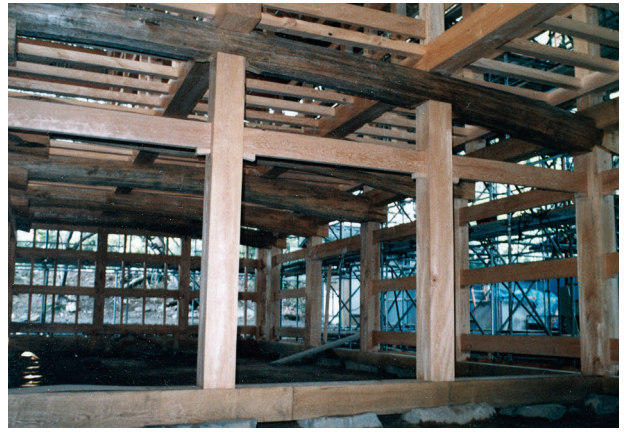
図 4-43 木工事 1階内部（土間1、2）
