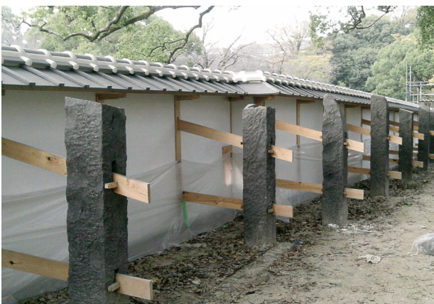
図 4-172 続塀 左官工事 内側漆喰仕上げ
