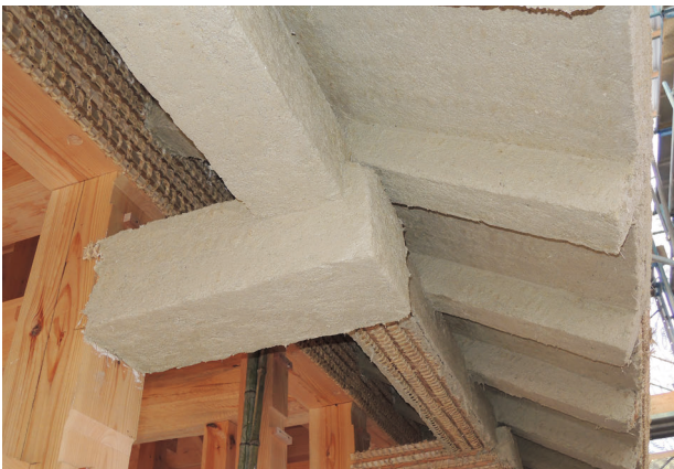
図 4-156 馬具櫓 左官工事 揚げ塗施工中
