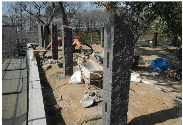
図 4-165 続塀 石工事 控柱据え付け
