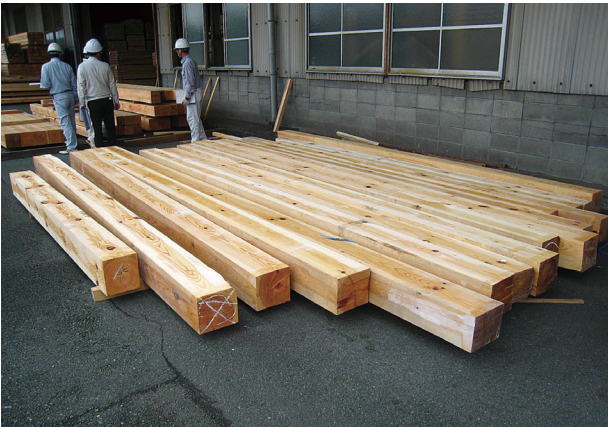
図 4-144 馬具櫓 木工事 柱材検査
