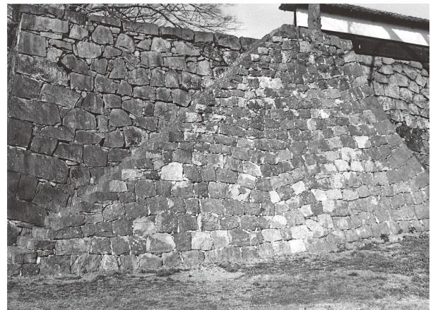
図 3-21 平御櫓西側竣工
