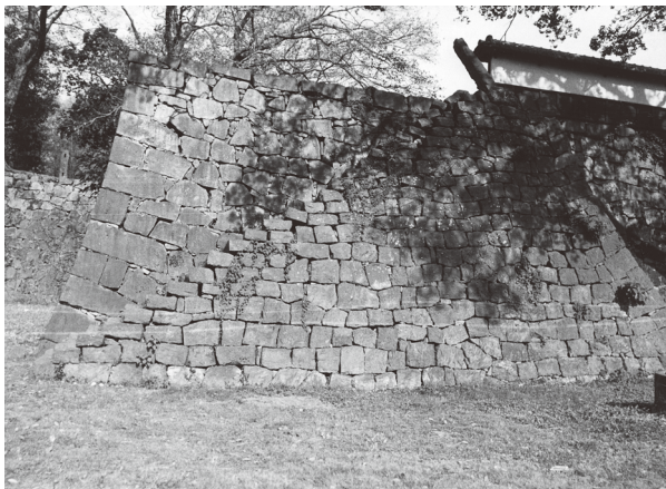
図 3-20 平御櫓西側着工前
