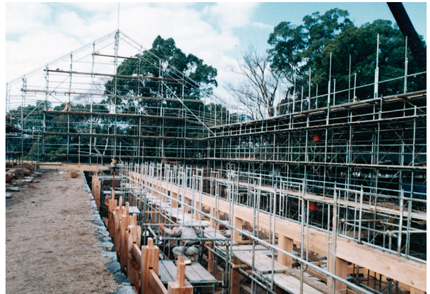
図 4-37 木工事 1階軸組組立
