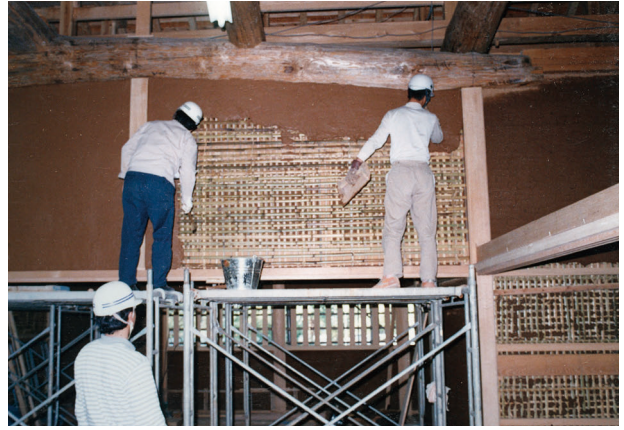
図 4-67 左官工事 二の間内壁荒壁塗
