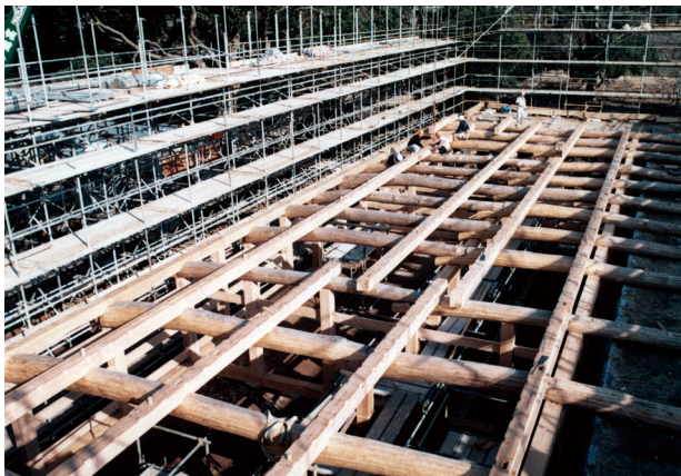
図 4-38 木工事 大梁組立
