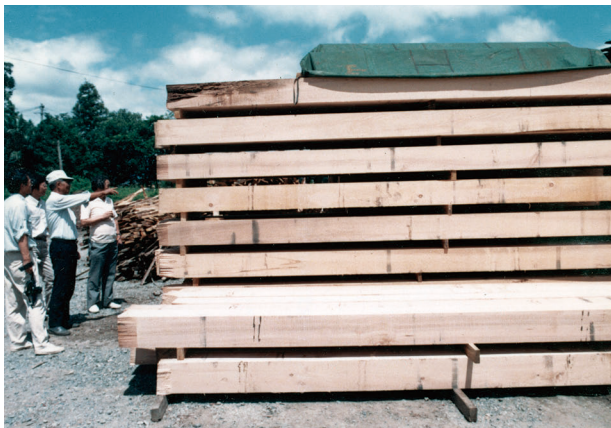
図 4-30 木工事 木材検査 (柱材)
