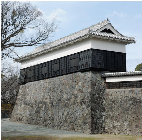
図 4-178 馬具櫓 竣工 東南より
