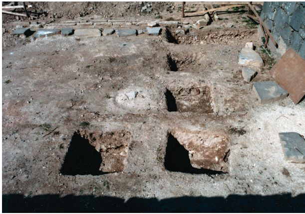
図 4-26 基礎工事 礎石版築作業
