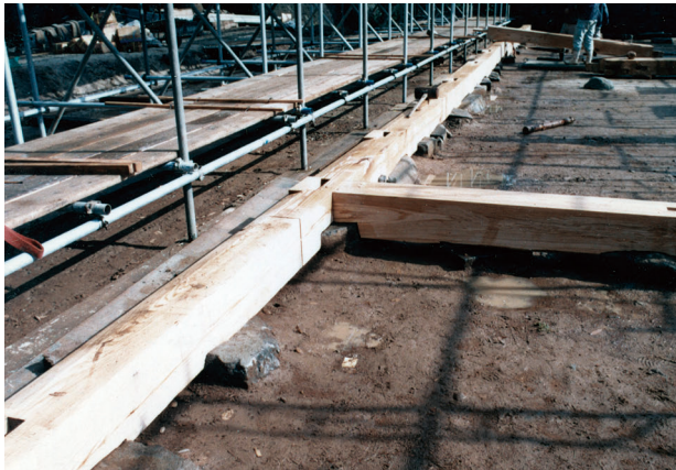
図 4-36 木工事 1階土台敷
