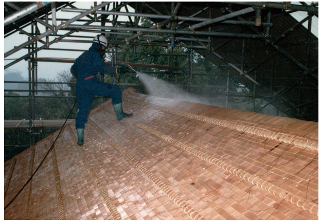
図 4-83 雑工事 屋根土居葺面防蟻処理
