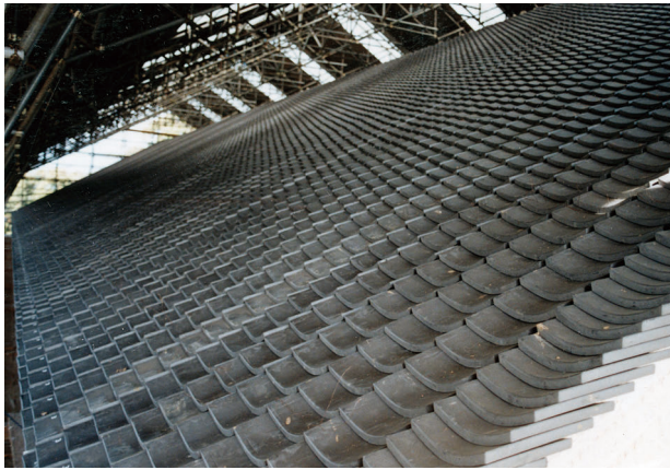
図 4-58 屋根工事 南面屋根平瓦葺完了
