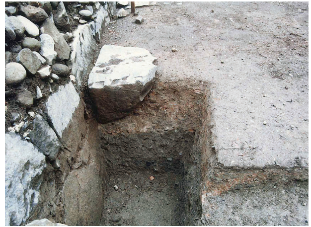
図4-15 礎石下の断面
