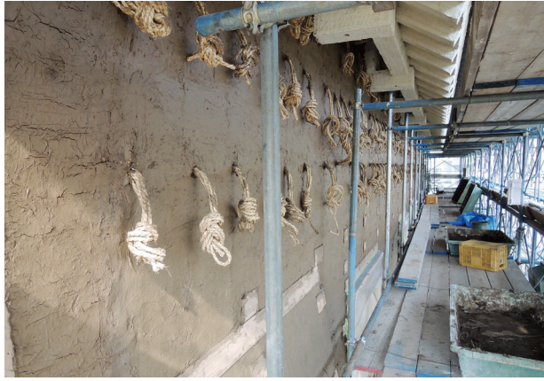
図 4-158 馬具櫓 左官工事 荒壁付け
