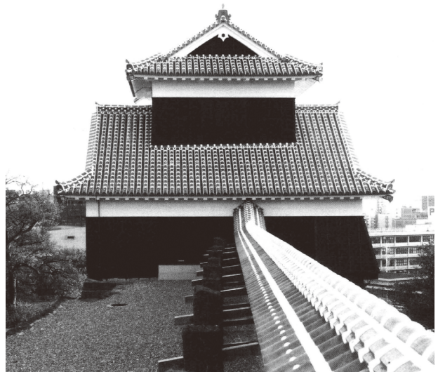
図 4-103 未申櫓外観 北より
