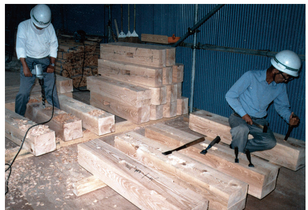
図 4-33 木工事 肘木加工
