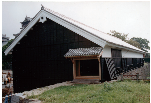
図 4-89 竣工 外観（西面）
