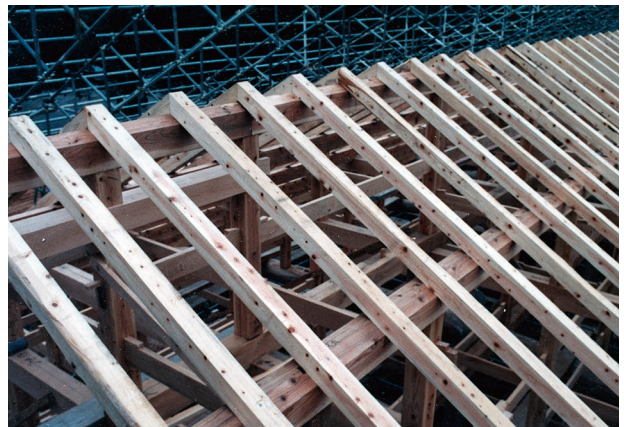
図 4-41 木工事 垂木取付完了
