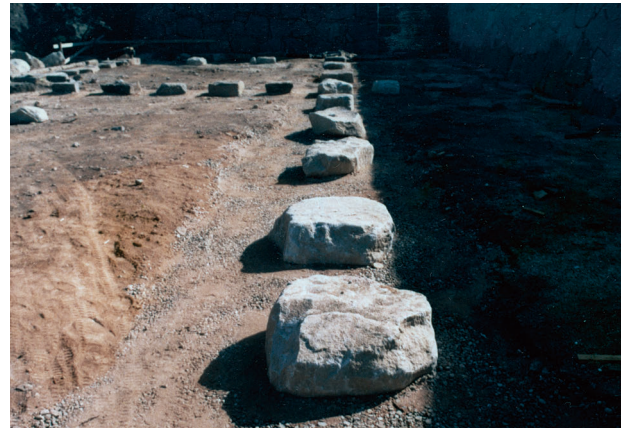
図 4-27 基礎工事 1階礎石据付完了
