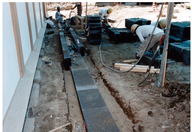
図 4-87 雑工事 外部排水溝石据付
