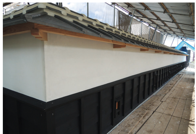
図 4-173 続塀 左官工事 外側漆喰仕上げ
