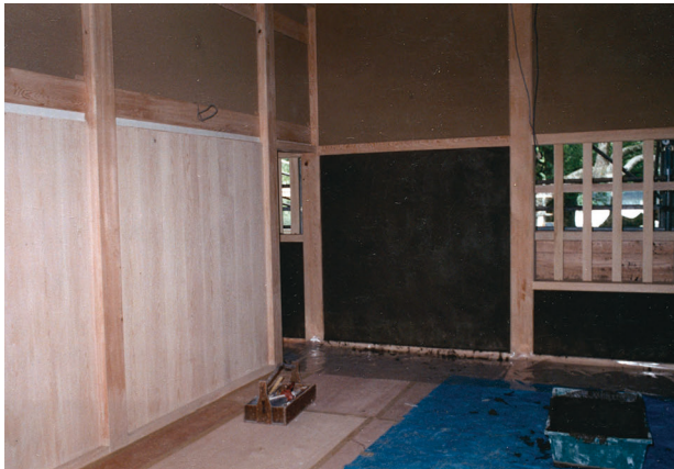
図 4-68 左官工事 板の間中塗
