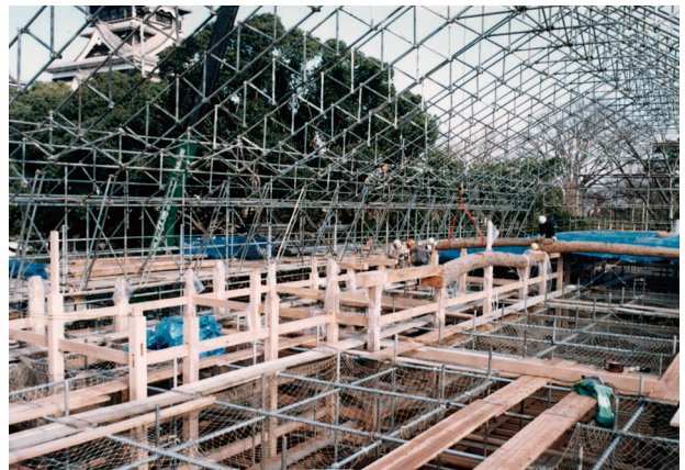
図 4-39 木工事 小屋梁他組立
