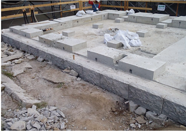
図 4-142 馬具櫓 石工事 地覆石据え付け
