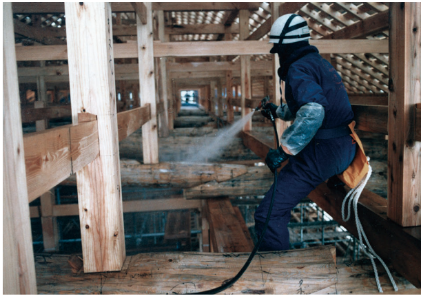
図 4-82 雑工事 小屋梁防蟻処理
