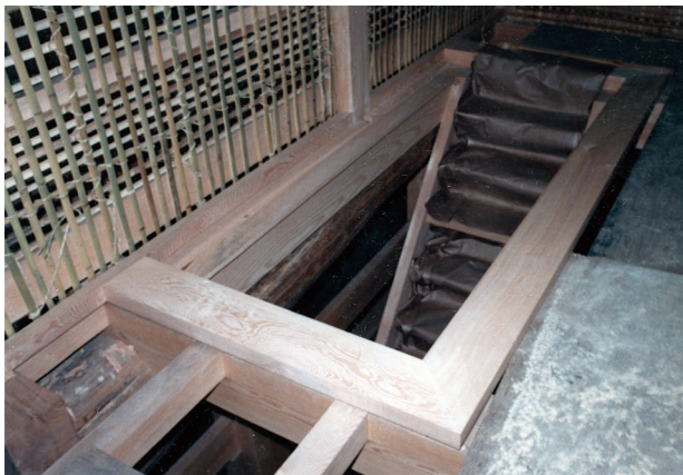
図 4-48 木工事 階段取付
