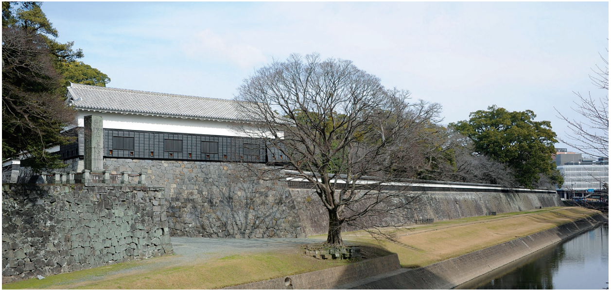
図 4-177 馬具櫓及び長塀 竣工 南面
