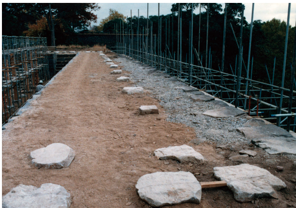
図 4-28 基礎工事 2階礎石据付完了
