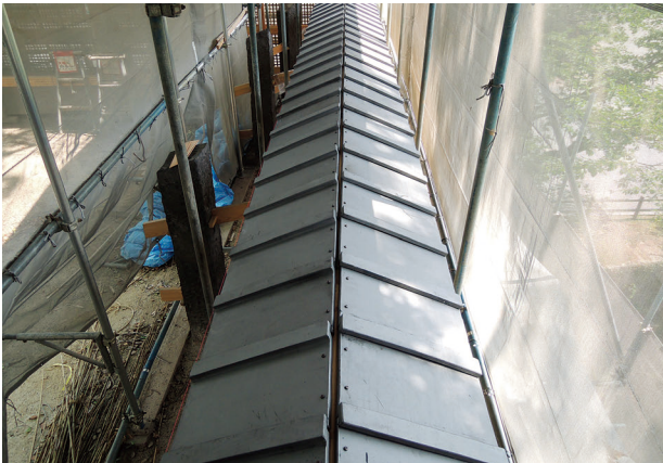
図 4-168 続塀 屋根工事 目板瓦葺
