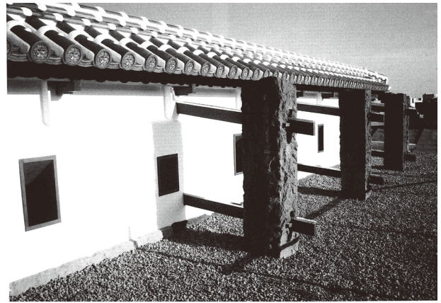
図 4-107 南大手門続堀内側
