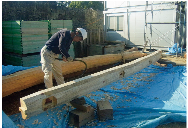
図 4-145 馬具櫓 木工事 大梁手鋸加工
