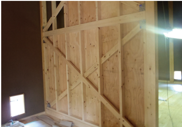
図 4-160 馬具櫓 好悪図補強工事 補強壁組立
