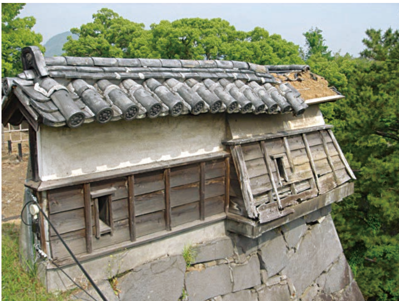
図4-7 コンクリートブロック造による平左衛門丸塀（平成23年）
