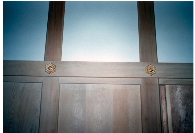
図 4-77 金具工事 錆金物（釘隠）取付
