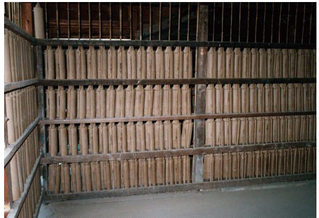
図 4-53 屋根工事 丸瓦乾燥
