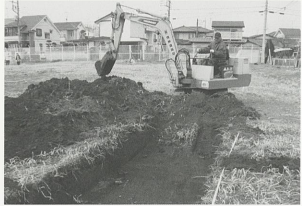
2. トレンチ掘削状況
