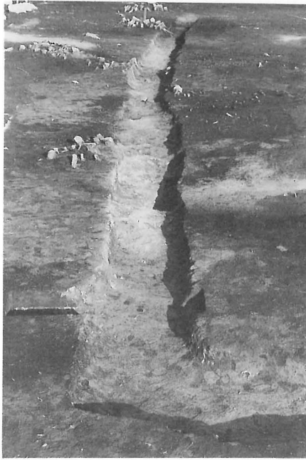
317溝完掘 (NJ～NO-435) (W→)
