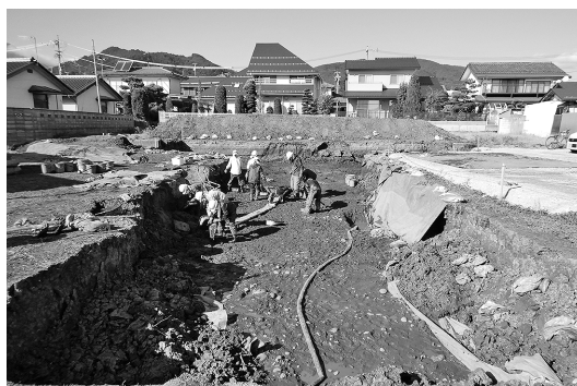
復旧作業風景
