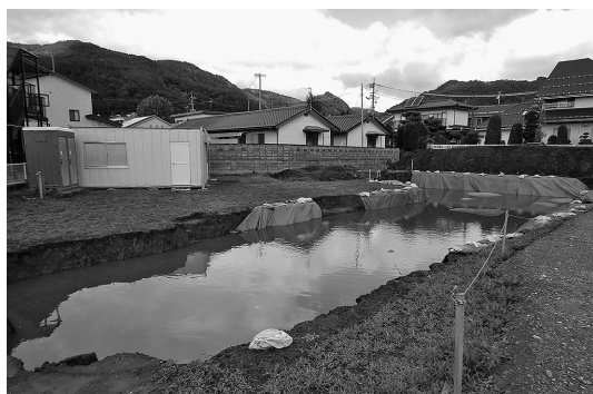
台風19号で水没した現場
