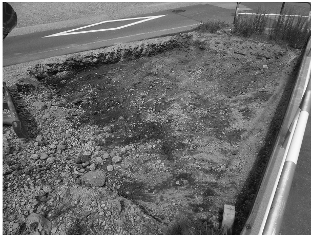
C区 表土掘削状況
