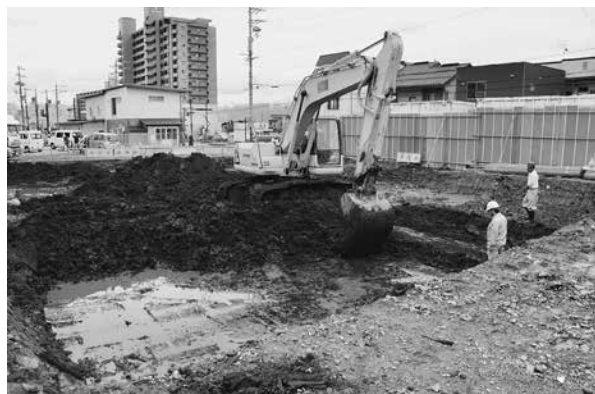
写真1 表土掘削（7月4日）
