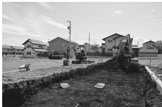
A区重機表土除去
