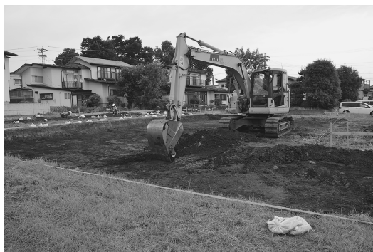
B区重機表土除去
