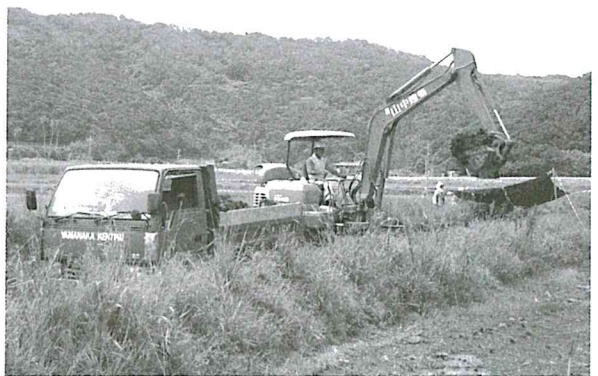
5. 一ノ坪遺跡 重機仕様状況
