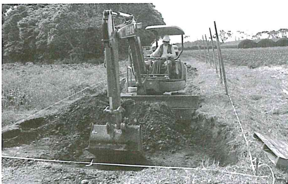
4. 植松遺跡 表土剥ぎ状況
