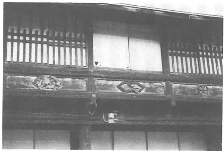
〔写真13〕 2階の表側にみられる切子格子とその下の彫刻（岡部高喜家）
