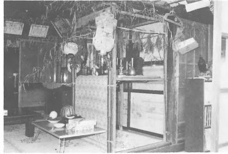
盆棚 座敷の縁側に接して組み立て、笹竹4本を立てる。(諸戸 佐藤正勝家) (撮影 関口正己)
