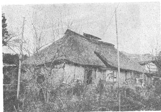
横坂 始家 (S9) 正面屋根の切落しは明治になってからの改造
