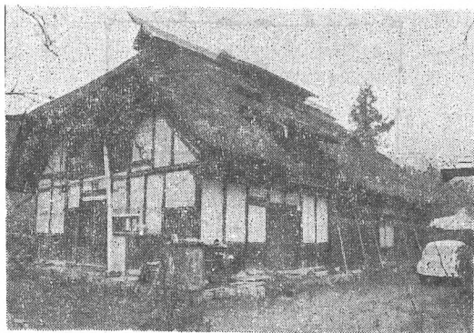
小林 辰歳家 (S 3 ) 台所側の妻屋根を「カブト屋根」の形式にして妻側より小屋裏採光を計る正面の屋根の切上げは最近の改造による
