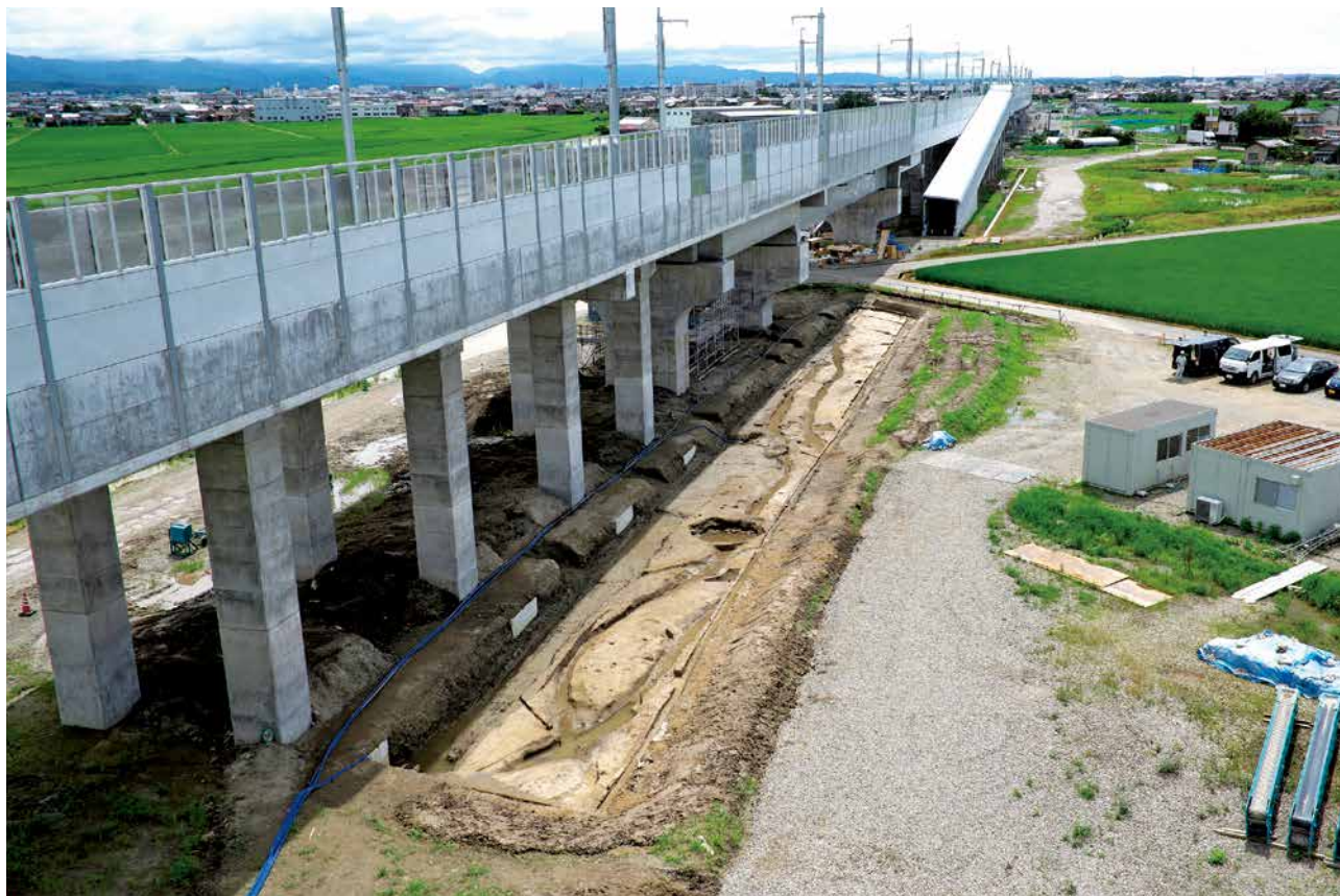
II-1区全景（北から）
