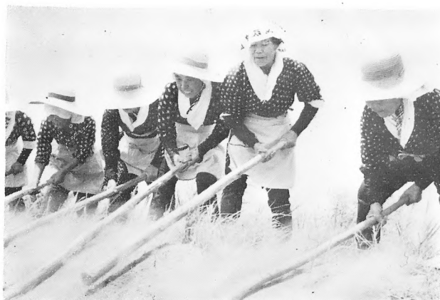
(上) 堤防工事に働いた女性達・土端唄をうたいながら連日工事に出た。(大崎福寿撮影)
