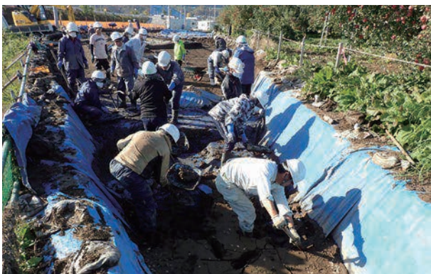
作業員による洪水土砂の除去作業
