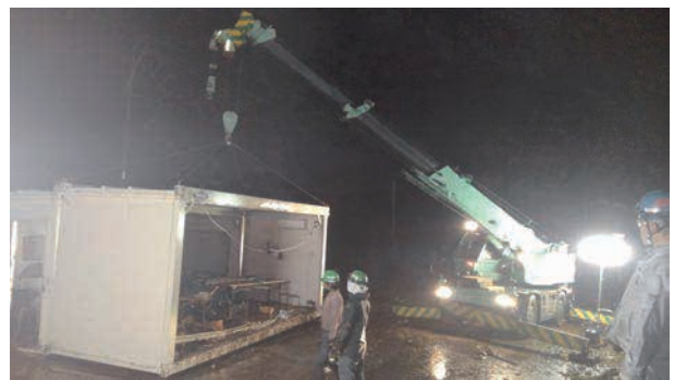
流出プレハブの夜間撤去作業
