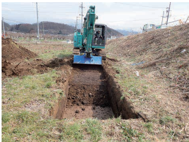
重機による表土掘削作業
