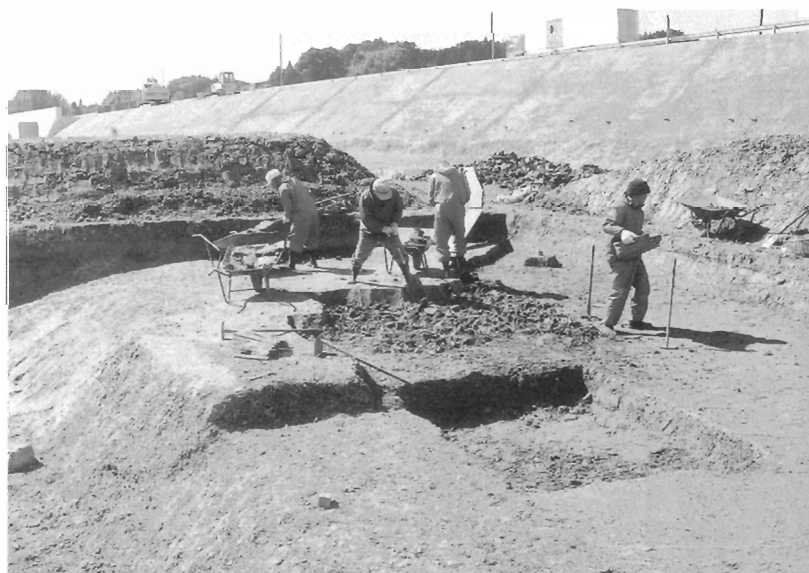
掘削作業風景
