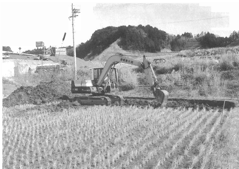
重機稼動風景
