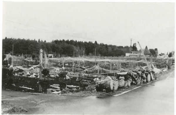
三崎VI遺跡(南東より)
