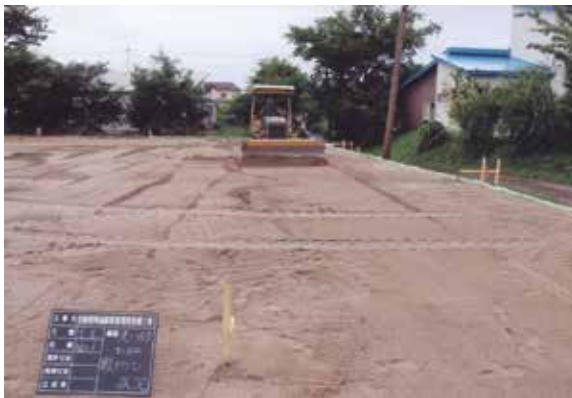
保護盛土（砂）敷き均し作業状況 (S→)
