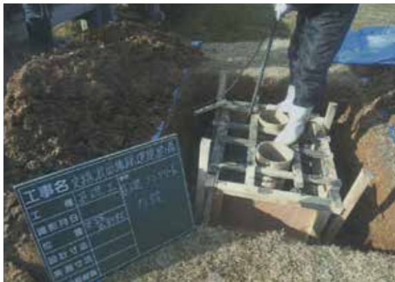
史跡名称板基礎コンクリート打設作業状況 (S→)
