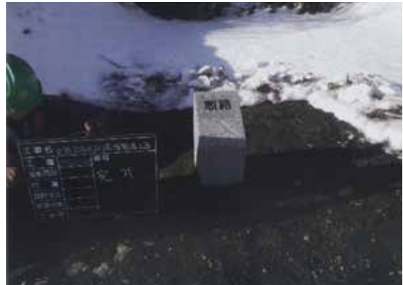
園路表示板（順路1）完成（S→）
