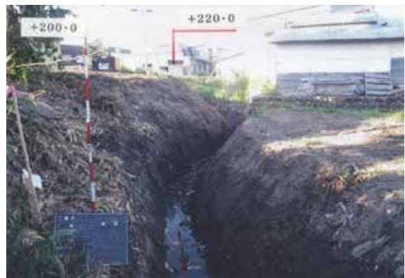
浚渫工No.0+200m地点完成 (W→)
