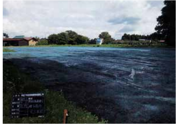
保護盛土完成 (SW→)
