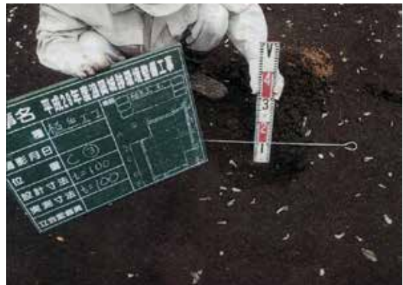
保護盛土（黒土）厚さ確認作業状況
