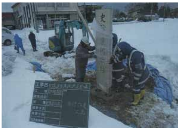
史跡名称板設置作業状況 (WS→)
