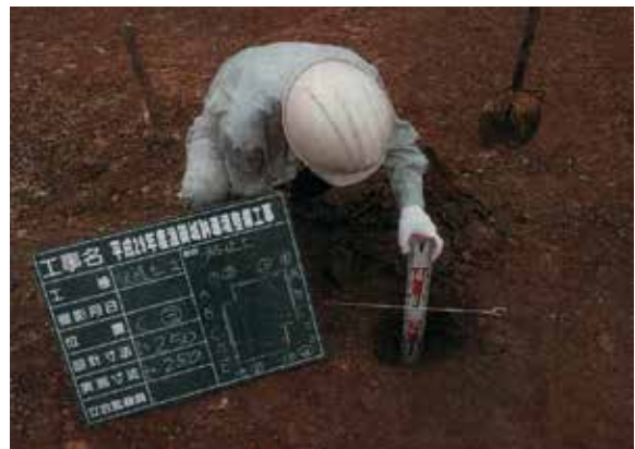
保護盛土 (粘性土) 厚さ確認作業状況
