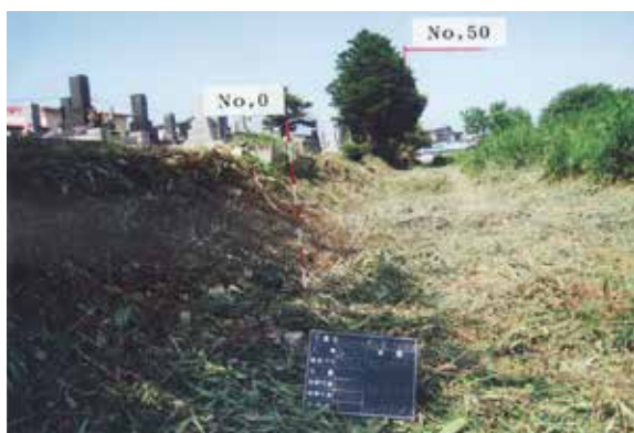
法面工・板柵工着工前 (SW→)
