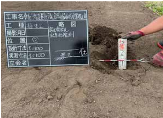
保護盛土(黒土)厚さ確認作業状況②地点 (N→)
