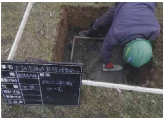
園路表示板（北館2）均しコンクリート打設作業状況
