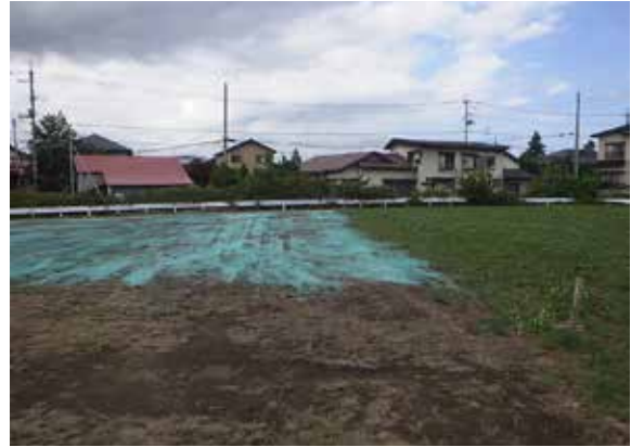
保護盛土完成 (S→)
