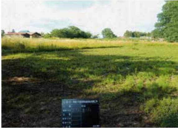
保護盛土着工前 (SW→)
