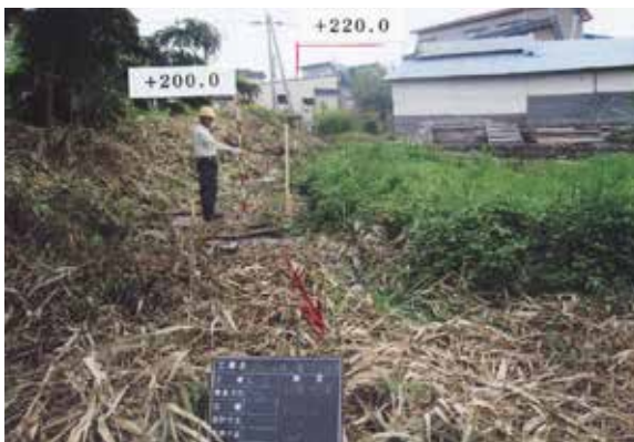
浚渫工No.0+200m地点施工前 (W→)
