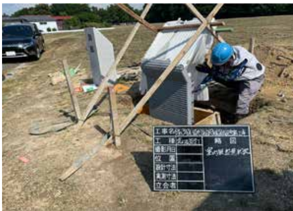
案内板設置作業状況 (NW→)
