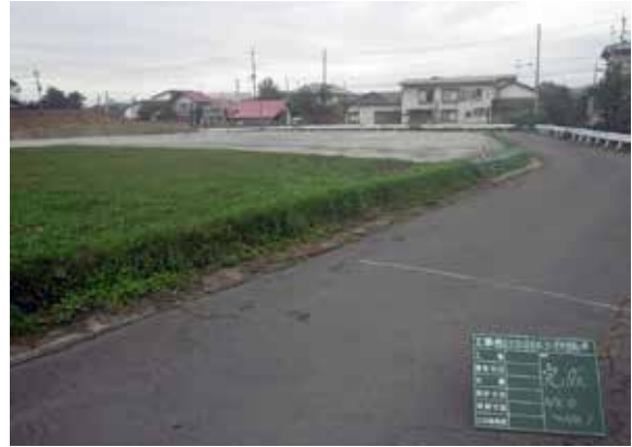
保護盛土完成 (SE→)
