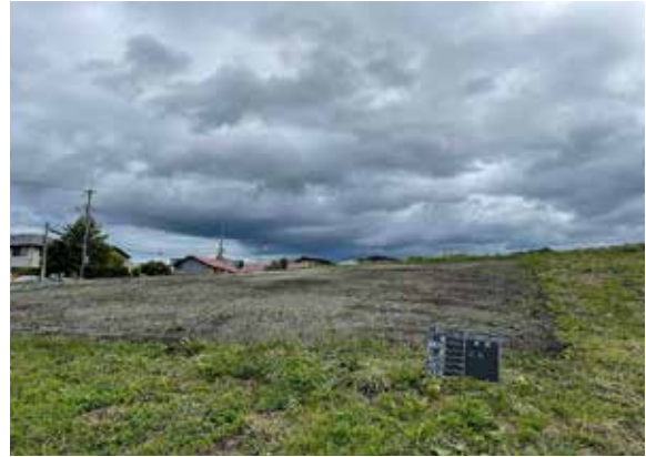
保護盛土完成 (SW→)
