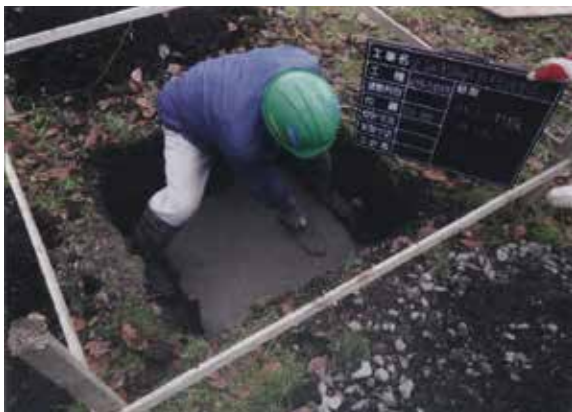
館（曲輪）名称板（内館2）均しコンクリート打設作業状況
