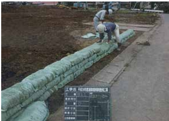
法面工・植生土のう積作業状況（S→）
