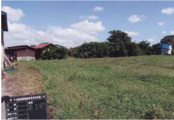
保護盛土着工前 (S→)
