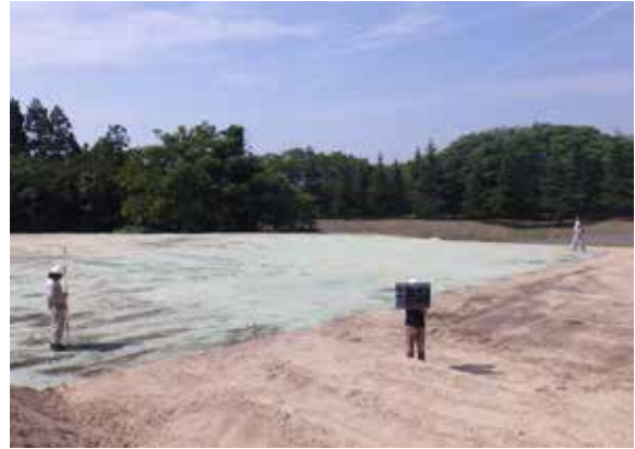
保護盛土完成 (NE→)
