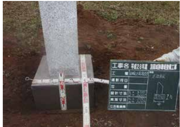
館(曲輪)名称板基礎コンクリート測定状況 (N→)
