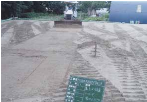
保護盛土(砂)敷き均し作業状況 (E→)
