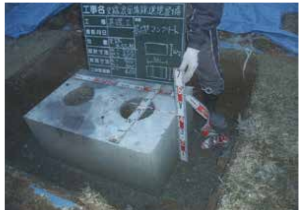
史跡名称板基礎コンクリート測定状況 (W→)
