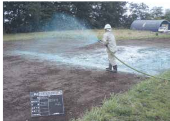
種子散布作業状況 (NE→)
