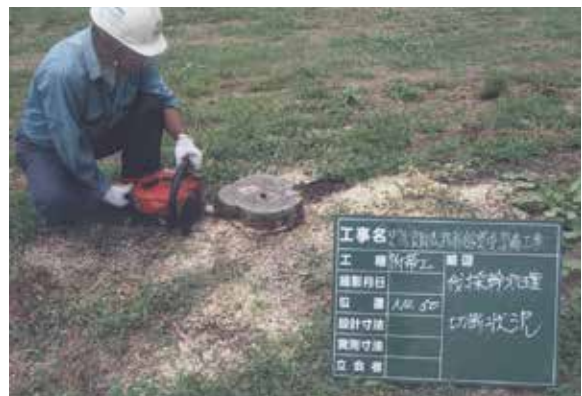
付帯工・伐採幹切断作業状況 (E→)
