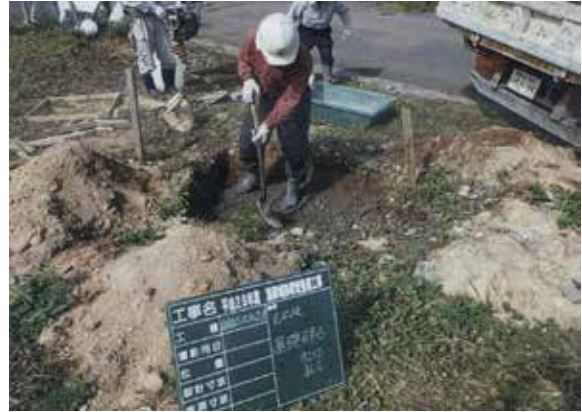
館(曲輪)名称板基礎砕石敷き均し作業状況 (S→)
