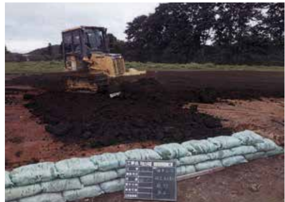
保護盛土（黒土）敷き均し作業状況 (W→)
