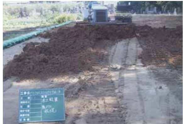
保護盛土(粘性土)敷き均し作業状況 (W→)
