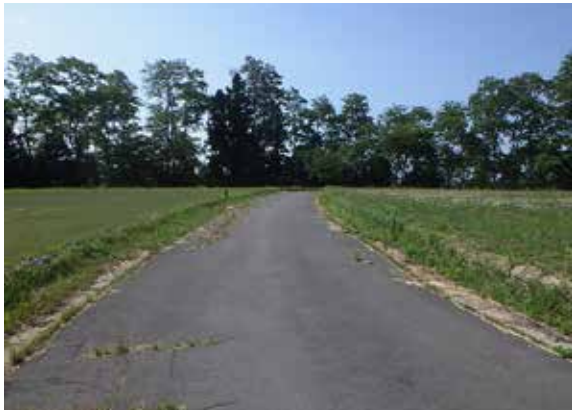
保護盛土〔旧道路部分〕着工前 (N→)
