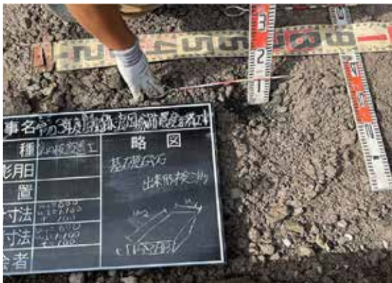
案内板基礎碎石測定状況 (N→)
