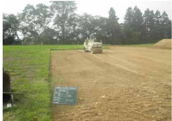
保護盛土（粘性土）転圧作業状況 (N→)
