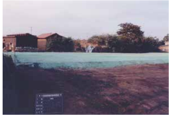
保護盛土完成 (S→)
