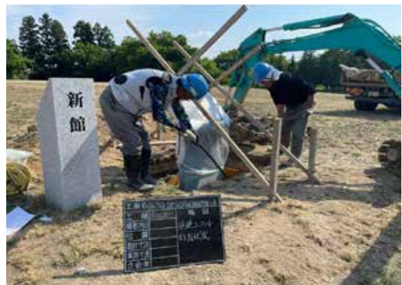
案内板基礎コンクリート打設作業状況 (NE→)
