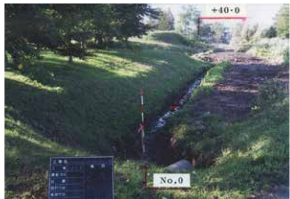
浚渫工No.0地点完成 (S→)
