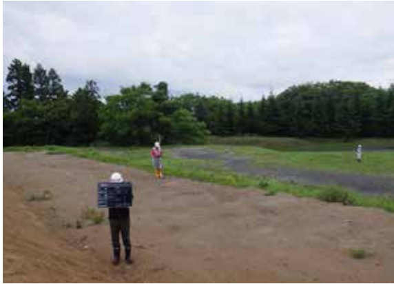
保護盛土着工前 (NE→)
