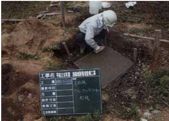
館(曲輪)名称板均しコンクリート打設作業状況 (NE→)
