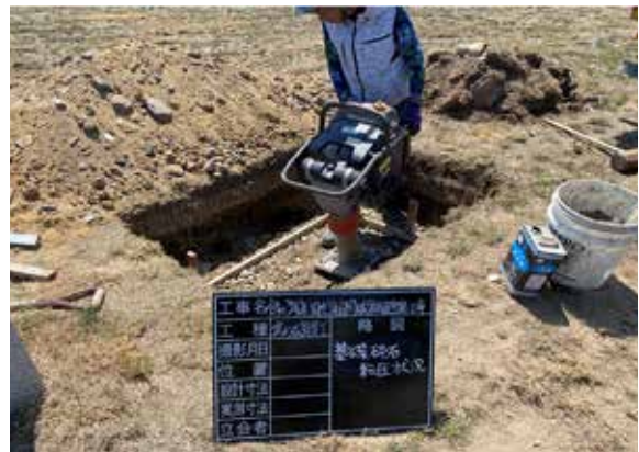
案内板基礎碎石転圧作業状況 (NE→)
