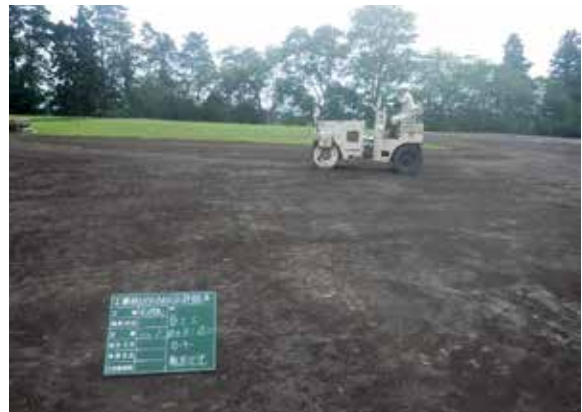
保護盛土（黒土）転圧作業状況 (N→)
