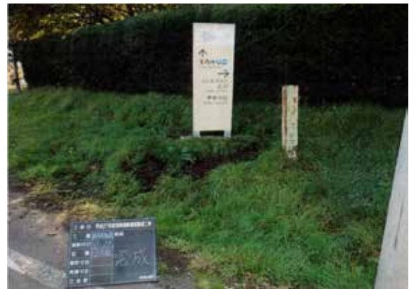
誘導標識（片面1）完成（N→）
