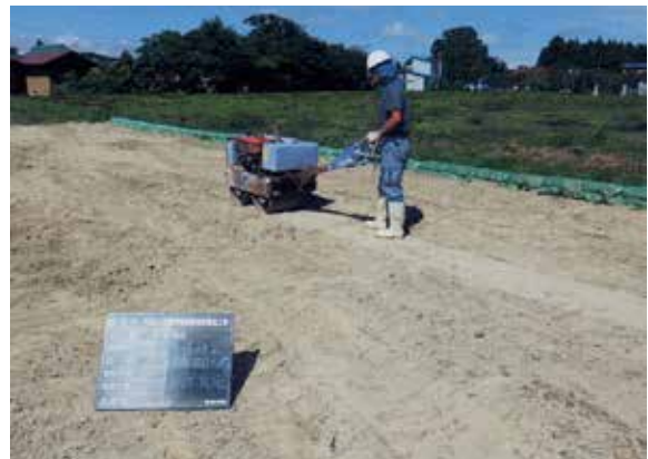
保護盛土 (砂) 転圧作業状況 (SW→)
