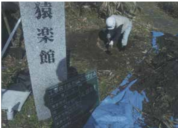
案内板1（猿楽館）掘削作業状況（S→）
