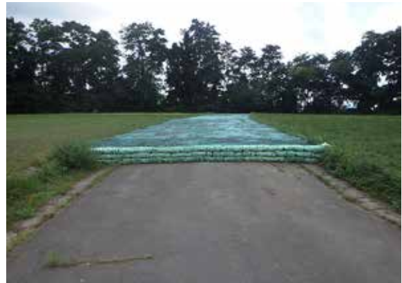
保護盛土〔旧道路部分〕完成 (N→)
