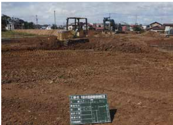
保護盛土 (粘性土) 敷き均し作業状況 (E→)
