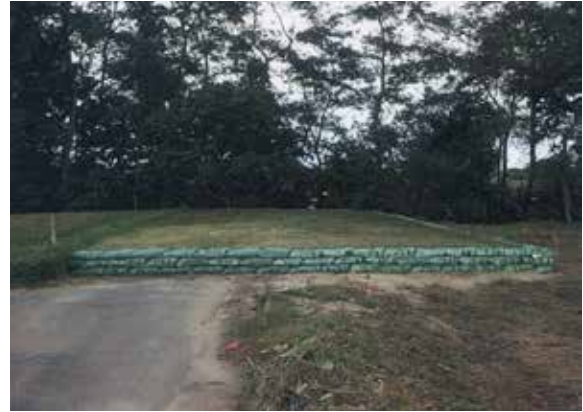
保護盛土完成 (N→)
