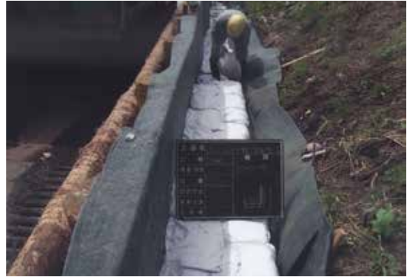
板柵工・土のう積作業状況 (ENE→)
