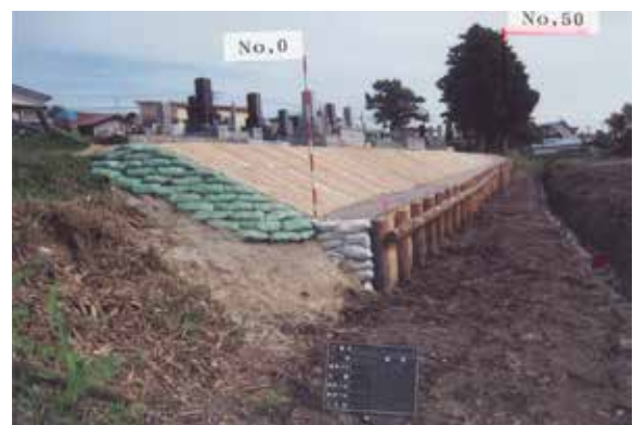
法面工・板柵工完成 (SW→)
