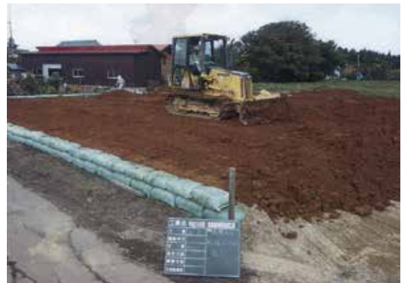
保護盛土（粘性土）敷き均し作業状況 (SW→)
