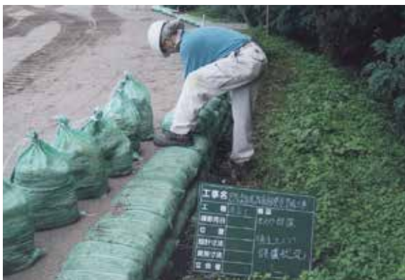
法面工・植生土のう積作業状況 (W→)
