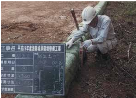
法面工・植生土のう厚さ確認作業状況
