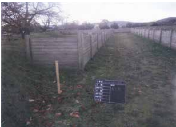
館（曲輪）名称板（北館1）着工前（W→）
