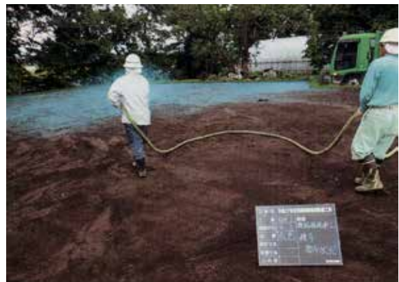
種子散布作業状況 (NE→)
