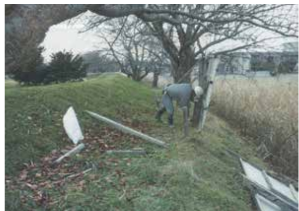
既設名称板撤去作業状況 (E→)
