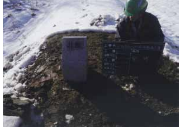
園路表示板（北館2）完成（E→）
