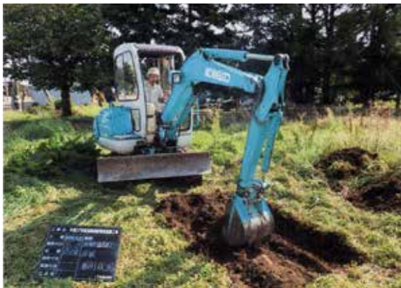
誘導標識（片面2）掘削作業状況（N→）
