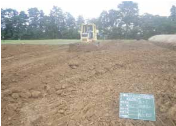
保護盛土（粘性土）敷き均し作業状況 (N→)
