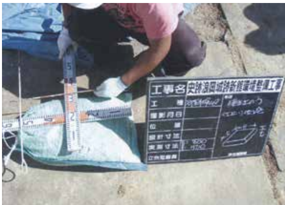
法面工・植生土のう検品作業状況
