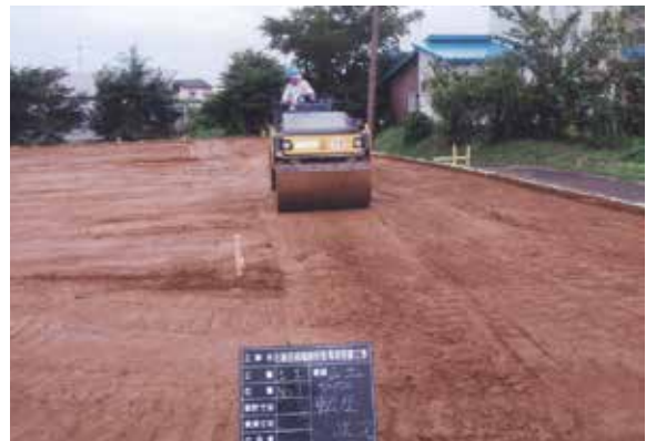
保護盛土（粘性土）転圧作業状況 (S→)
