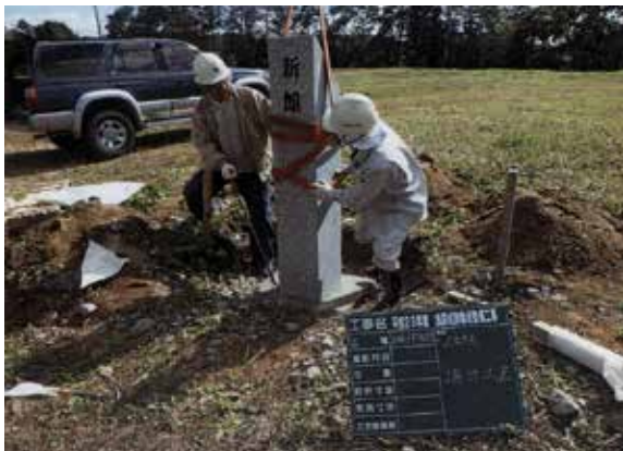
館(曲輪)名称板据え付け作業状況 (N→)
