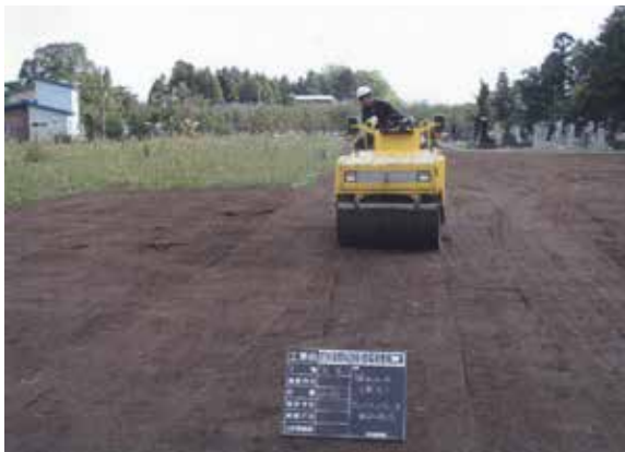
保護盛土(黒土)転圧作業状況 (W→)
