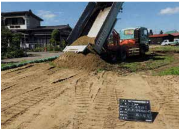
保護盛土 (砂) 搬入状況 (S→)
