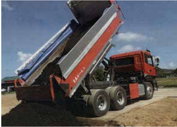
保護盛土（黒土）搬入状況（W→）
