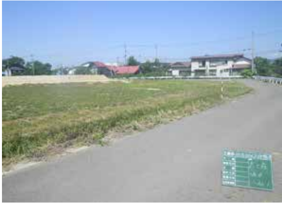
保護盛土着工前 (SE→)
