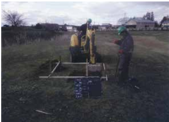
園路表示板（北館1）掘削作業状況（S→）
