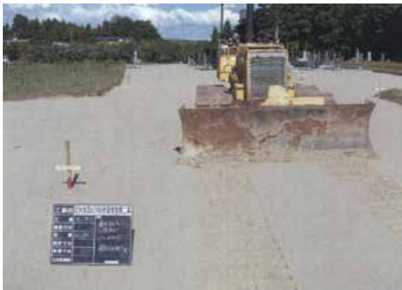
保護盛土(砂)敷き均し作業状況 (W→)
