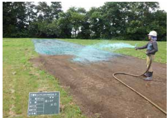
種子散布作業状況 (NE→)
