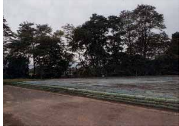
保護盛土完成1 (E→)
