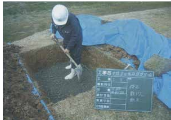
史跡名称板碎石敷き均し作業状況 (S→)
