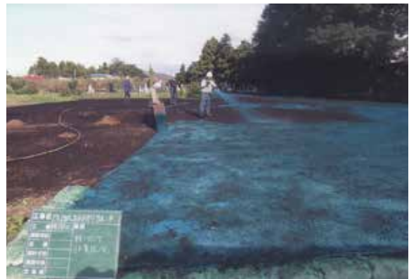
種子散布作業状況 (W→)
