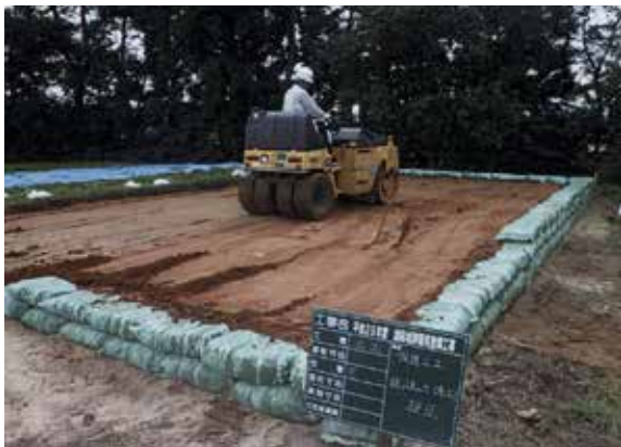
保護盛土（粘性土）転圧作業状況 (NW→)
