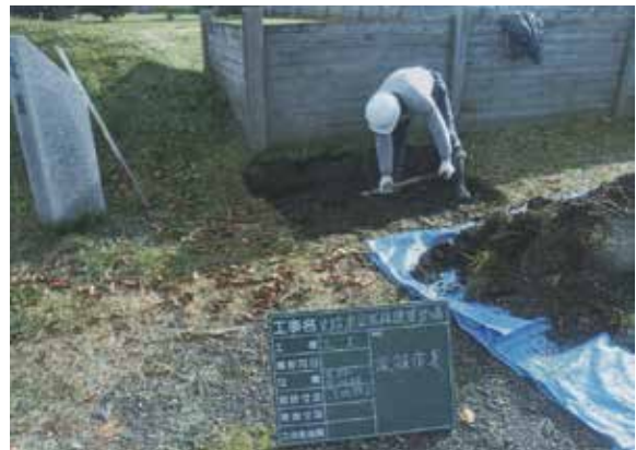
案内板2（北館）掘削作業状況（W→）
