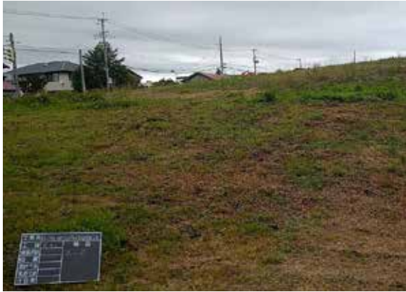
保護盛土着工前 (SW→)
