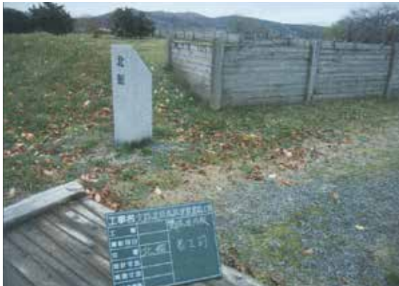
案内板2（北館）着工前（W→）
