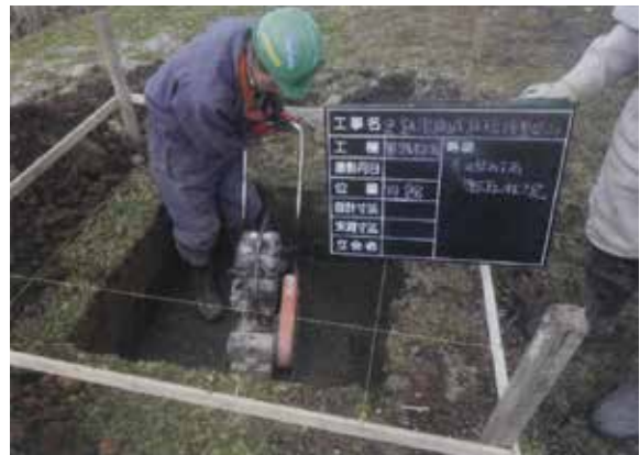
園路表示板（内館）基礎碎石敷き均し作業状況（S→）
