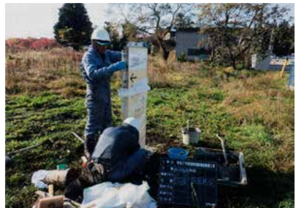
誘導標識（片面2）設置作業状況（NE→）
