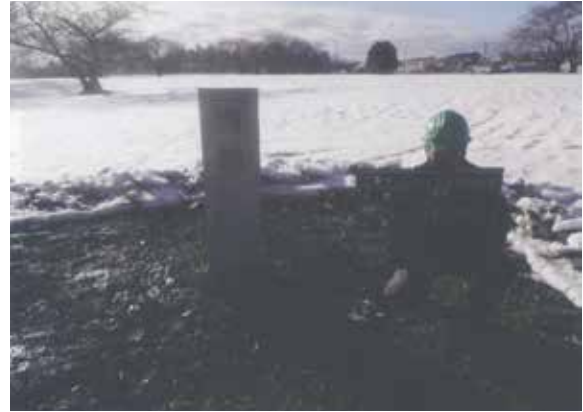
館（曲輪）名称板（西館）完成（S→）
