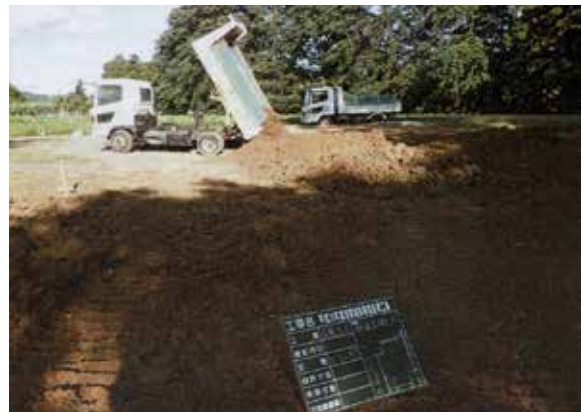
保護盛土 (粘性土) 搬入状況 (W→)
