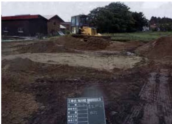
保護盛土（砂）敷き均し作業状況 (W→)
