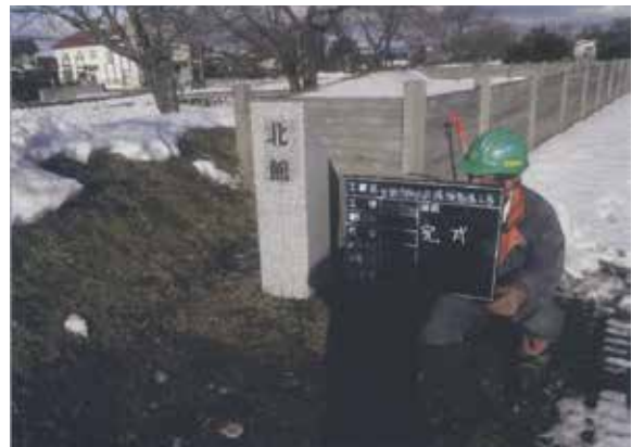
館（曲輪）名称板（北館1）完成（W→）
