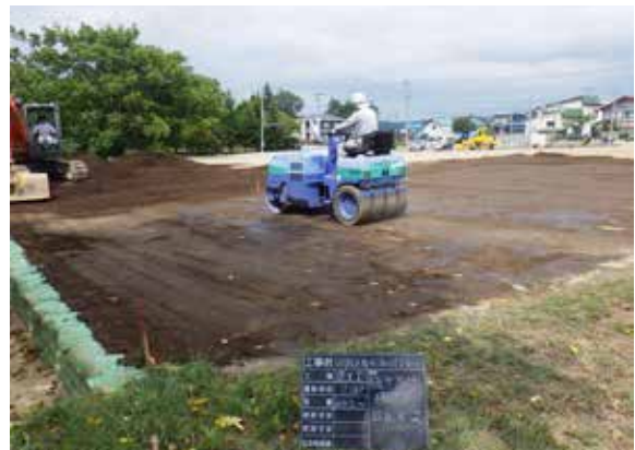
保護盛土（黒土）転圧作業状況（SE→）
