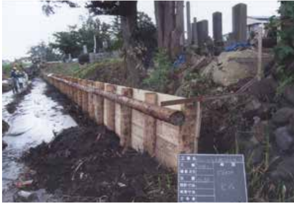
板柵設置完了状況 (E→)
