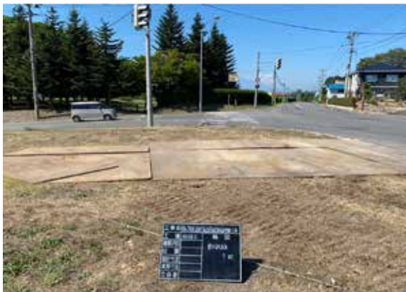
保護盛土敷鉄板設置状況 (E→)
