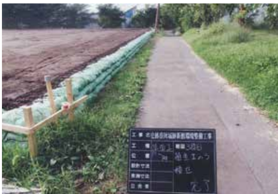
法面工・植生土のう積完成 (S→)
