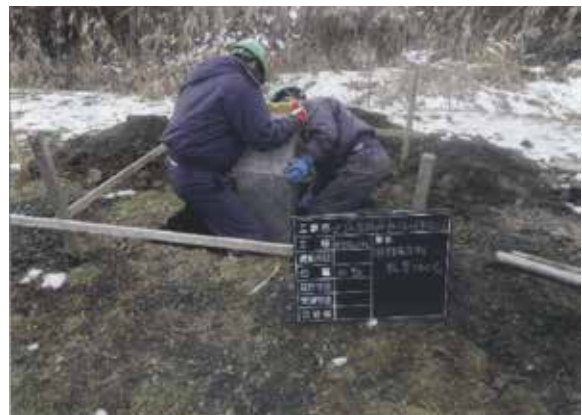
園路表示板（内館）設置作業状況（E→）
