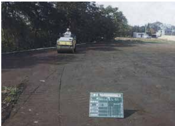
保護盛土（黒土）転圧作業状況（E→）
