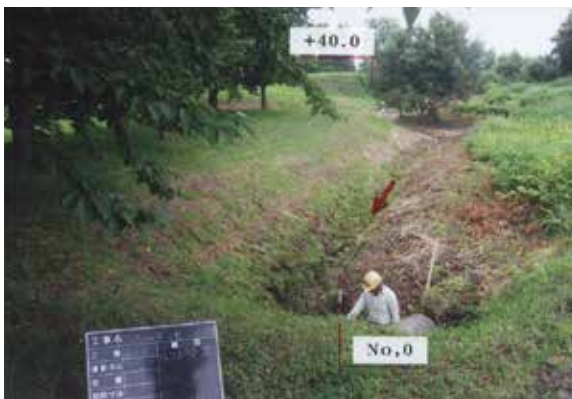
浚渫工No.0地点施工前 (S→)
