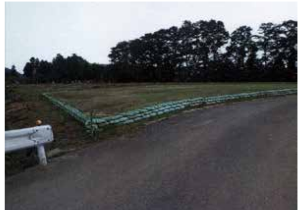
保護盛土完成 (N→)
