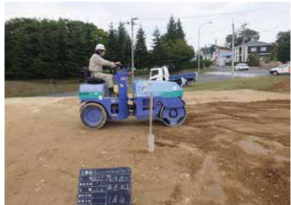
保護盛土（粘性土）転圧作業状況（E→）
