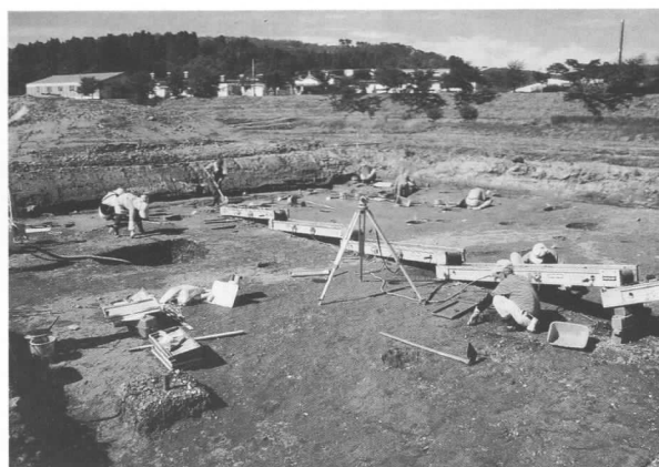
A地区作業風景 南東から
