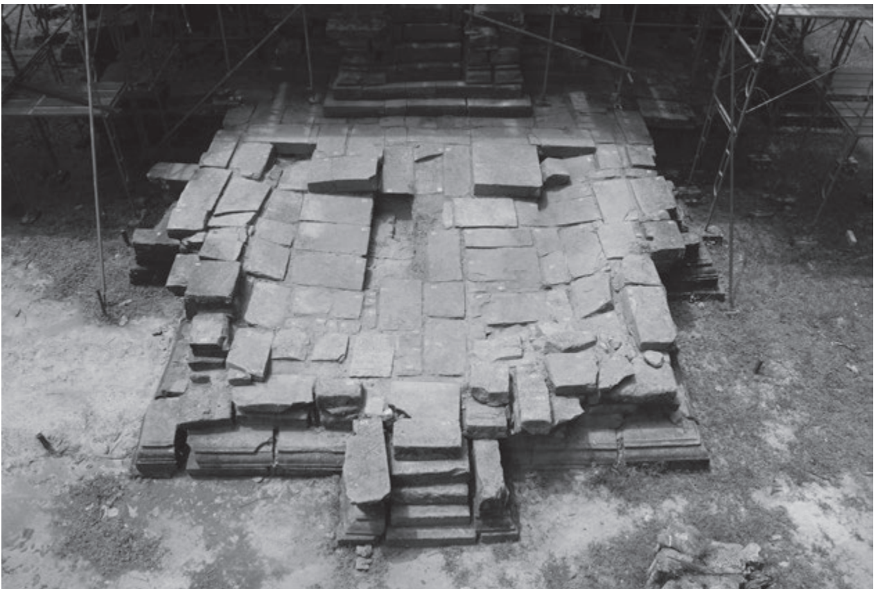
写真-5 下成基壇表層敷石の沈下
