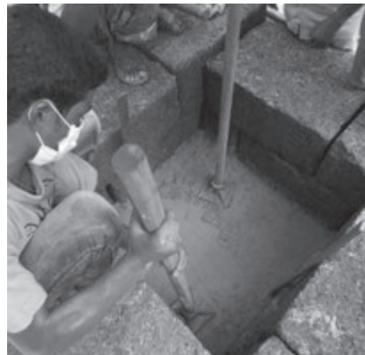
写真-17 像の足による締め固め
