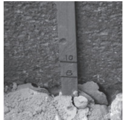
写真-15 巻きだし厚さと締め固め厚さ
