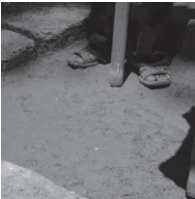
写真-16 丸い突き棒による均しと締め固め
