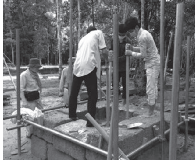
第2図 基壇土試験盛土
