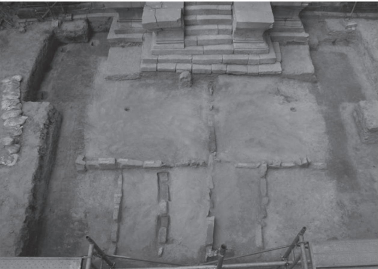
第 53 図 掘込地業と基壇内石列 (南から)
