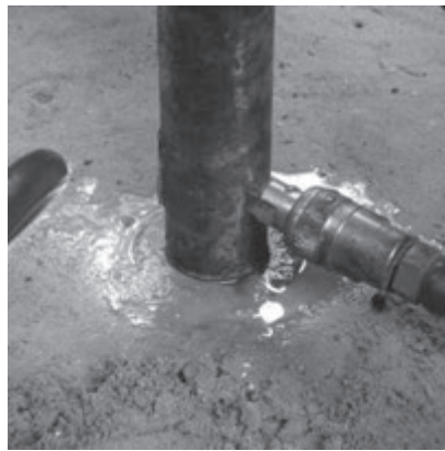
写真-23 給水による品質変化の検査
