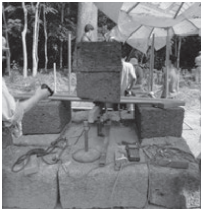
写真-22 試験盛土完了直後の 載荷試験による品質検査
