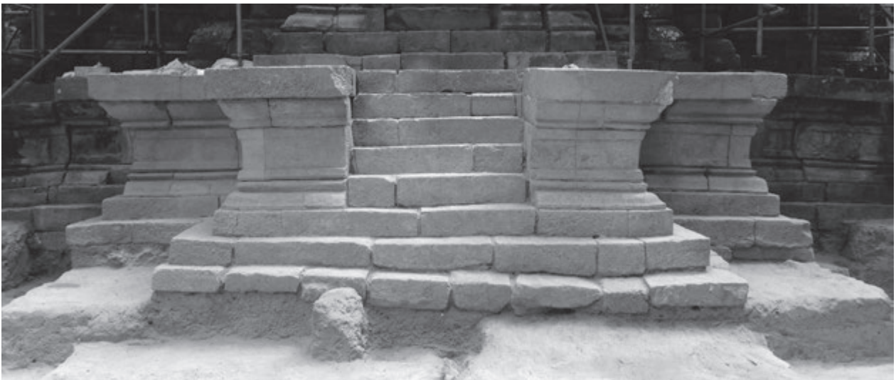
第37図 中央祠堂南階段 修復後
