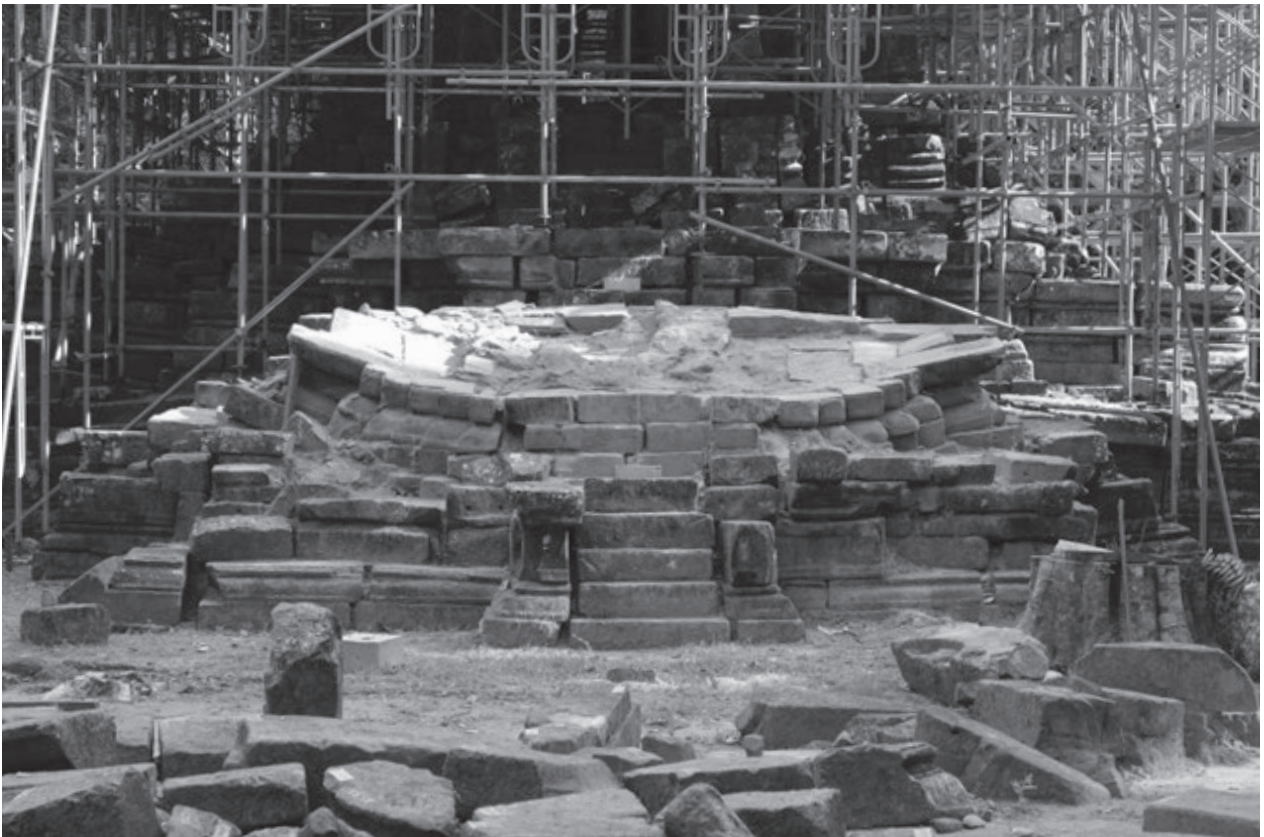
写真-4 上成基壇上面の沈下
