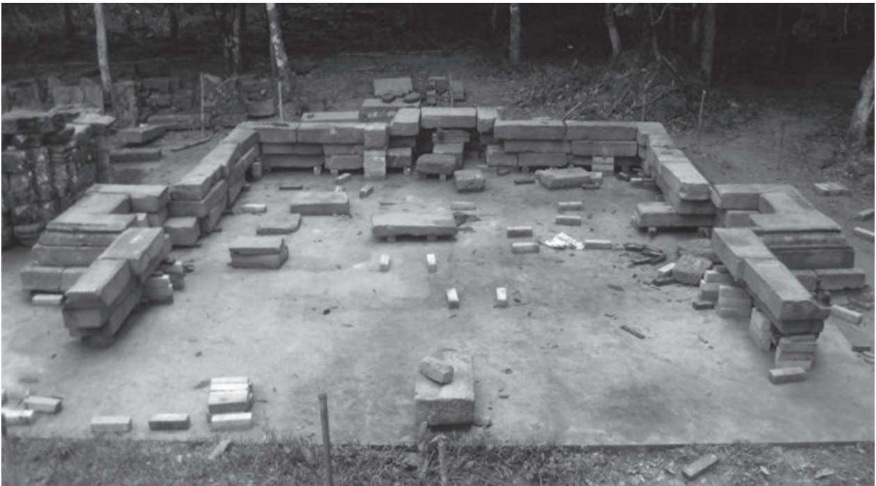
第 75 図 下成基壇の仮組（西から：2014 年 6 月 10 日）
