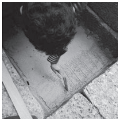
写真-20 締め固め土表面の剥離防止
