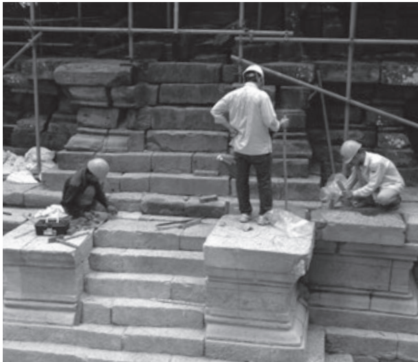
第1図 中央祠堂南階段の修復
