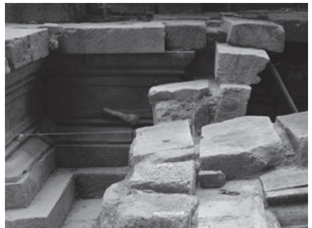
第11図 中央祠堂との取り付き（東側）
