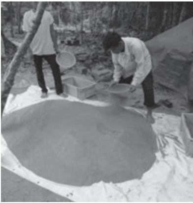
写真-10 異物の除去
