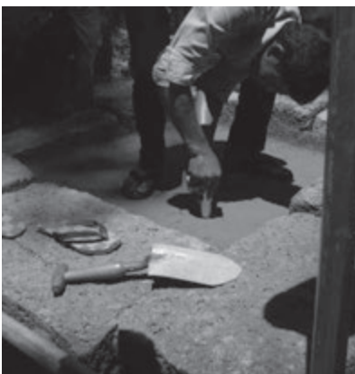
写真-19 山中式硬度計による締め固め中の管理
