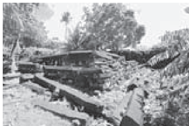
図-5. 人工島の内部・玄武岩で構築された石室
