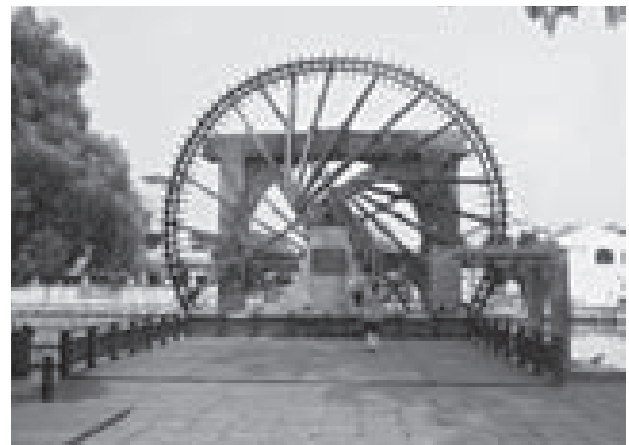
図-9. 新設された水車
