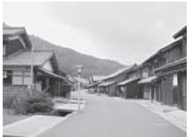
図-2. 熊川宿の町並み 1) （福井県若狭町）
