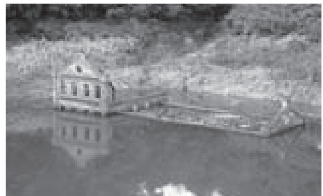
図-7. 旧曾木発電所(2007年12月撮影)
