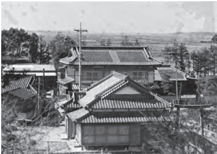
古写真 9 「昭和 47.4 自宅を曙山公園より望む」 屋根瓦に目地漆喰が施されている。窓はサッシ、戸袋が現況と同じ。
