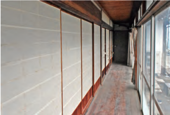
東縁 濡れ縁が室内化され、切目縁は縁甲板張りに変更。
