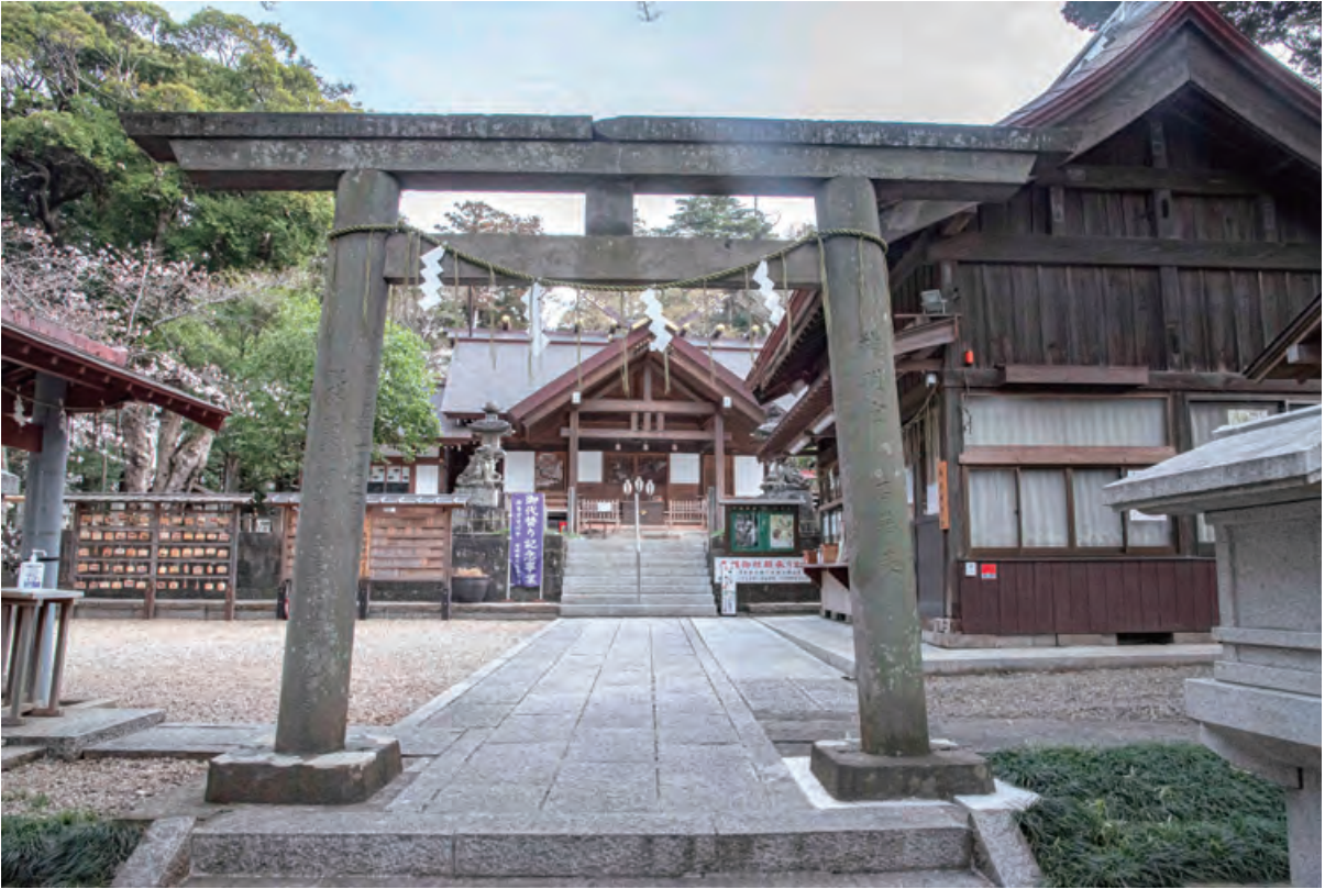
修理後の鳥居 正面
