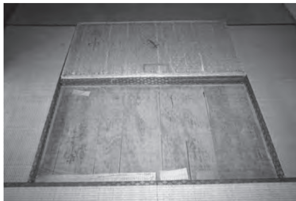
奥の間 畳の下の荒床（あらゆか）の表面には手曳き鋸による加工痕があり、常に畳が敷かれていたことがわかる。
