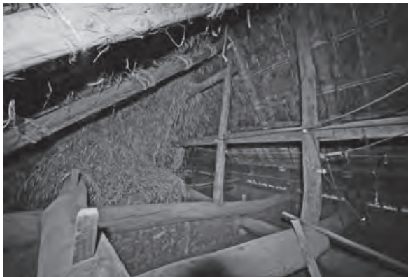
写真3 小屋組 西から東を見る
