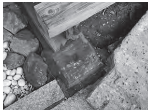
B 木階最下段（石製）の礎石天端には ホゾ穴がある、手摺りの親柱が立っていたのか。
