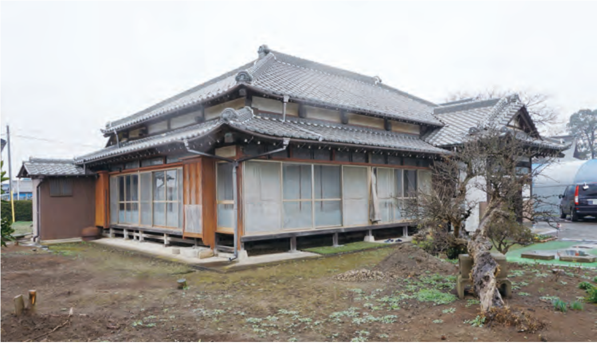
正面 南東から見る。 ザクロの古木の御神木は主屋建て替え時に残された。主屋背面にある稲荷神社はここにあった。
