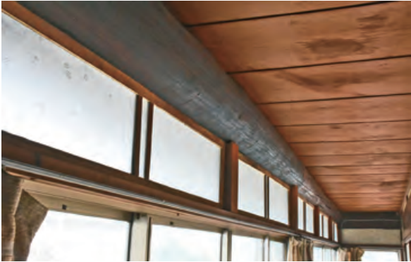
東縁 縁桁は長尺材の杉丸太。化粧合板の敷目天井、欄間は葉の模様の型押しガラス。
