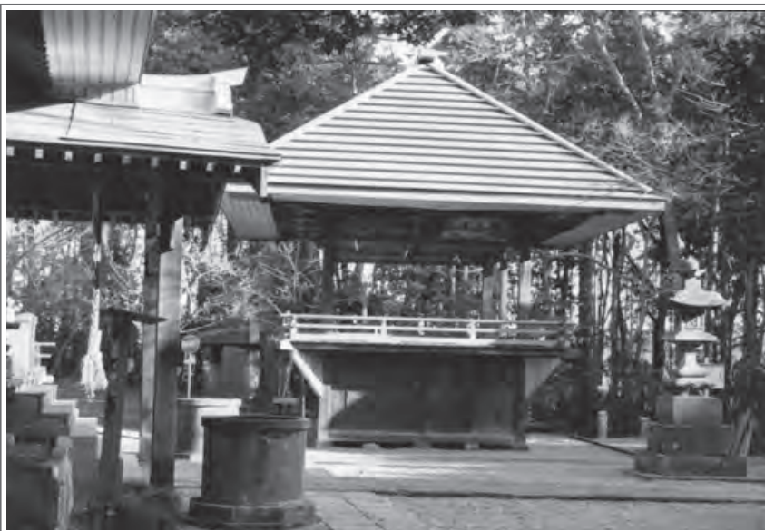
旧神楽殿床下 強固な床組が舞台を支える
