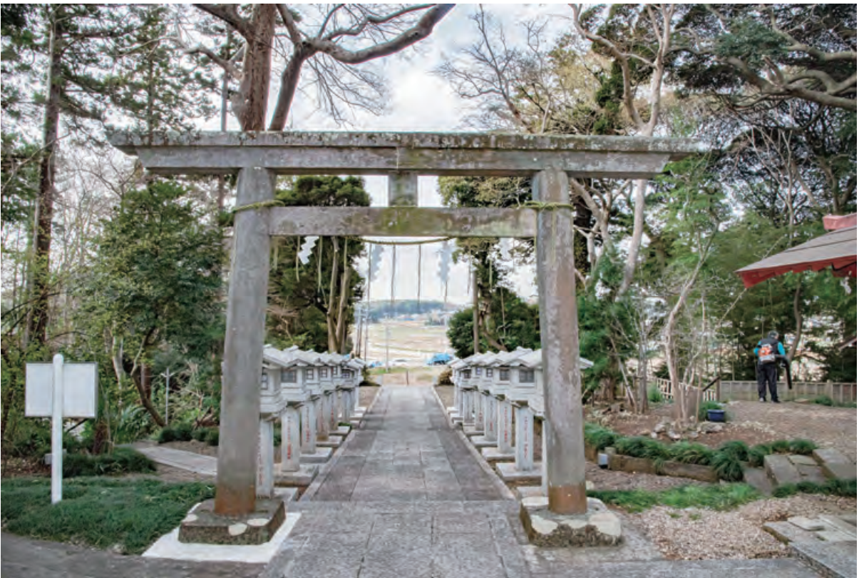
修理後の鳥居 背面
