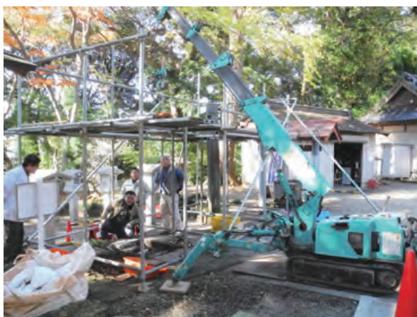
5 クレーンで根石を吊り上げて、この下の地面の状況を確認。
