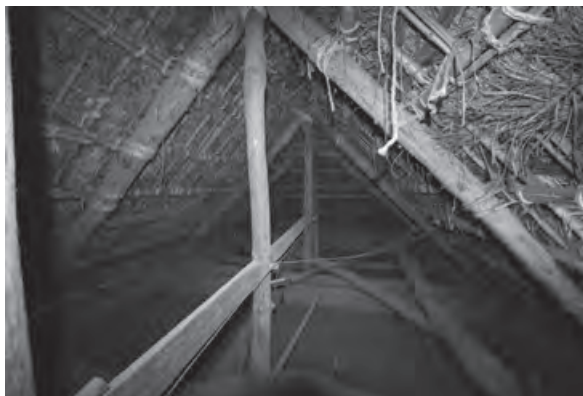
写真4 小屋組 東から西を見る
