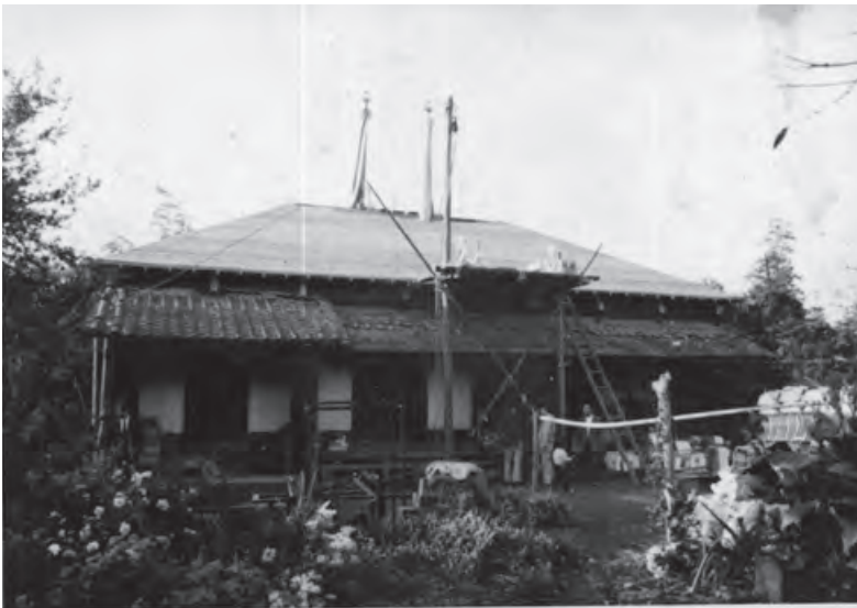
昭和 47 年（1972）の上棟式 茅葺屋根を瓦葺とするために小屋組が改造された。屋根葺替を終えた後に軒より下の工事が行われたことがわかる。画面右にこれから葺く瓦が積まれている。
