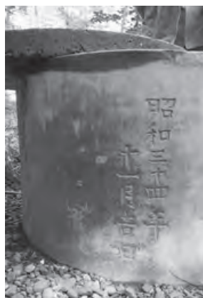
井戸筒 昭和34年(1959) コンクリート製、外形90センチ、厚さ7センチ、高さ60センチの管を重ねる。水面は7メートル以上地面より下方にあり、弁天池の湧水と同じ地下水に続くと思われる。
