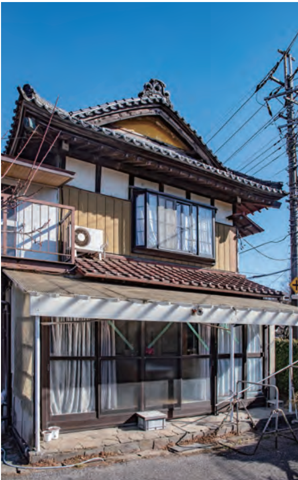
南面の台所の土間には、3台のカマドがあった。 現在は拡張され、日当たりのよいサンルームとなっている。
