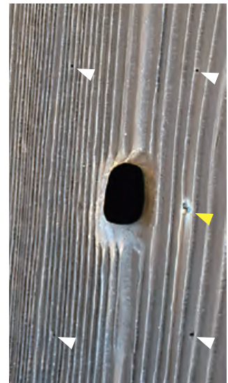
写真3 銑金物 D の銅製釘と釘 穴<春日社>
