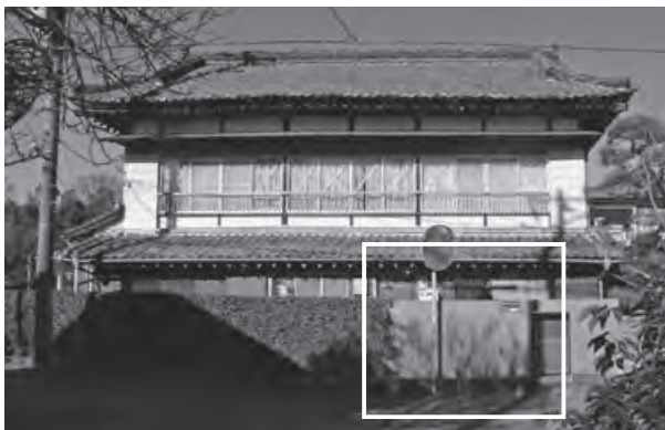
現況 古写真 6 に見る旅館玄関の位置を枠線で示す。
