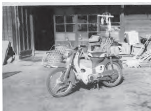
土間出入り口にはガラス戸。上手側に袖塀。 既に上げ戸はなく、出入口の間口は拡張され ガラス戸に取り替えられている。
