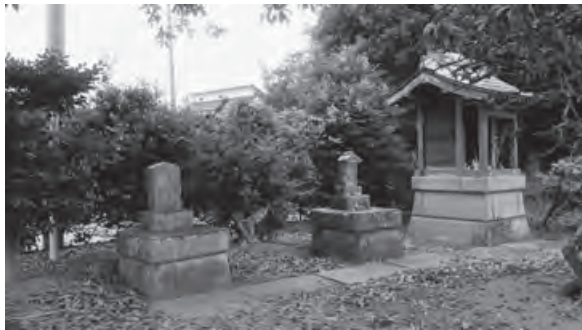
馬頭観世音・アイゼンサマ・稲荷神社の基壇は同時代に製作されている。かつて稲荷神社は主屋正面の御神木脇にあった。稲荷神社の木造覆い屋の形式や風化具合からは50年ほど前の建築と思われる。主屋を修理した1970年代初期に移設か。
