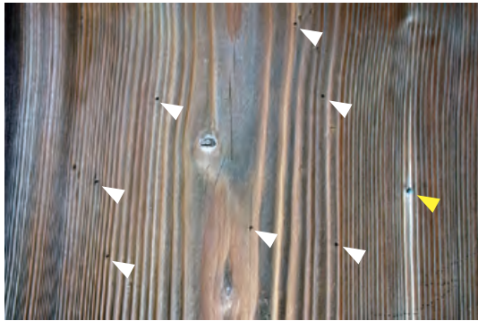
写真4 銹金物 B の銅製釘と釘穴<春日社>
