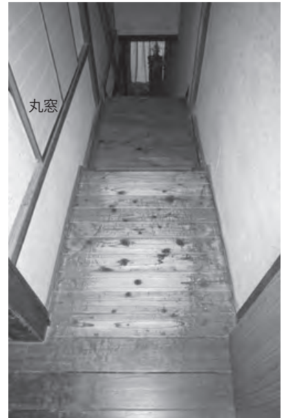
2階踊り場から見る階段 丸窓外側の障子戸が見える。当初は 急な階段が画面手前寄りから始まった。
