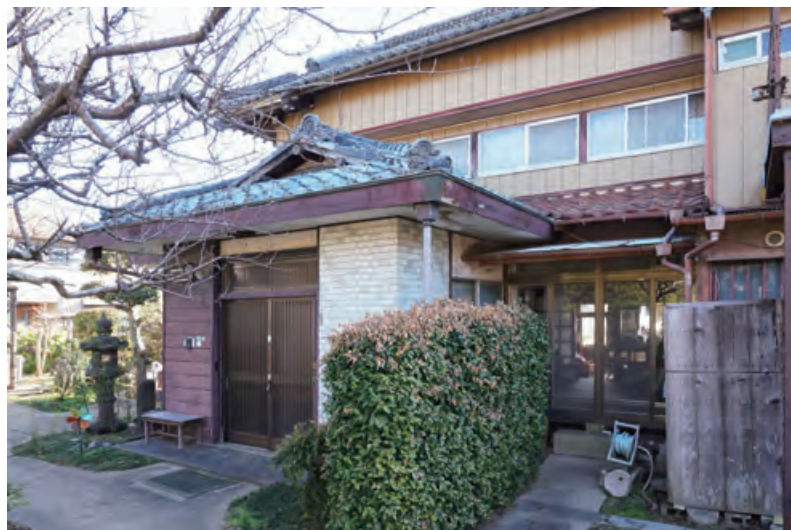
背面に新設された玄関。住宅への改造時に正面玄関は閉鎖され、台所が造られた。
