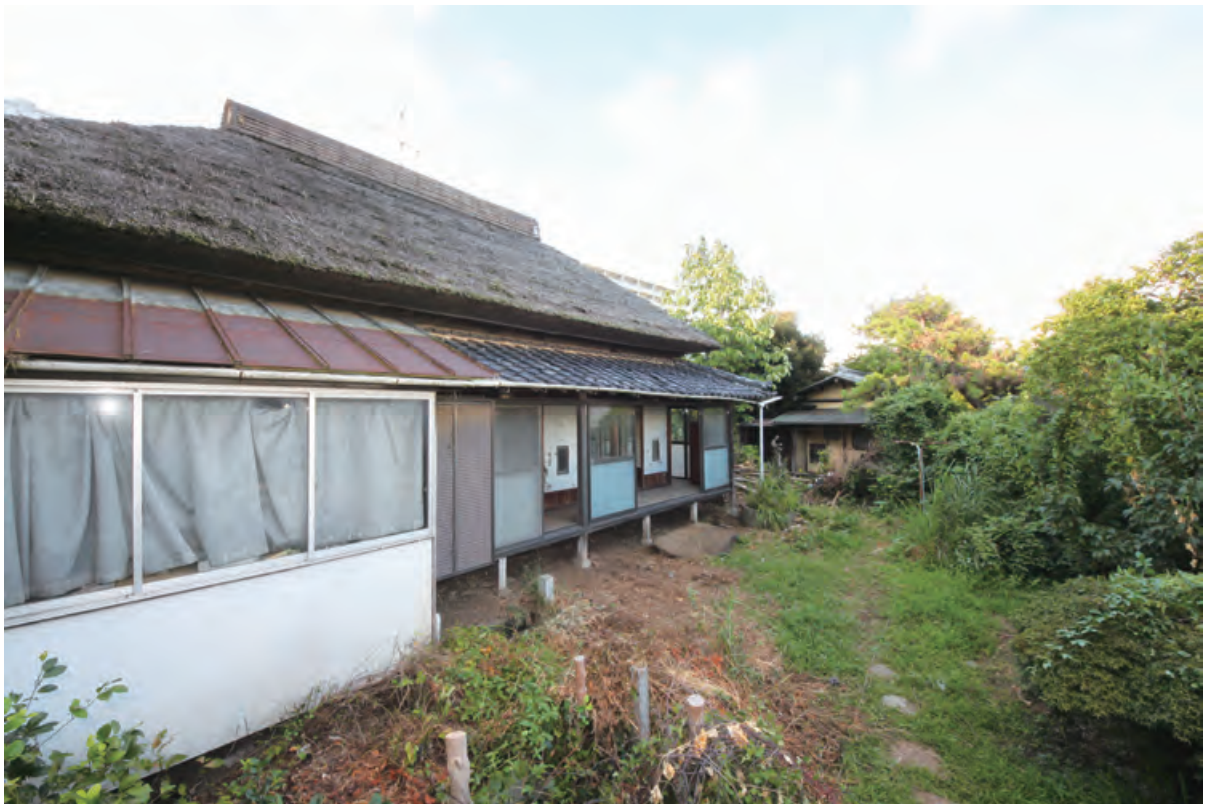
外観 斜め（西から）
