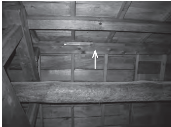
小屋組に打ち付けて残されていた幣串。年号など修理の詳細を示す墨書はなかった。
