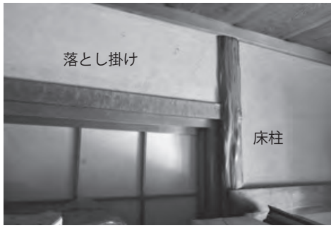
居室3 北壁には棚廻りの造作が残る。 杉絞り丸太の「床柱」とモミジの落とし掛け。 腰高の棚が階段の上方に突き出していた。
