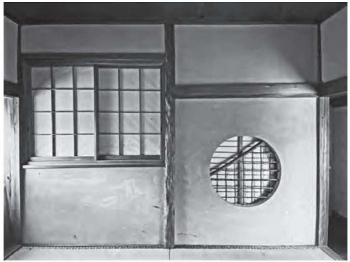
居室3 北壁全景 棚と丸窓から構成される。 棚は撤去され、階段室上方に開く障子戸が建て込まれている。
