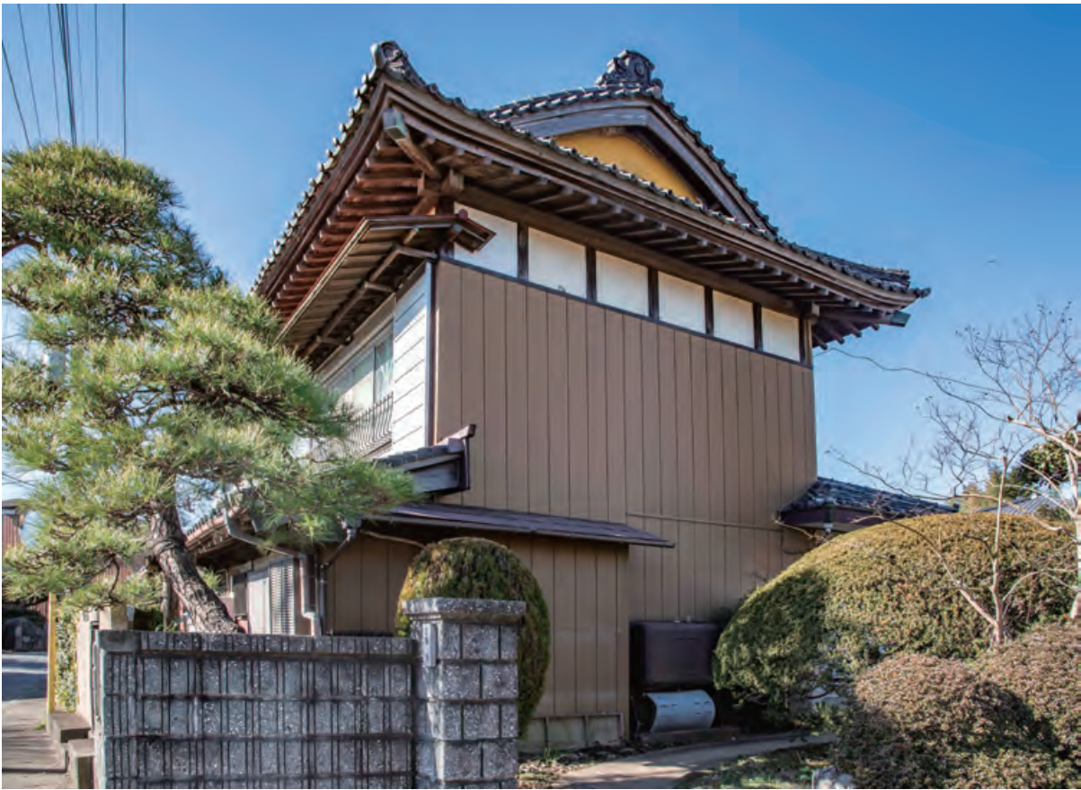
北東から見る 隅に反りのある重厚な軒廻りと入母屋造の屋根。 北面の小さな庇がかつての出入口の位置を示す。 この向かって右側に、平屋の女中部屋が取り付いていた。
