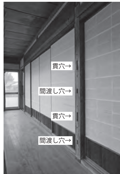
④ 式台玄関袖壁の土壁が取り付いた痕跡
