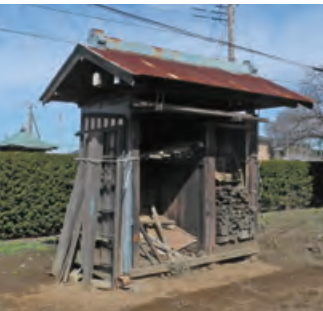
主屋背面に立つ新小屋 便所の建物を転用。 右図画面右に屋根が見える。
