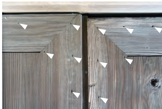
写真5 銹金物 C の釘穴<春日社>
