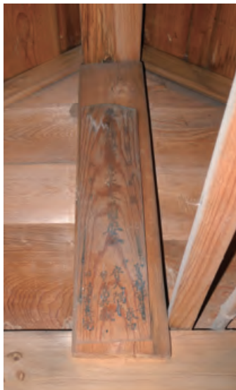
石鳥居札発見状況 御正殿東妻の束に釘打ち止め
