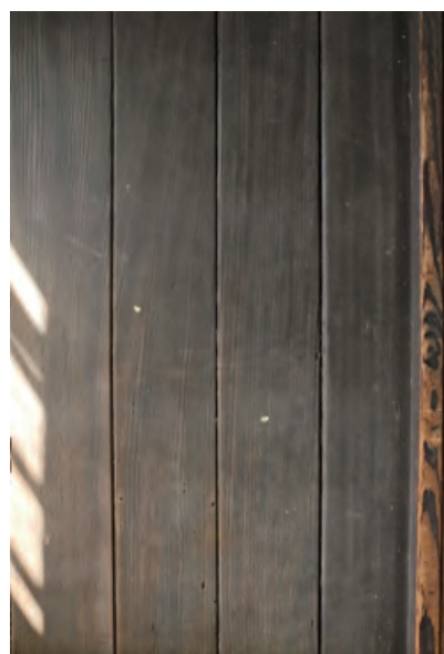
イチョウ材の廊下床板
