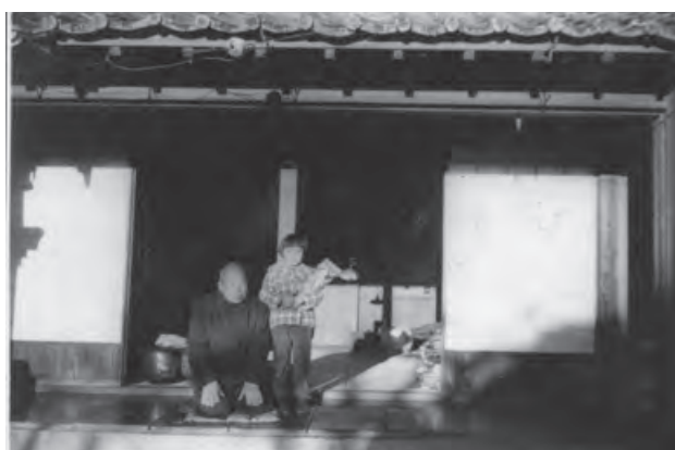
座敷前の東縁は幅広の板を並べる切目縁（きりめえん）。 庇は棧瓦葺、縁境は障子戸、室内は畳敷き。
