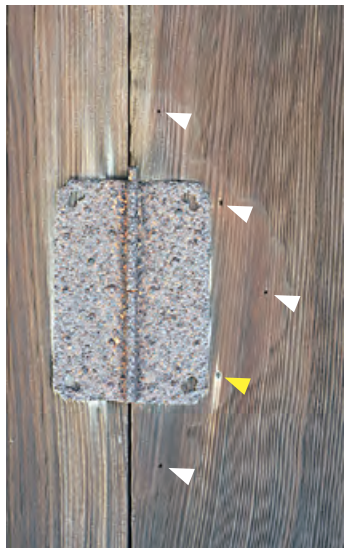
写真2 銑金物 A の痕跡と銅製釘、 釘穴<春日社>
