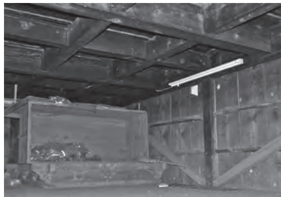
旧神楽殿床下 強固な床組が舞台を支える
