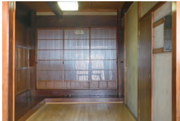
土間一勝手境の千本格子の建具 土間から見る。
