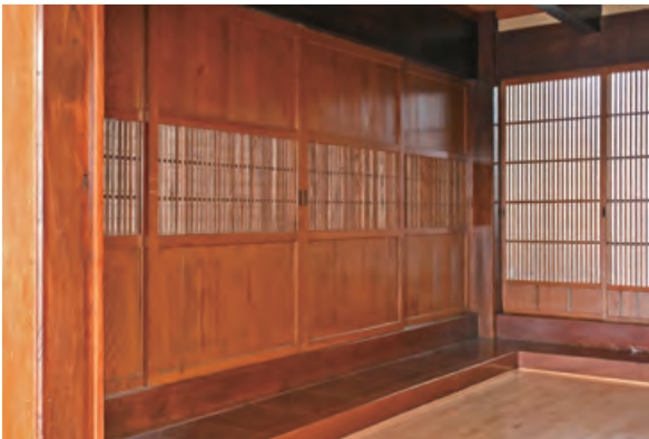
土間一座敷境の板戸 土間から見る。
