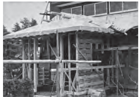
古写真 10 背面玄関増築中 2階の開口部は1間の間に引違窓
