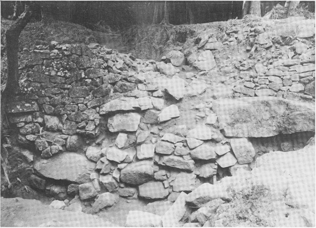
第 8 図 大 石 垣 の 積 石 状 態
