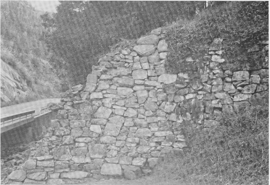
図版 7 百間石垣（左岸、下流よりみる）
