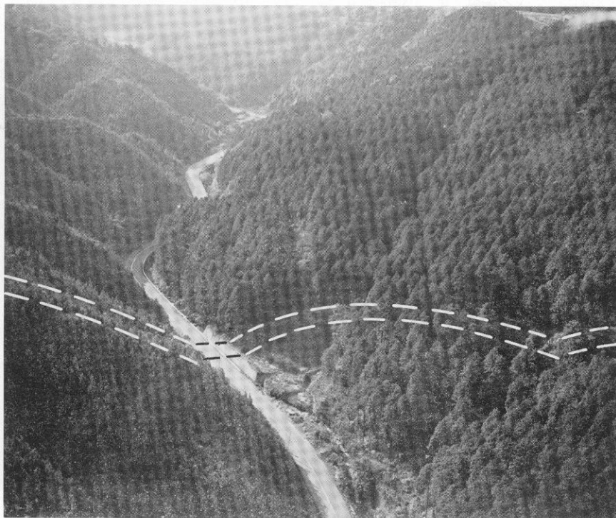
図版 5 百間石垣遠景から（北から）
