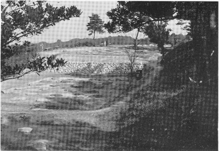
図版5 (I. 増長天地区礎石群整備状況)
