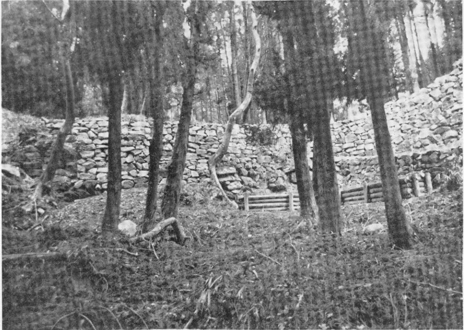
図版3 (Ⅱ. 大石垣遺構復原保全工事)
