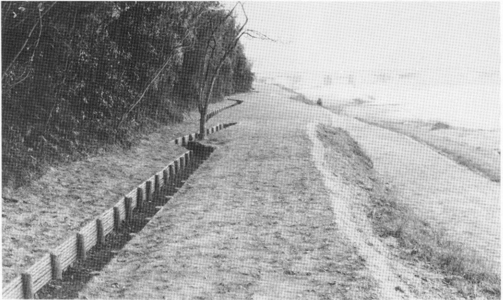
図版14 国分側土堤保全修景工事
