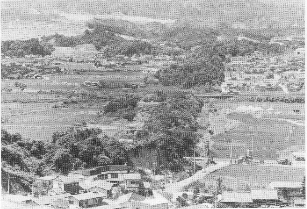
図版 2 水城大堤全景（昭和48年自動車道建設前）
