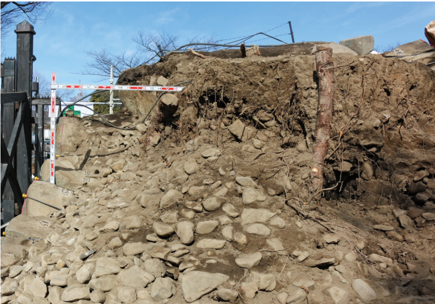
図版 11 盛土部（南から）
