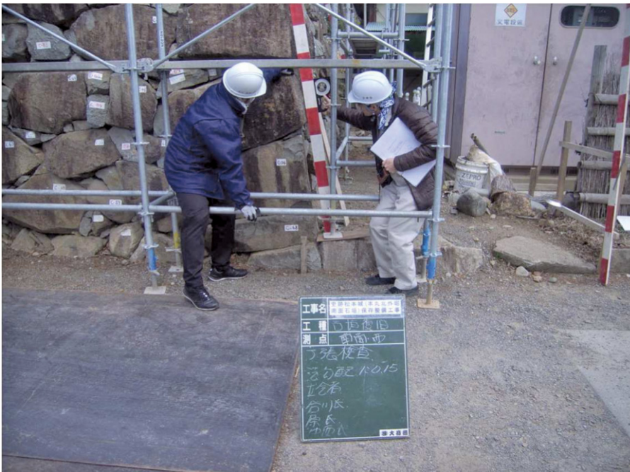
図版 30 丁張確認 検討の結果、復旧勾配は南東隅で 1.5 分勾配とし、丁張を行った。
