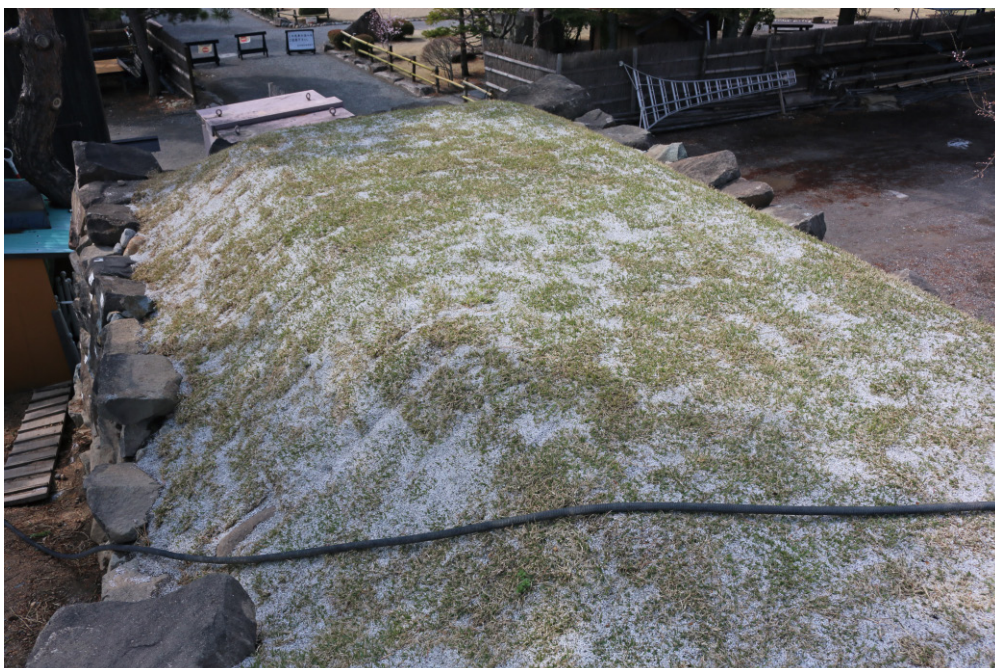
図版6 竣工後（上面） 石垣上面は、石垣北側の高さと同じになるよう盛土を行い、貼り芝で整備した。
