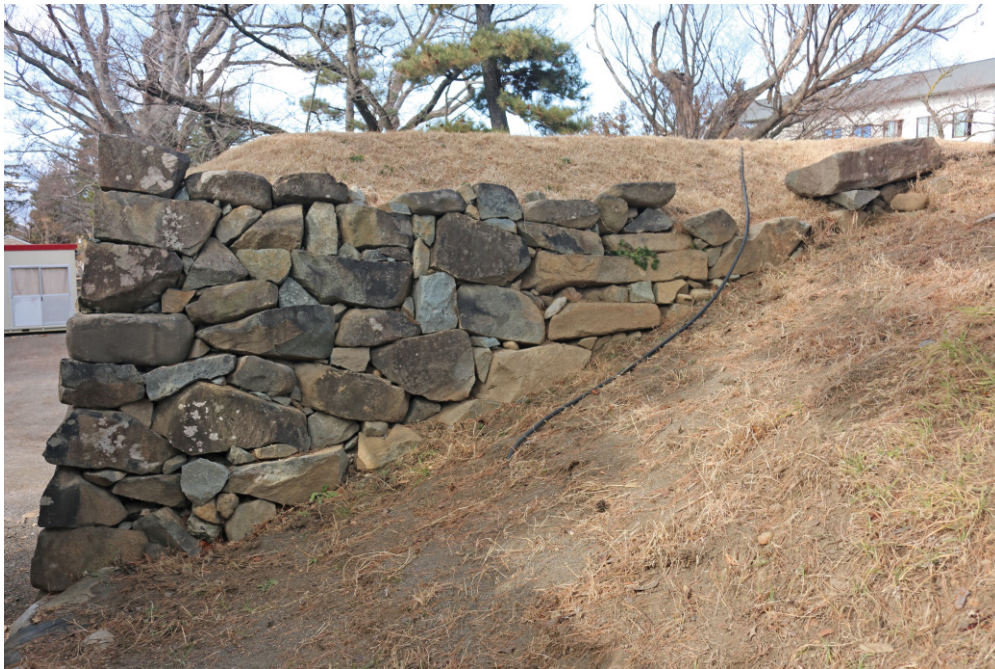
図版5 竣工後（東から）
