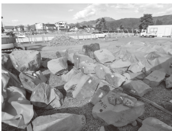
5. 解体築石仮置場 01
