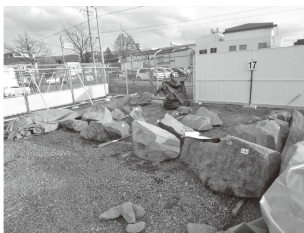
6. 解体築石仮置場 02
