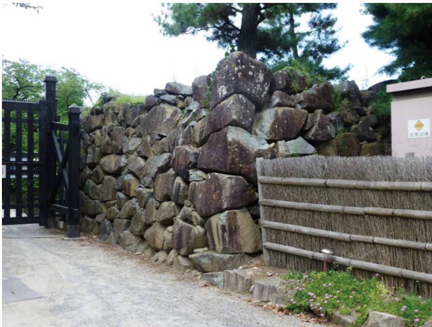
図版 1 着手前（南西から）
