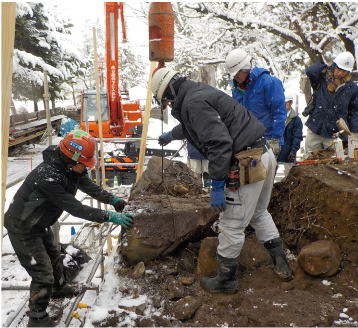
図版7 解体中（築石解体） 大型クレーンを使用し、一石ずつ取外しを行った。
