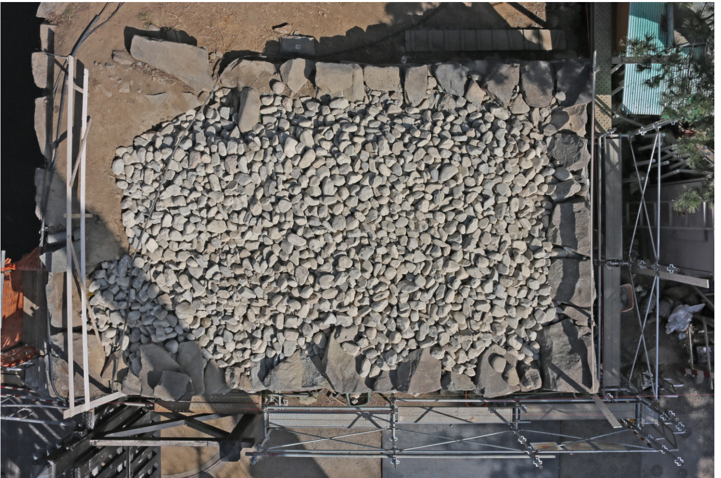
図版 33 積み直し（上面整備前） 盛土に遮水シートを敷いたうえで全面栗石を敷き詰めた。
