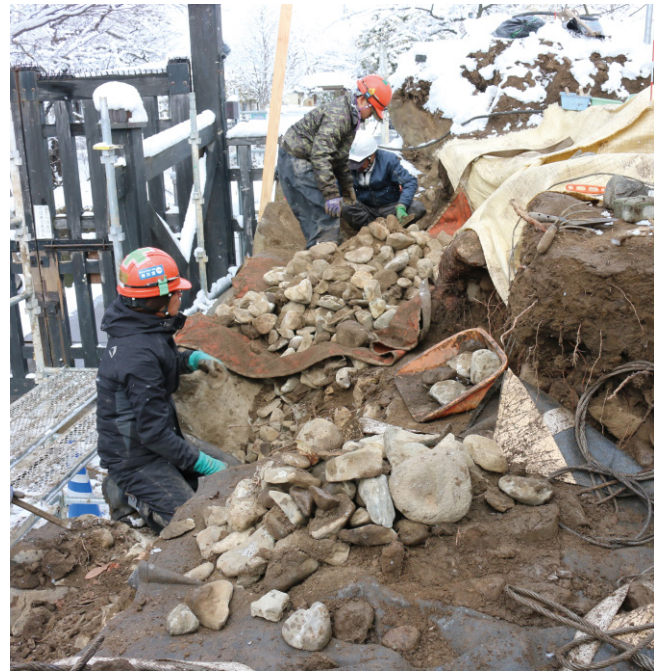
図版8 解体中（栗石解体） 栗石はもっこにまとめ、大型クレーンでつり上げて移動した。
