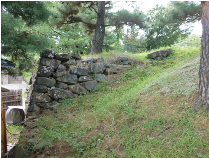
図版 2 着手前（東から）
