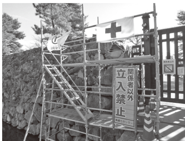
4. 本丸北外堀南面石垣 D区間 石垣状況
