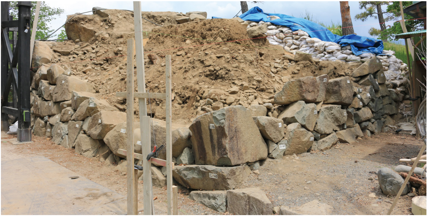
図版 13 解体完了（南西から）
