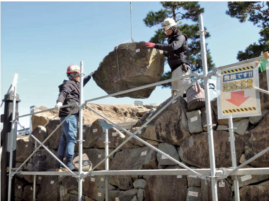
図版 31 積み直し（築石） 解体時同様に、大型クレーンを使用し、一石ずつ慎重に積み直しを行った。
