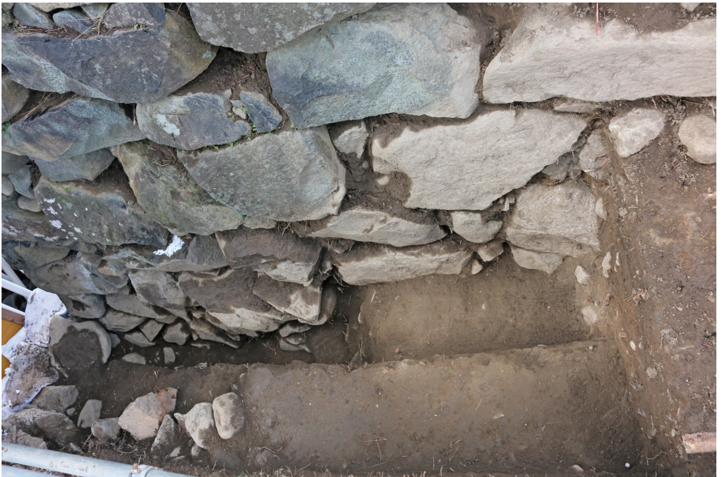
図版 20 H28 年度発掘② 石垣食い違い 石垣東面埋没部の築石に、積み直しの跡と考えられる食い違いが生じている部分が確認された。
