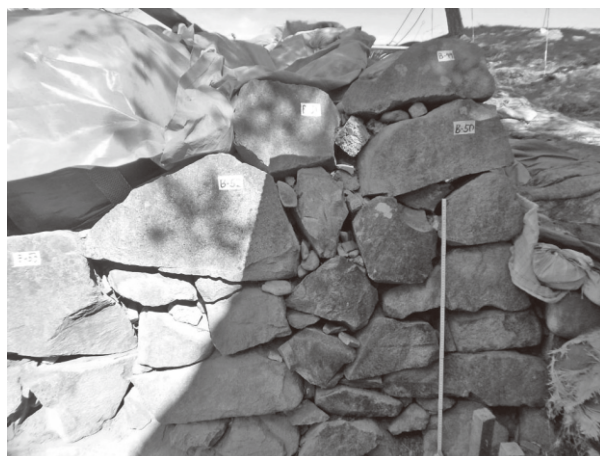
2. 本丸北外堀南面石垣 B区間 石垣状況 スケールの長さは1m
