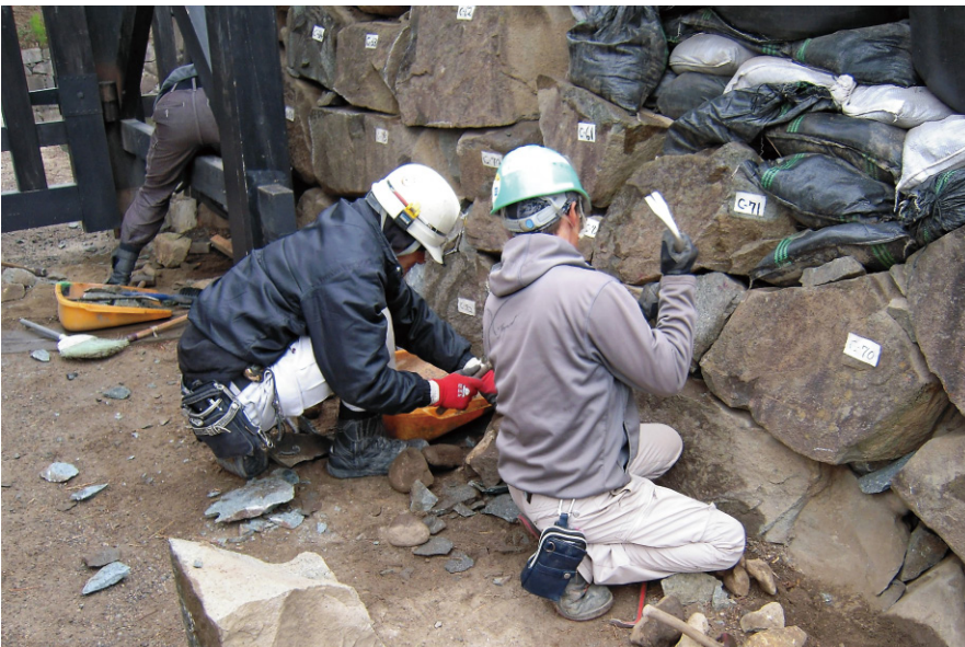
図版 12 間詰補足工事 解体しない石垣の範囲には間詰石の補充を行った。 新たな間詰石は見えない部分に着色を行い、新補 石材であることがわかるようにした。
