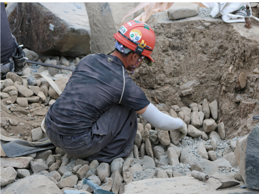
図版 32 積み直し（栗石手詰め） 裏込めの密度が 1.9t/m 3 以上になるよう、丁寧に栗石を敷き詰めた。
