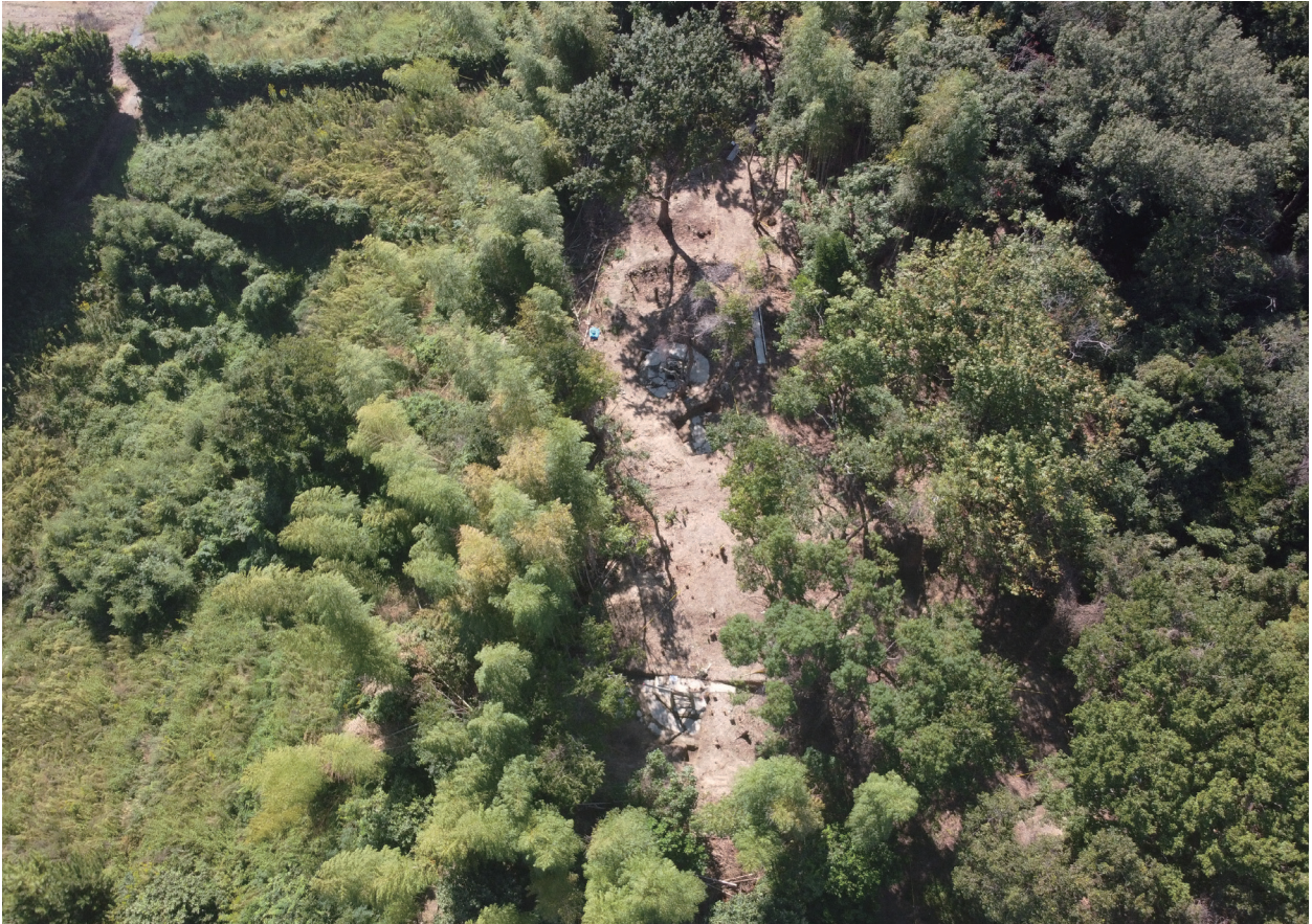
第 5 砲座 (手前) と第 4 砲座 (中央上) を望む ドローンからの撮影
