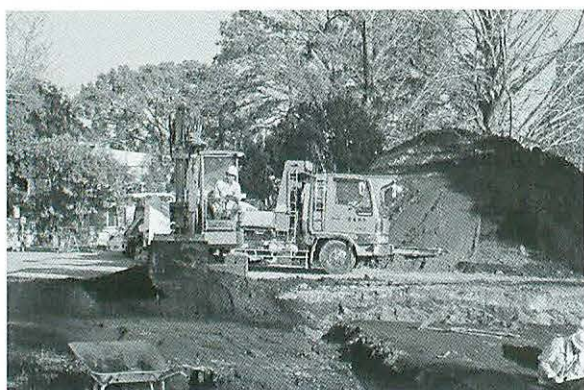
写真2 一次掘削風景（西より）
