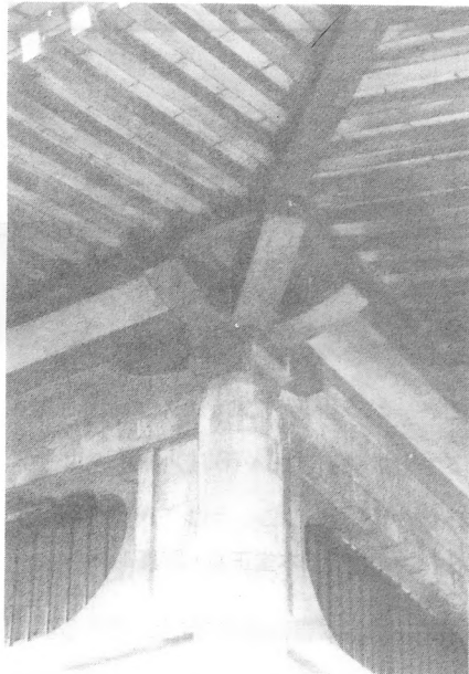
柱の状況 - 写真 139
