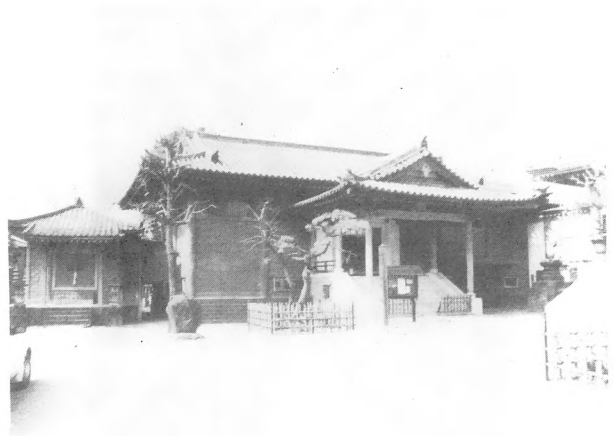
橋林寺旧本堂正面 - 写真 138
