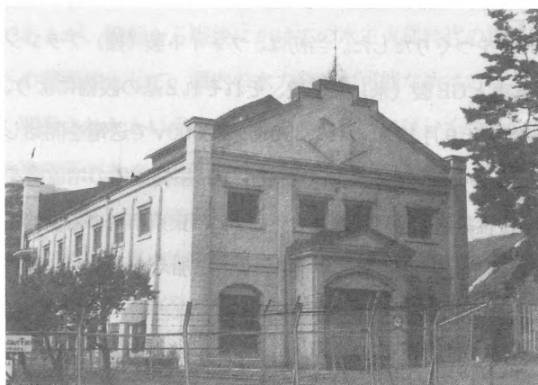
岩室発電所建屋 - 写真 75
