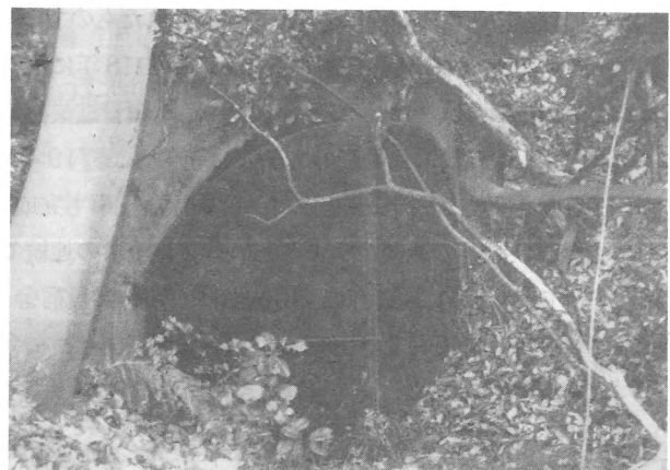
旧坑道入口 - 写真 80
