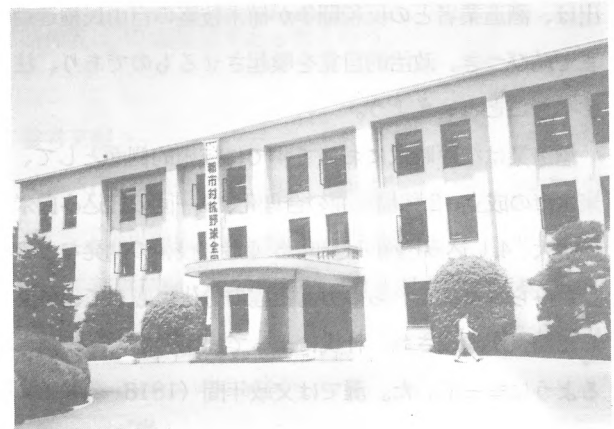
本館正面 - 写真85
