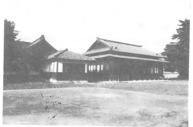
建物南側 - 写真125
