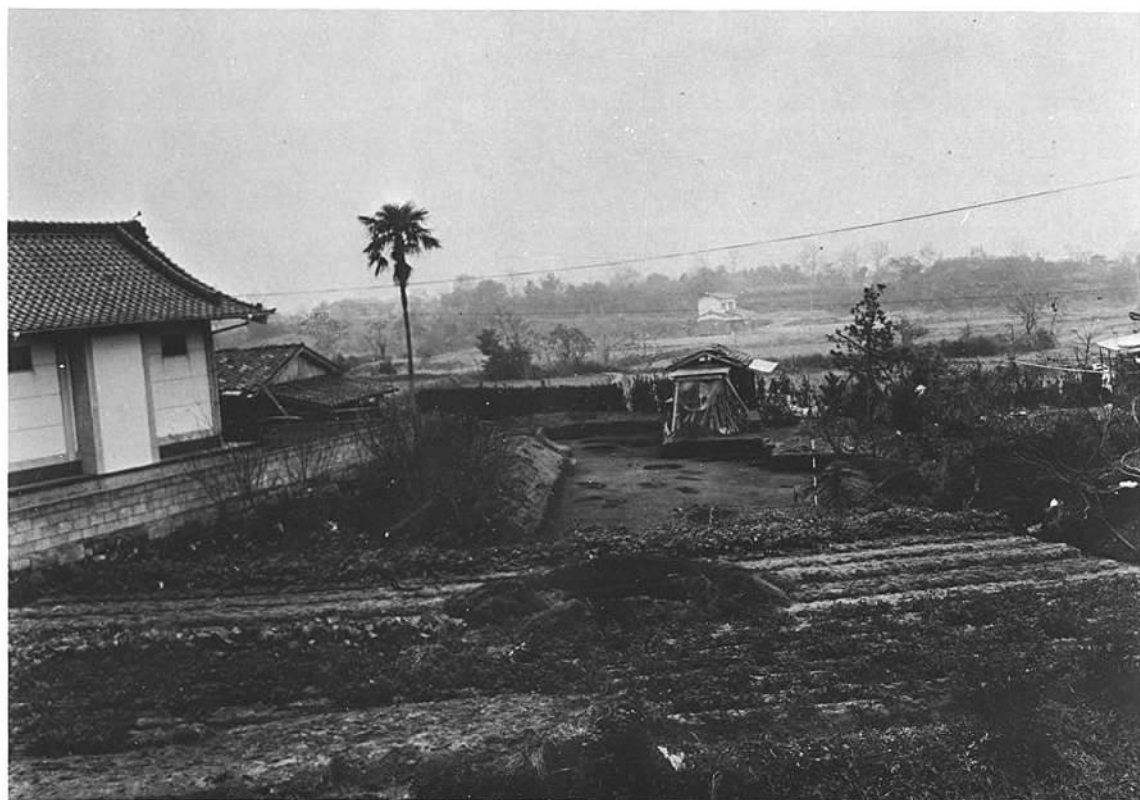
1 A区遺構全景
