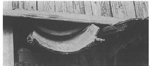
写真2 同上 漏斗谷の樋を下から見る
