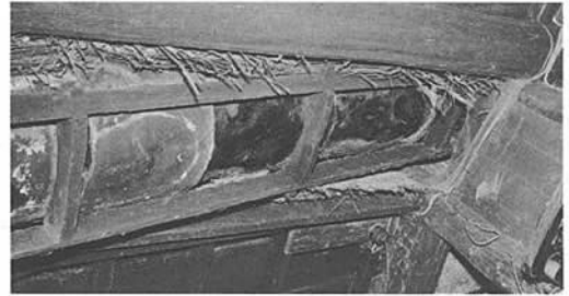
写真1 柳川市旧十二丁松藤キヨ氏宅 漏斗谷の樋吐出口
