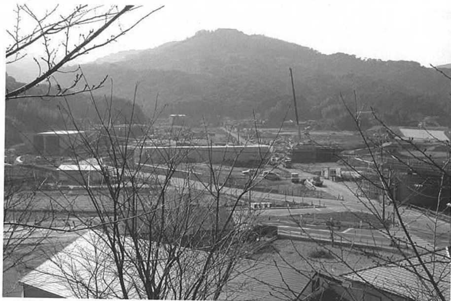
建設工事が進む苅田インターチェンジ（南西から）
