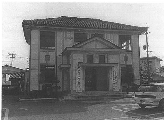
▲ 正面入口を望む (1993年撮影)
