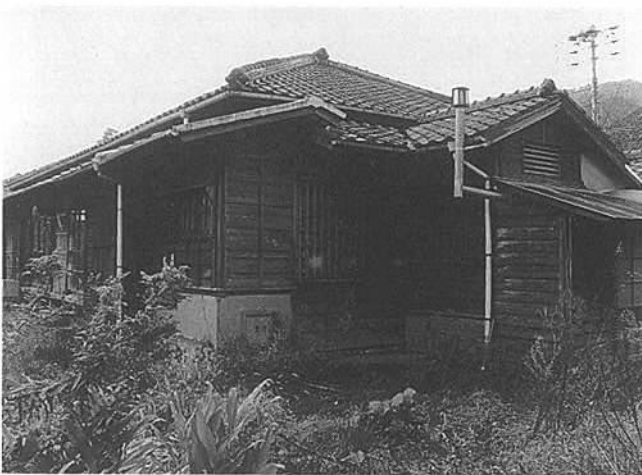
▲ 同上社宅の玄関側の状態 (1992年撮影)
