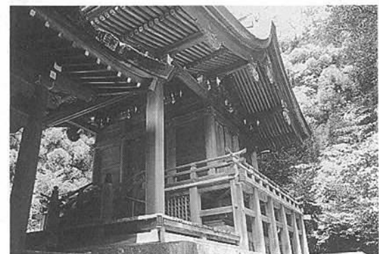
◀本殿と屋根の構造（1992年開田撮影）
