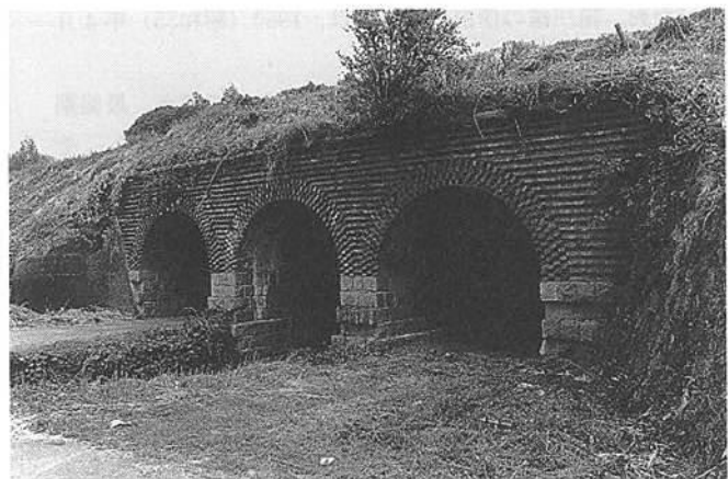
◀ 表面(右・煉瓦積)・裏面(左・切石積)の状況(1992年撮影)
