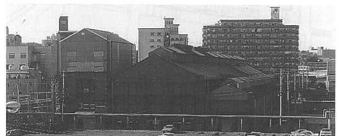
▲ 鉄工改造所（1993年）
