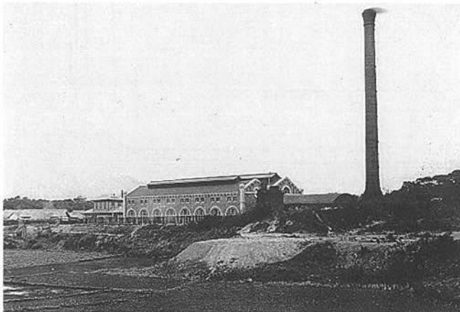
▲ 遠賀川水源地の汽動ポンプ室 (1910年撮影「八幡製鐵所土木史」による) 現在も使われているが、石炭を燃料とした汽動ポンプが、今は電動ポンプに変わり、それに伴い、煙突は不要となり撤去されている。
