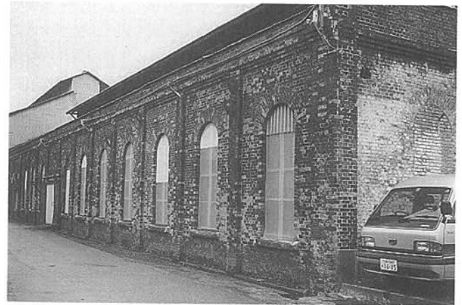
▲ 工場壁部分（1992年、平島撮影）
