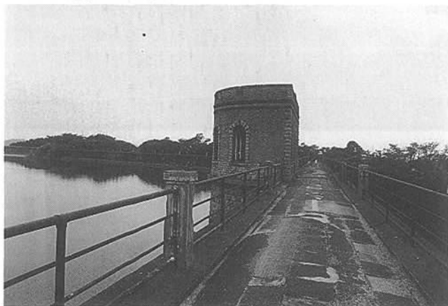
▲ 取水塔 (1992年開田撮影)
