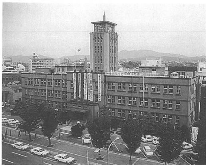
▲ 市庁舎全景 (1992年、平島撮影)
