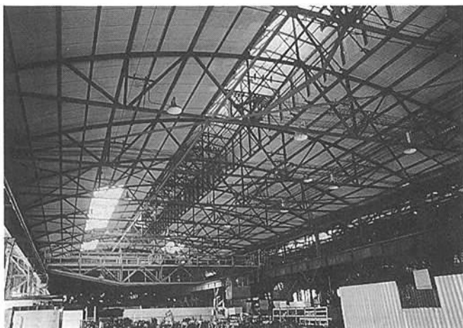
▲ 工場内部と天井の構造 (1992年開田撮影)
