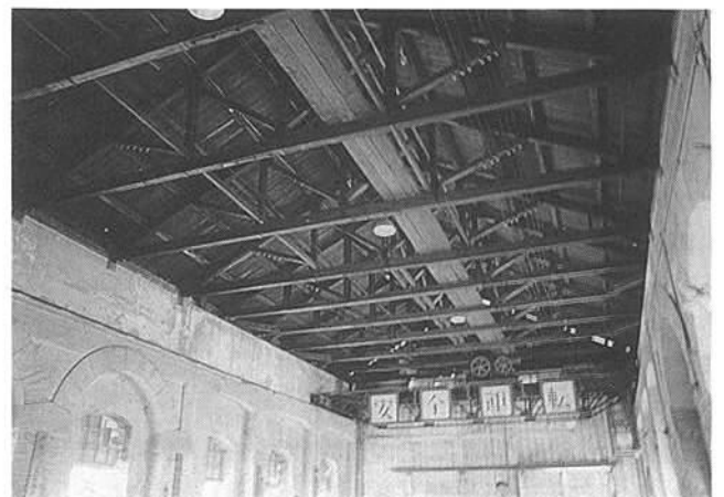
▲ ポンプ室屋根内部（1992年開田撮影）
