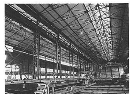
▲ 工場外壁と内部 (1992年開田撮影)
