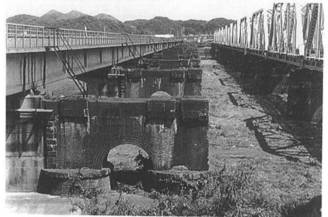
▲ 河川敷内の橋脚 (1992年撮影)
