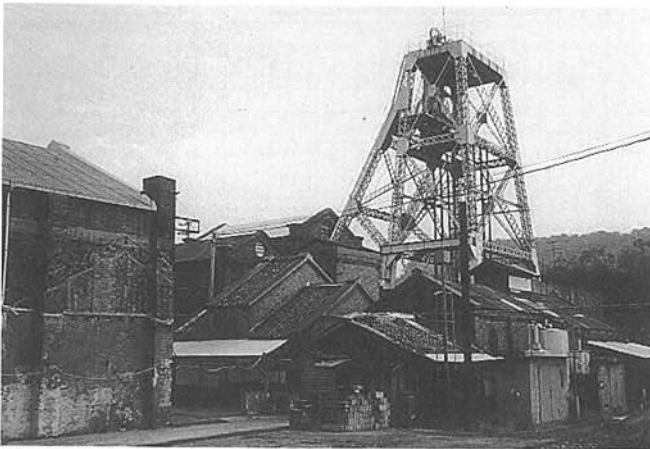
▲ 二坑立坑槽（1991年撮影）
