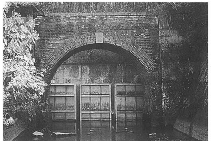
▲ 水門全景(1992年、平島撮影)
