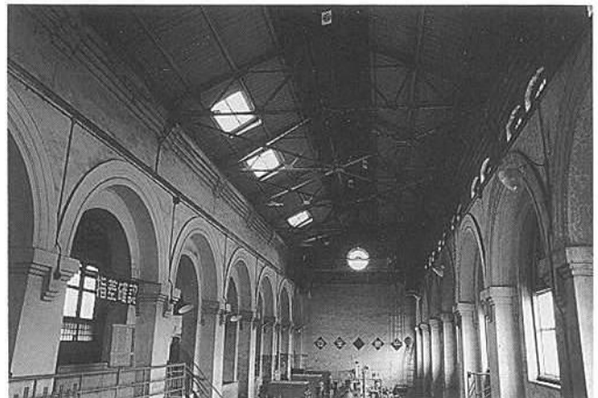
▲ ポンプ室内部（1992年開田撮影）
