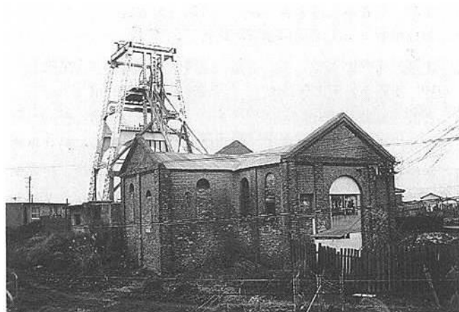
▲ 第二坑捲上機械室と櫓（1992年、平島撮影）
