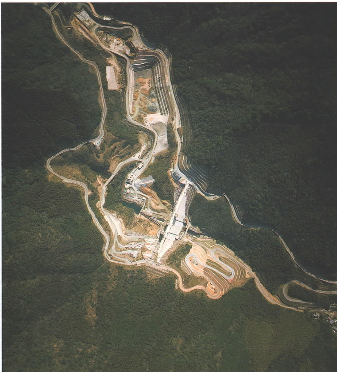
福智山ダム全景（内ヶ磯窯跡保存工完成後）
