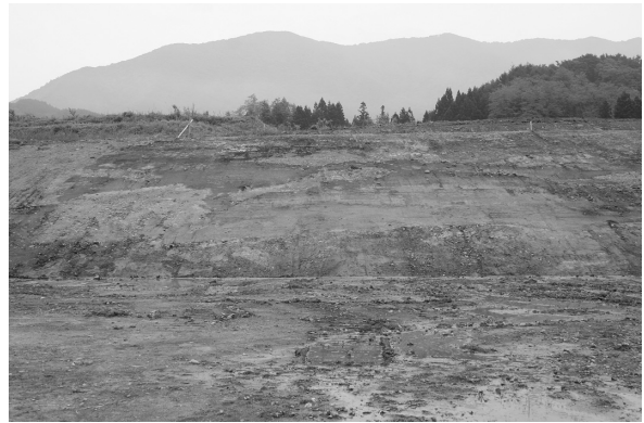
写真A 工事中の法面(西から)
