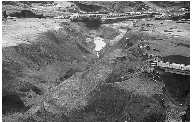
堀区 谷完掘 E→
